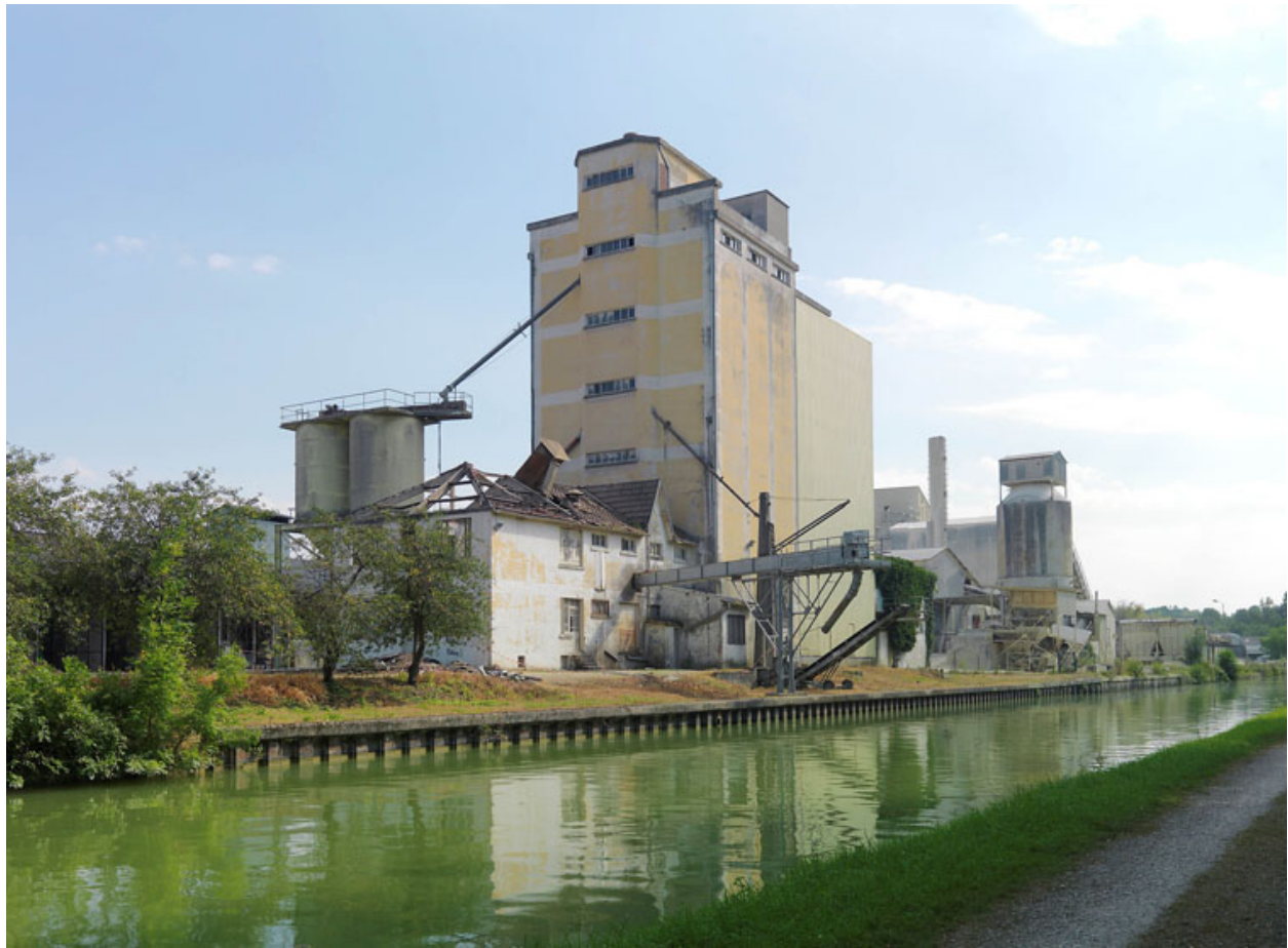
Silo vu du canal du Loing.
