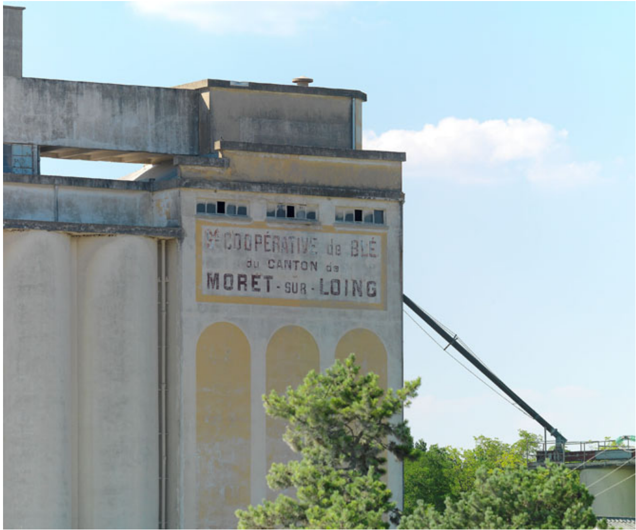
Vue extérieure du silo. Inscription sur le bâtiment "Coopérative de blé du canton de Moret-sur-Loing"
