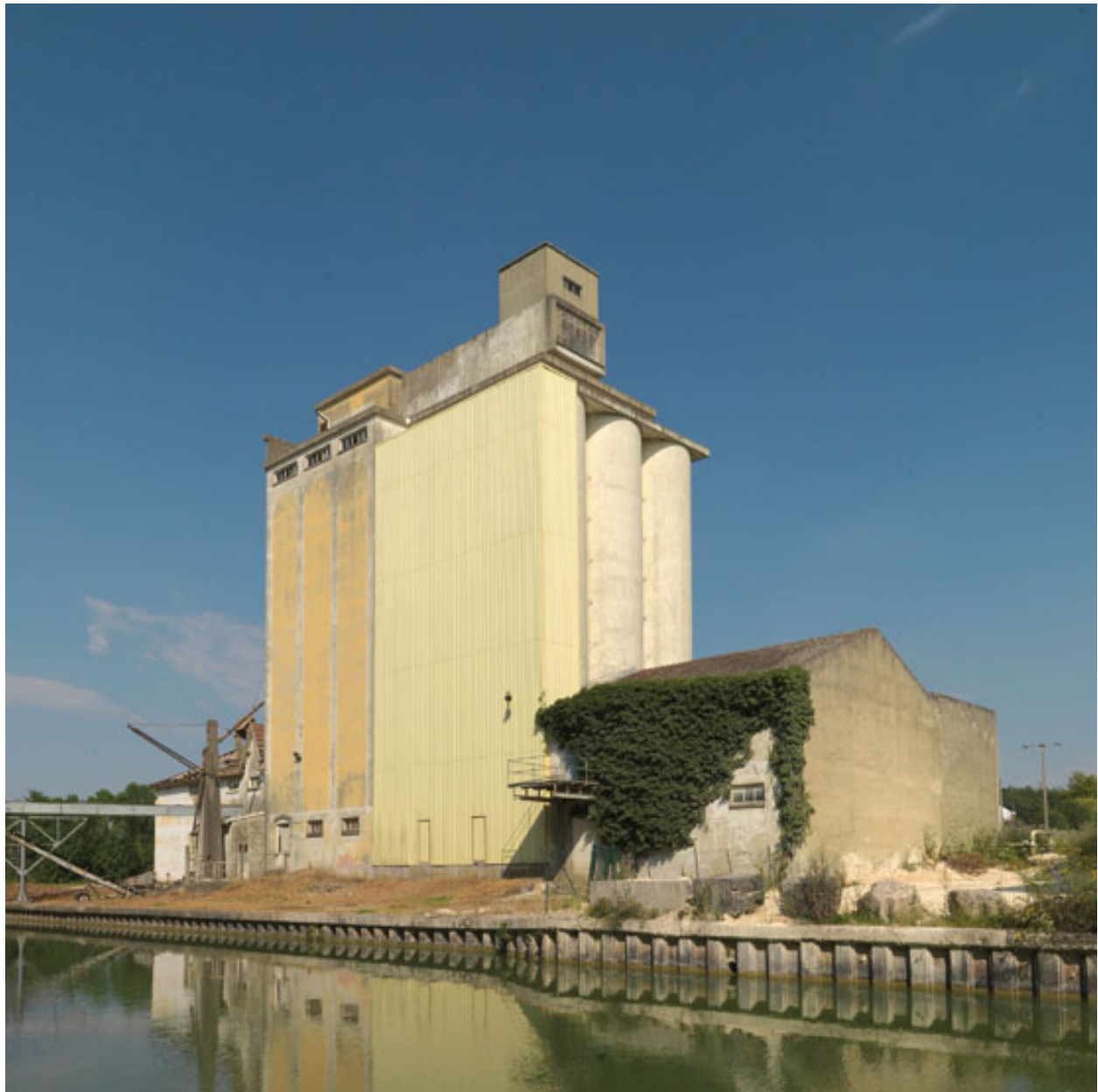
Silo vu du canal du Loing.
