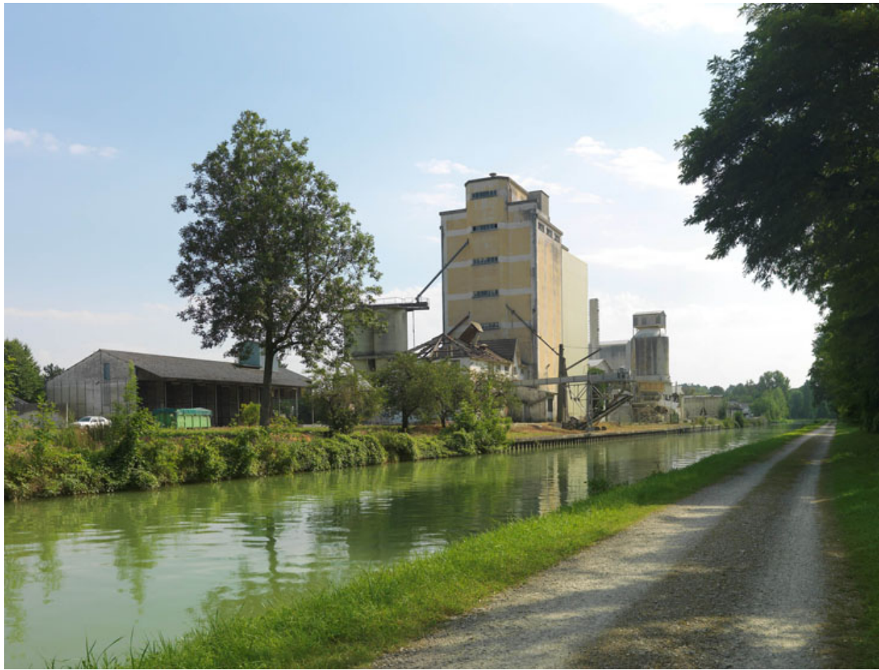
Silo vu du canal du Loing.
