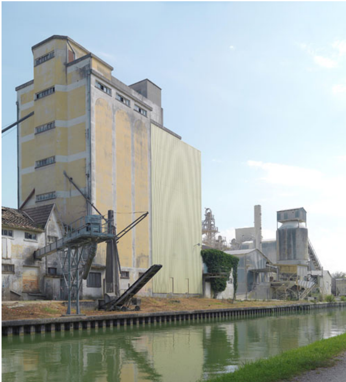
Silo vu du canal du Loing.
