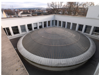
Vue de l'extrados de la coupole en dalle de verre. Phot. Laurent Kruszyk IVR11_20157800617NUC4A
