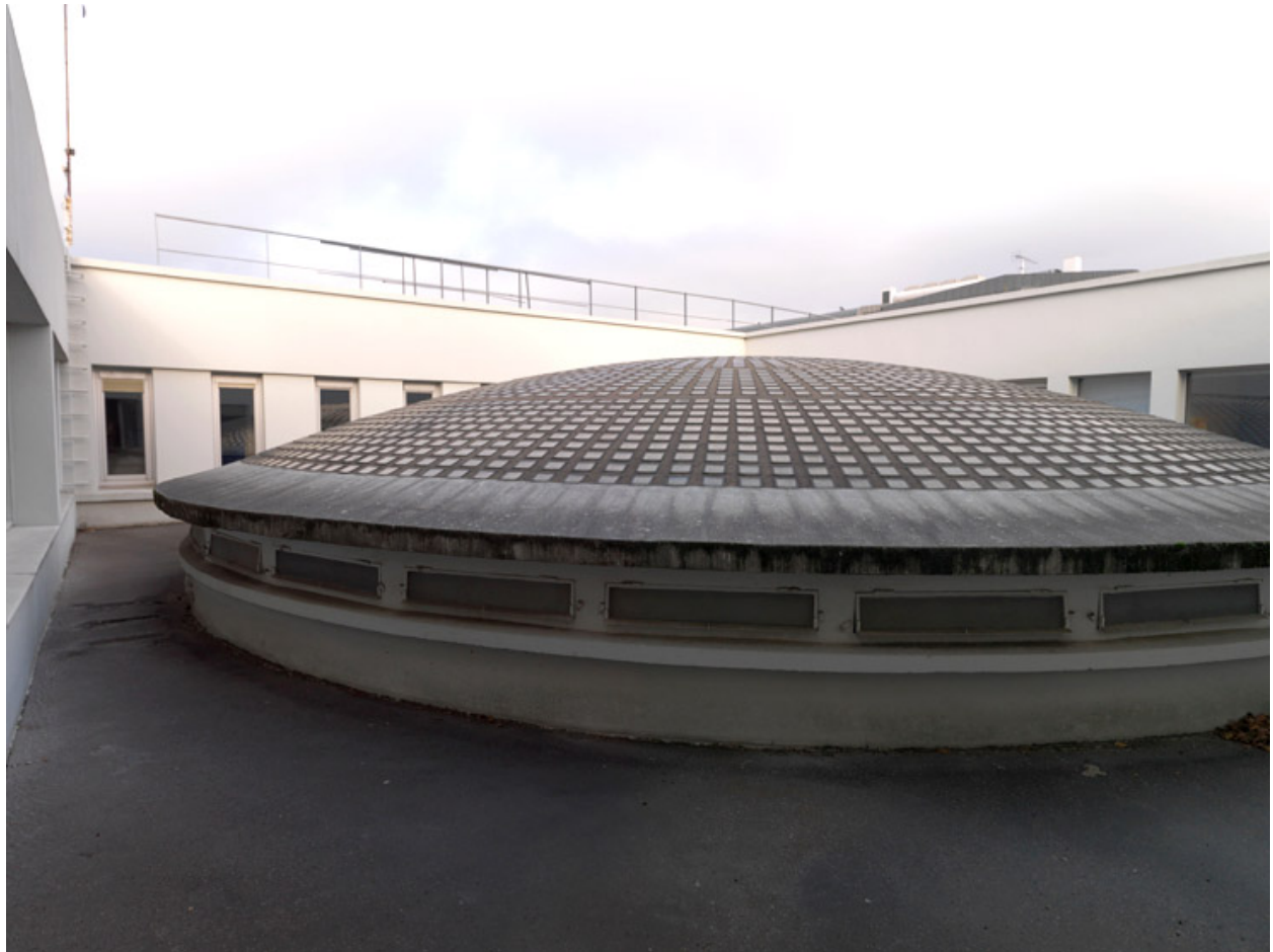
L'extrados de la coupole et son environnement.
