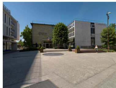
Vue d'ensemble de l'hôtel de ville depuis la rue Gambetta. À gauche le bâtiment de 1948 et à droite l'extension de 1969. Phot. Laurent Kruszyk IVR11_20157800325NUC4A
