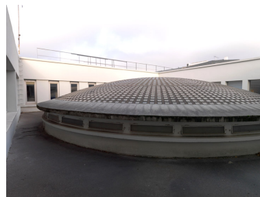
L'extrados de la coupole et son environnement. Phot. Laurent Kruszyk IVR11_20157800618NUC4A
