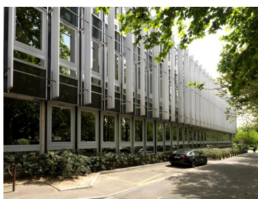
La façade sud faisant partie de l'extension comporte des lames brise-soleil en tôle d'aluminium.
