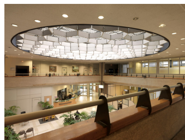
Le hall du public du premier bâtiment. Vue d'ensemble. La coupole a été dotée, sans doute dans les années 1970, d'une sorte de résille destinée à amortir les bruits. Phot. Laurent Kruszyk IVR11_20157800616NUC4A
