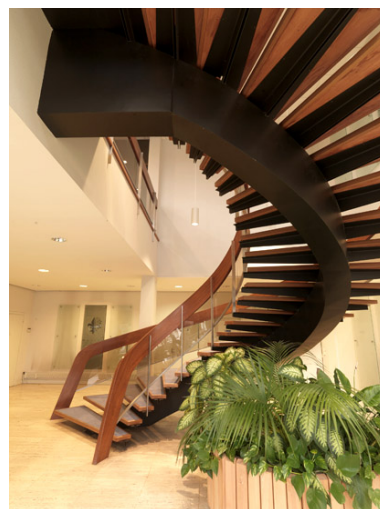
Vue de l'escalier en contre-plongée. On voit la crémaillère centrale portant un escalier en échelle de perroquet. Phot. Laurent Kruszyk IVR11_20157800610NUC4A
