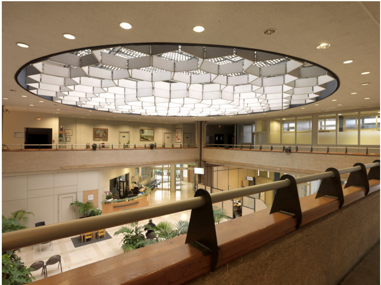
Le hall du public du premier bâtiment. Vue d'ensemble. La coupole a été dotée, sans doute dans les années 1970, d'une sorte de résille destinée à amortir les bruits.
