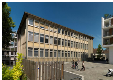
La façade nord du bâtiment de 1948. Phot. Laurent Kruszyk IVR11_20157800327NUC4A
