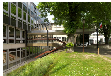
La façade nord de l'extension comporte l'entrée d'honneur marquée par un grand auvent métallique.
