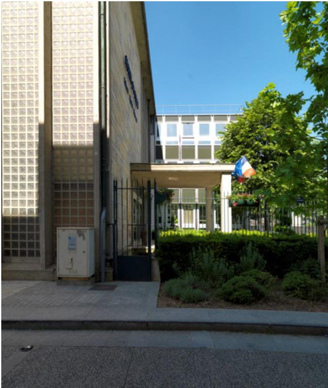
Détail de la façade nord du bâtiment de 1948. On voit une paroi en pavés de verre.
