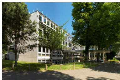
Vue d'ensemble de la façade nord de l'extension de 1969.
