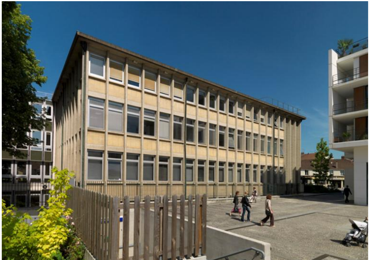
La façade nord du bâtiment de 1948.
