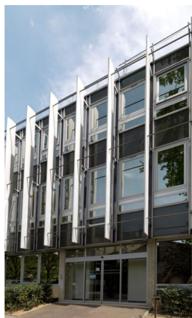
Les lames brise-soleil de l'extension sont fixées à 40 cm de la façade.
