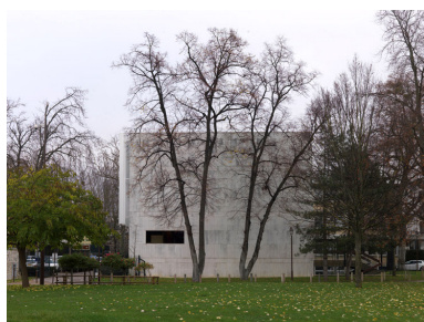
La façade sud de l'extension. La fenêtre rectangulaire du rez-de-chaussée était celle du bureau du maire. Phot. Laurent Kruszyk IVR11_20157800598NUC4A
