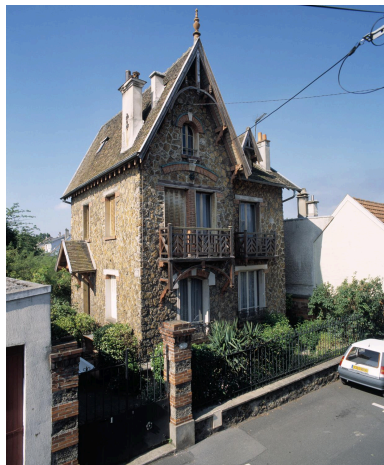
Vue d'ensemble. Phot. Philippe Ayrault IVR11_20029101047XA
