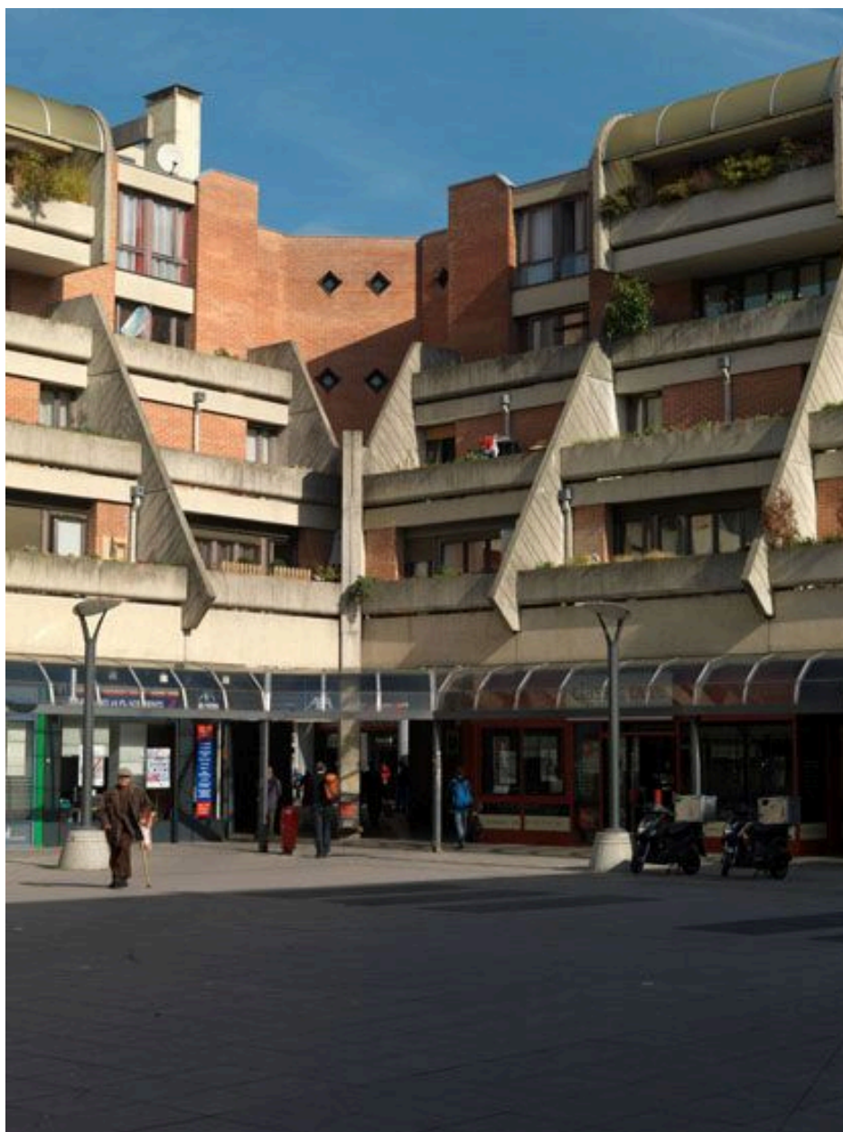
Vue d'ensemble des immeubles sur le square donnant sur la Grand'Place.
