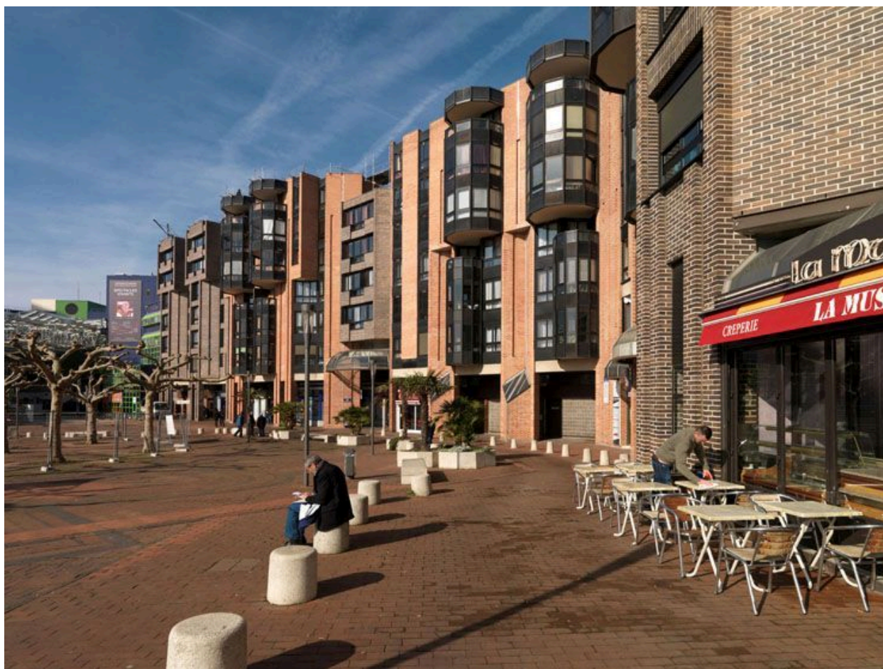
Vue d'ensemble des immeubles de la Grand'Place aux n°3, 6, 9 et 12.
