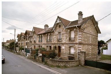
Façade principale sur rue. Phot. Laurent Kruszyk IVR11_20067800448XA
