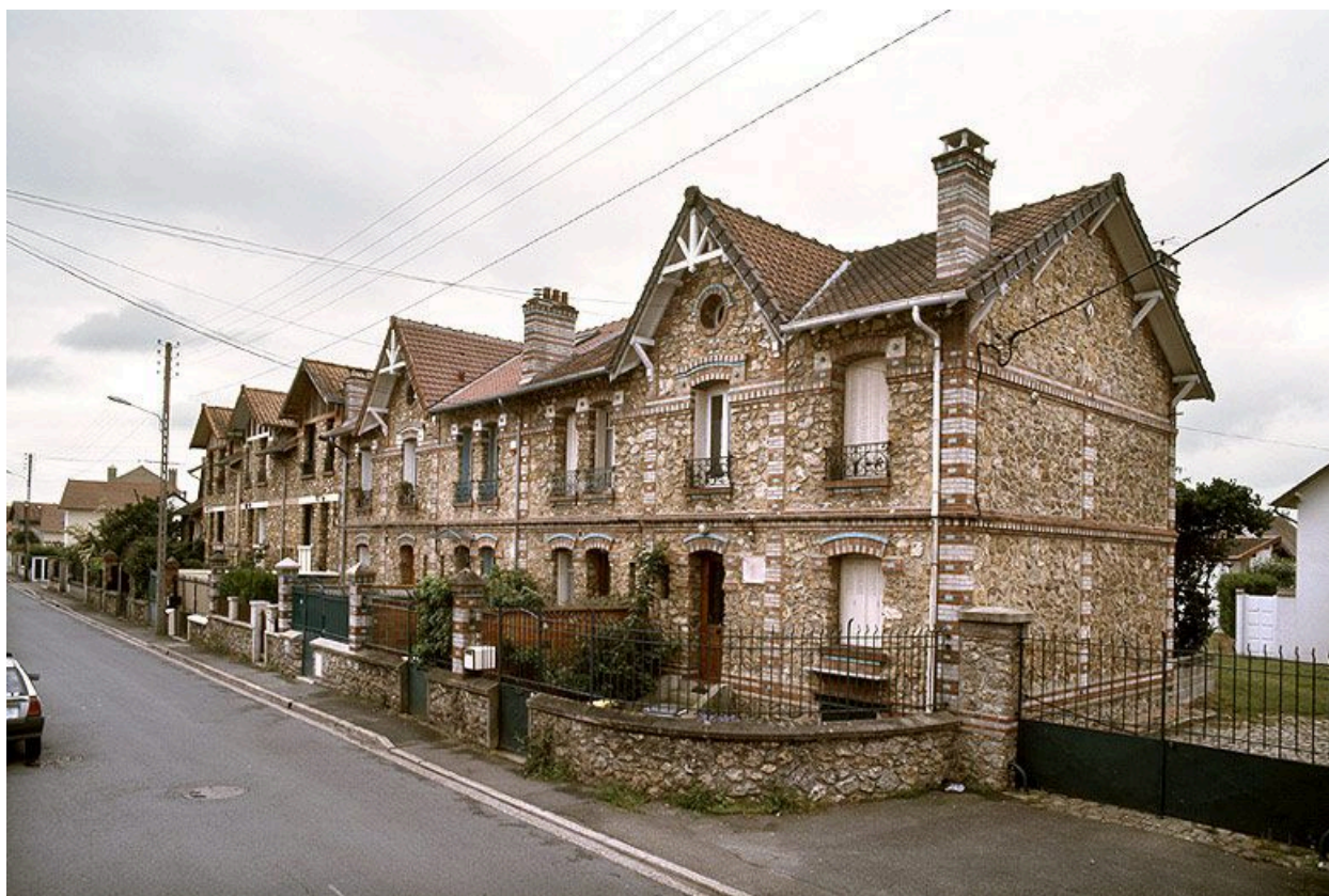
Façade principale sur rue.
