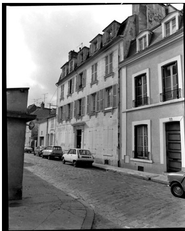
Vue de la façade sur rue en 1977. Phot. Pascal Corbière IVR11_19777800793X
