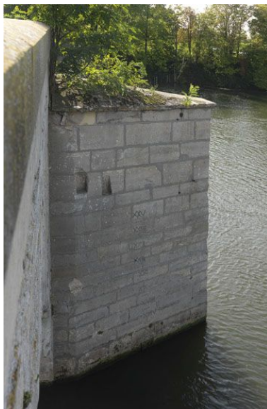
Pile en éperon du vieux pont de Limay vue depuis le pont vers l'aval. On peut apercevoir une échelle de crue gravée en chiffres romains sur cette dernière.
