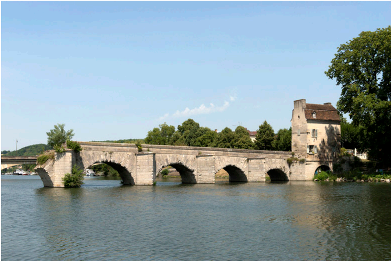
Les arches du côté de Limay et les vestiges de l'arche détruite.
