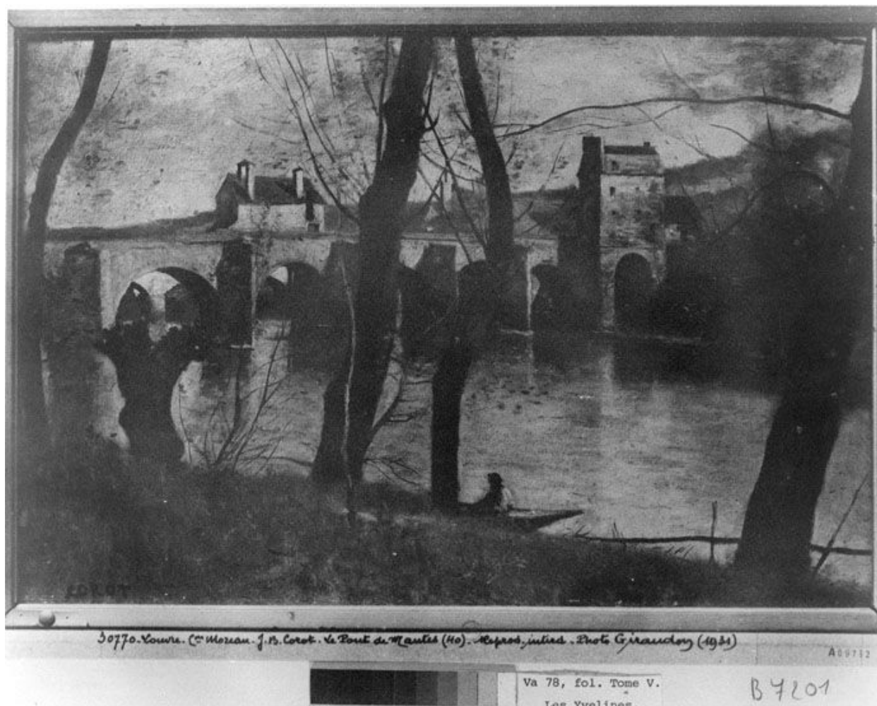
Le pont de Mantes. Photographie, 1941. (BNF. Va 78, fol., tome V, Yvelines, B 7201). Vue du vieux pont de Limay vers l'aval depuis les berges d'une île, avec la maison du passeur sur la droite vers 1868-1870.
