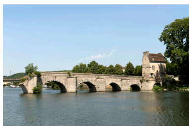
Les arches du côté de Limay et les vestiges de l'arche détruite. Phot. Laurent Kruszyk IVR11_20167800123NUC4A
