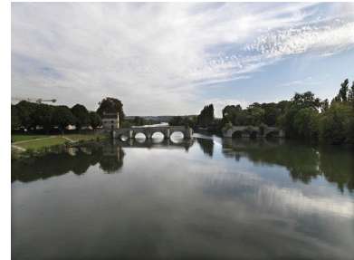
Vue générale du vieux pont de Limay depuis le tronçon du Pont Neuf de Mantes situé entre Limay et l'île aux Dames. On aperçoit à gauche la maison du passeur.
