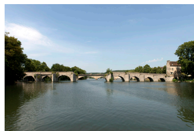
Vue d'ensemble du vieux pont. On aperçoit à l'arrière le nouveau pont. Phot. Laurent Kruszyk IVR11_20167800122NUC4A
