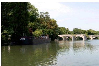
Les arches subsistant du côté de l'île aux Dames. Phot. Laurent Kruszyk IVR11_20167800121NUC4A
