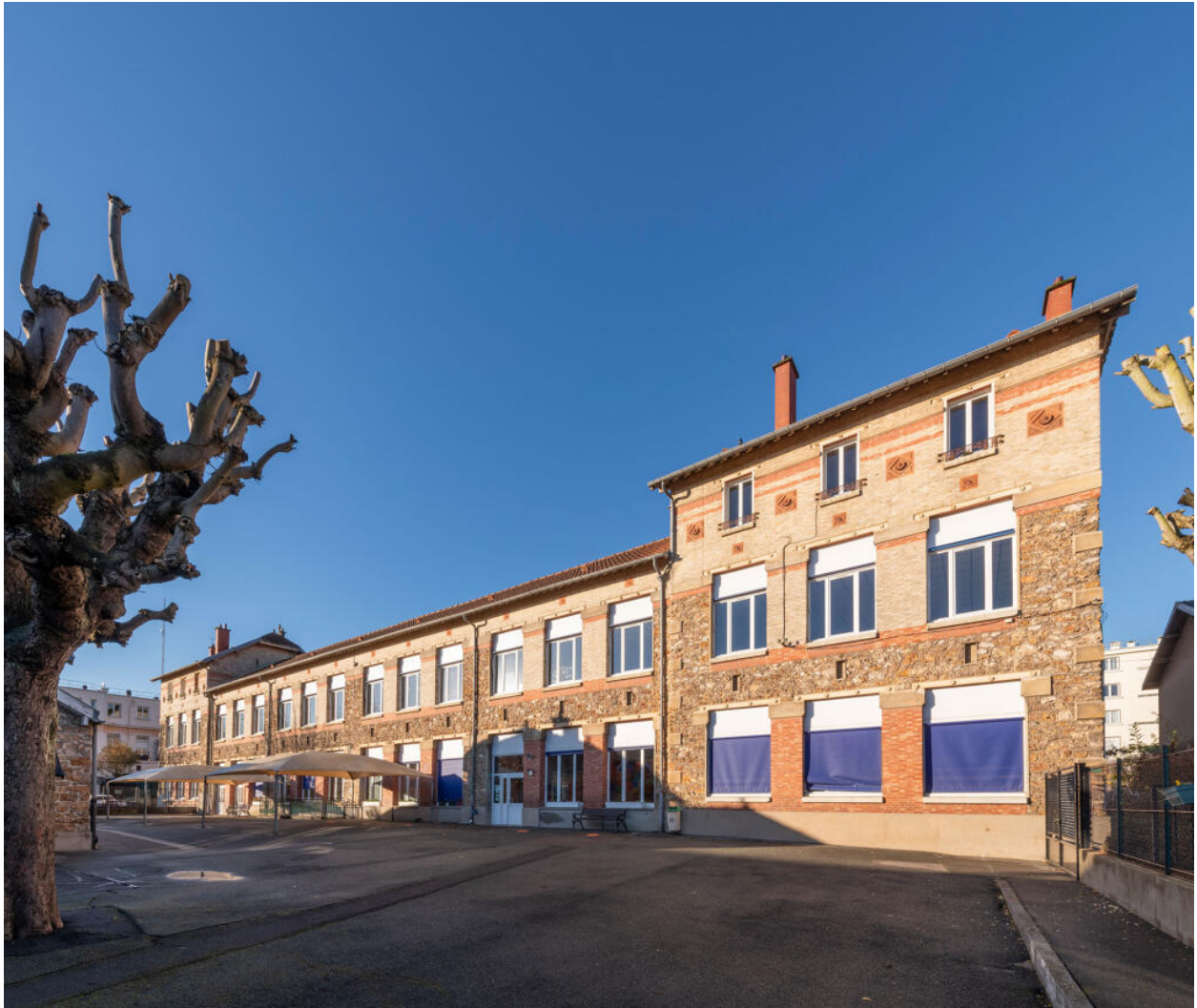
École Élémentaire de Montretout, bâtiment des classes, vue générale
