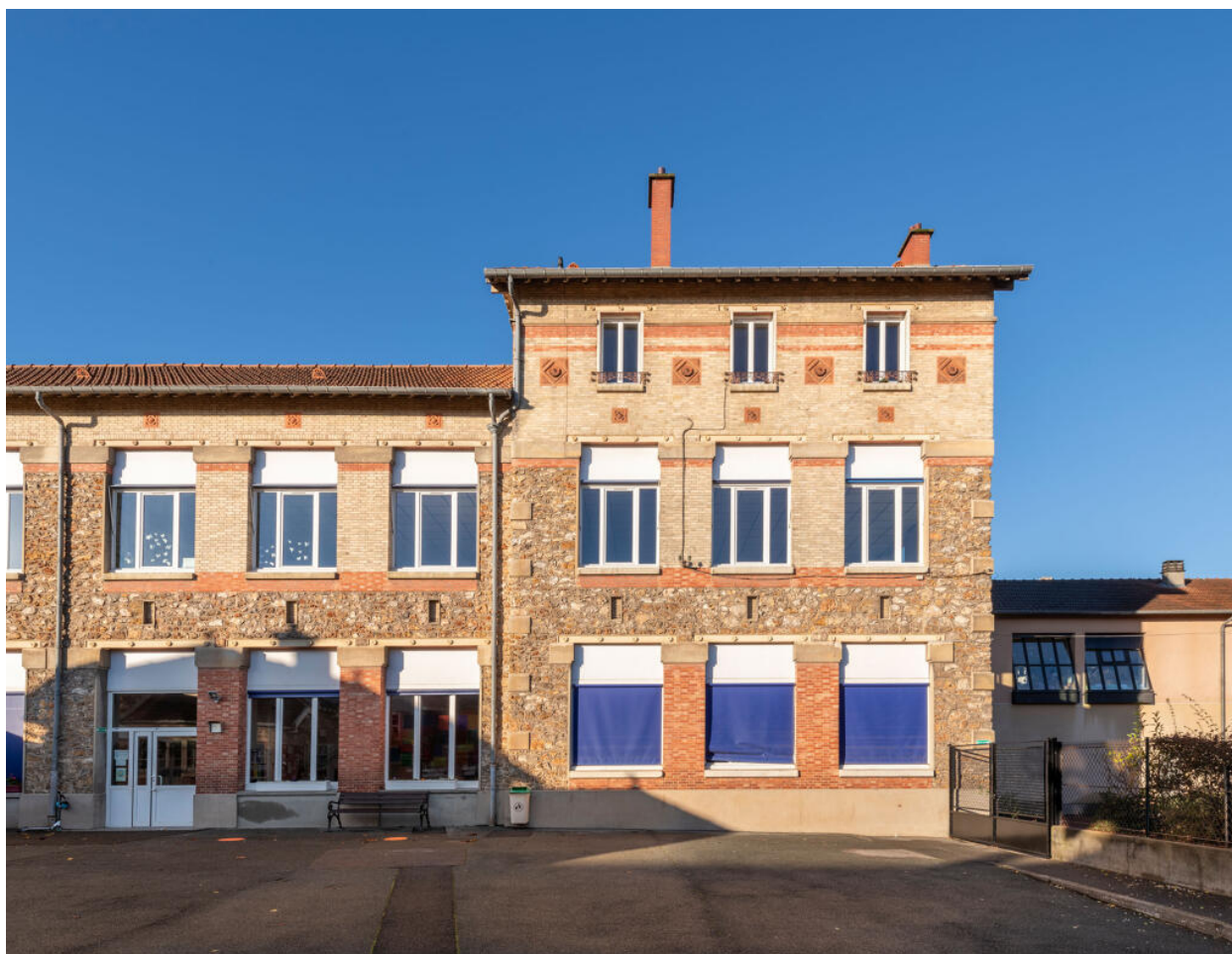
École Élémentaire de Montretout, ancienne école de filles
