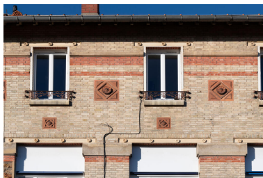
École Élémentaire de Montretout, détail des décors de briques et de céramiques, rosettes et cabochons Phot. Kruszyk Laurent IVR11_20249200899NUC4A
