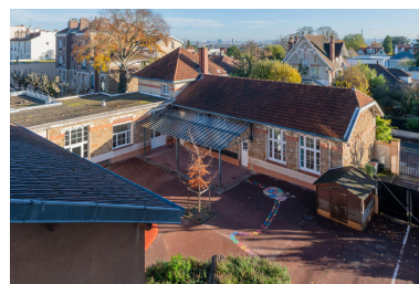
École maternelle de Montretout, vue générale depuis l'étage de l'école primaire Phot. Kruszyk Laurent IVR11_20249200893NUC4A
