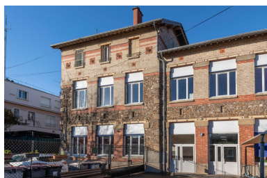
École Élémentaire de Montretout, ancienne école de garçons Phot. Kruszyk Laurent IVR11_20249200898NUC4A
