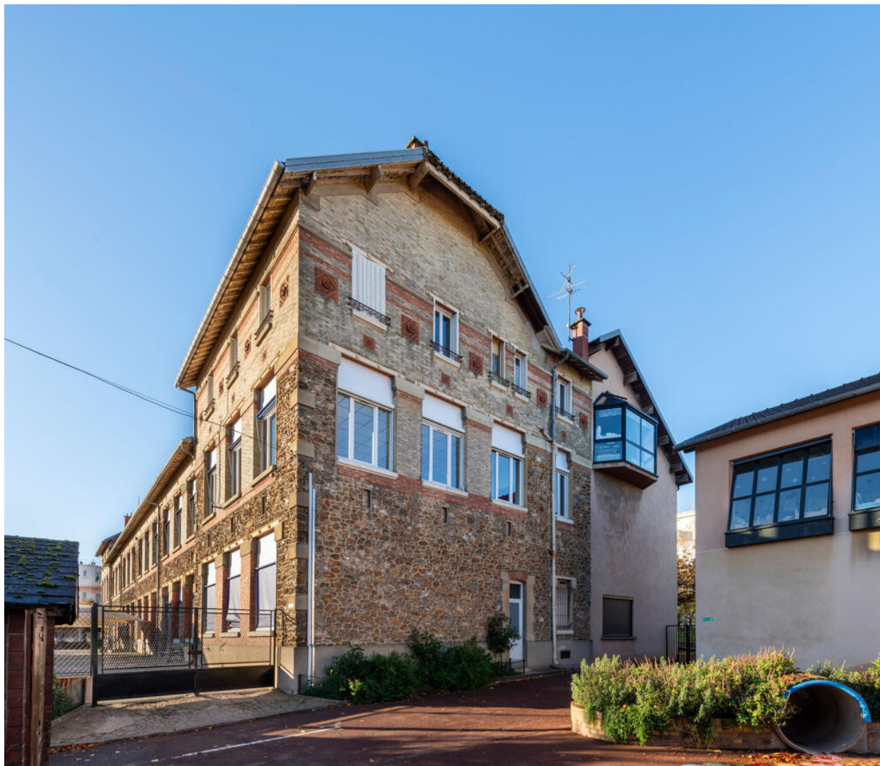
École Élémentaire de Montretout, bâtiment de 1908 et agrandissement des années 1980, vue du côté nord,
