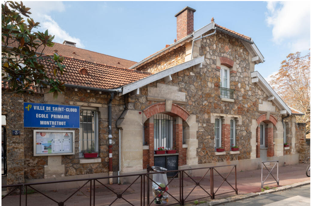
Ecole primaire de Montretout, pavillon d'entrée et ancien logement du concierge
