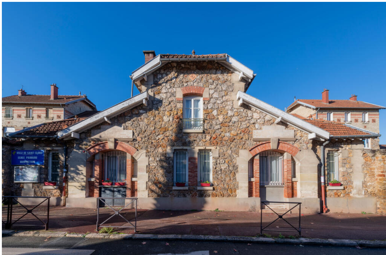
École Élémentaire de Montretout, pavillon d'entrée
