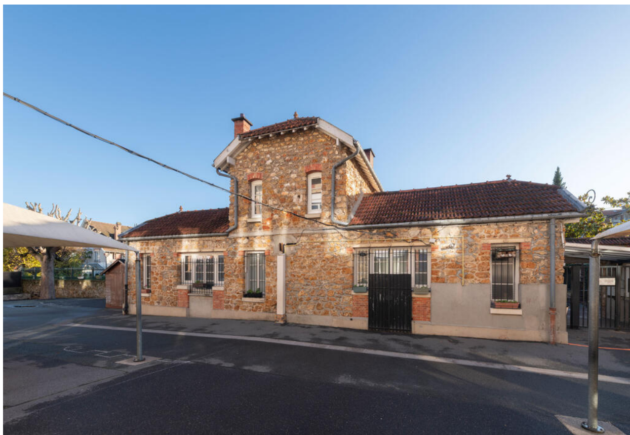
École Élémentaire de Montretout, pavillon d'entrée, vue depuis la cour
