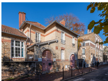
École maternelle de Montretout, pavillon de la direction, vue depuis la rue Phot. Kruszyk Laurent IVR11_20249200891NUC4A
