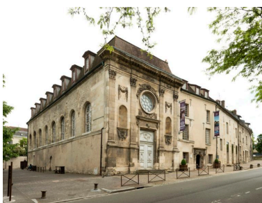
Vue d'ensemble des deux façades depuis la place de l'Étape.
