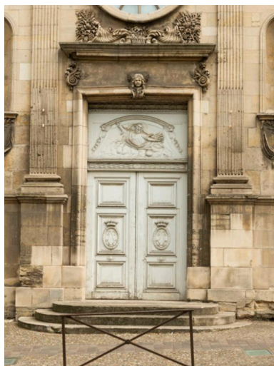
La porte d'entrée de la chapelle est une restauration récente. Phot. Laurent Kruszyk IVR11_20177800402NUC4A
