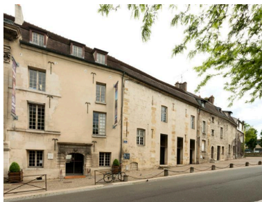
Vue d'ensemble des bâtiments depuis la porte d'entrée. Phot. Laurent Kruszyk IVR11_20177800398NUC4A
