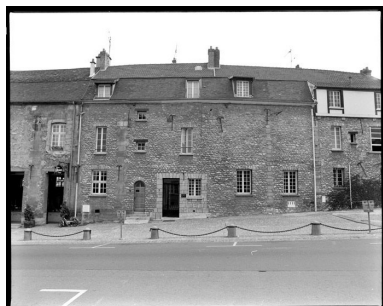
Vue de la façade sur la rue Thiers en 1977. L'enduit est déjà décroûté et les ouvertures reprises.
