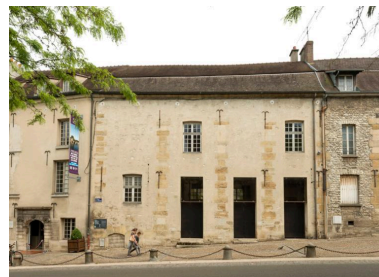
Partie inoccupée des bâtiments. Phot. Laurent Kruszyk IVR11_20177800399NUC4A
