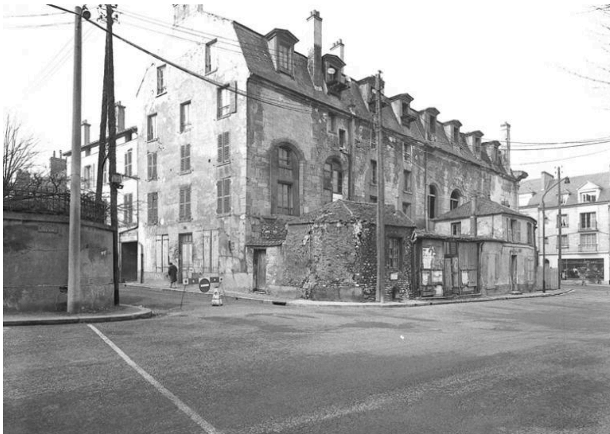
Le bâtiment en cours de restauration. On voit encore les adjonctions latérales qui ont été supprimées. (Fonds Bertin).
