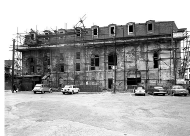
La façade sur la rue du Château en cours de restauration. (Fonds Bertin)
