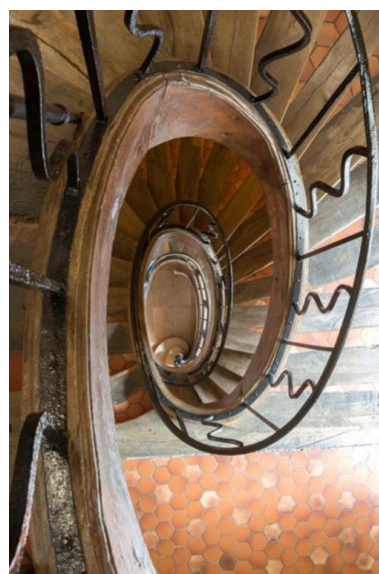
Vue en plongée de l'escalier dont le vide central forme un élégant ovale. Phot. Laurent Kruszyk IVR11_20177800440NUC4A
