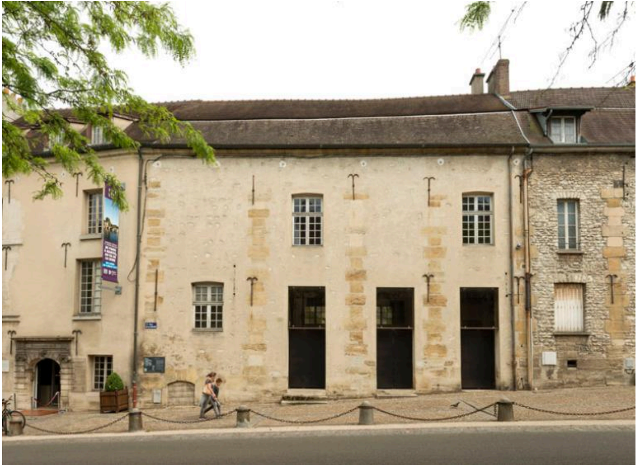
Partie inoccupée des bâtiments.
