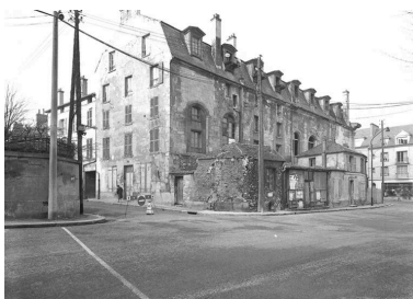
Le bâtiment en cours de restauration. On voit encore les adjonctions latérales qui ont été supprimées. (Fonds Bertin).
