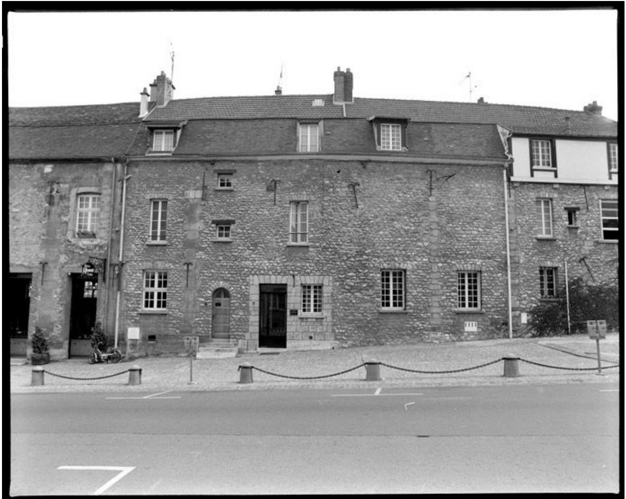
Vue de la façade sur la rue Thiers en 1977. L'enduit est déjà décroûté et les ouvertures reprises.
