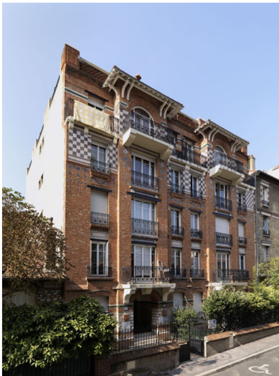
Vue d'ensemble de l'immeuble depuis la rue
