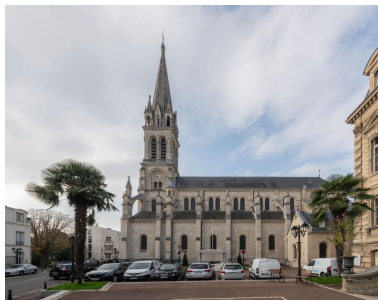
Eglise Saint-Clodoald, vue du flanc nord, depuis la place de la mairie Phot. Kruszyk Laurent IVR11_20249200352NUC4A
