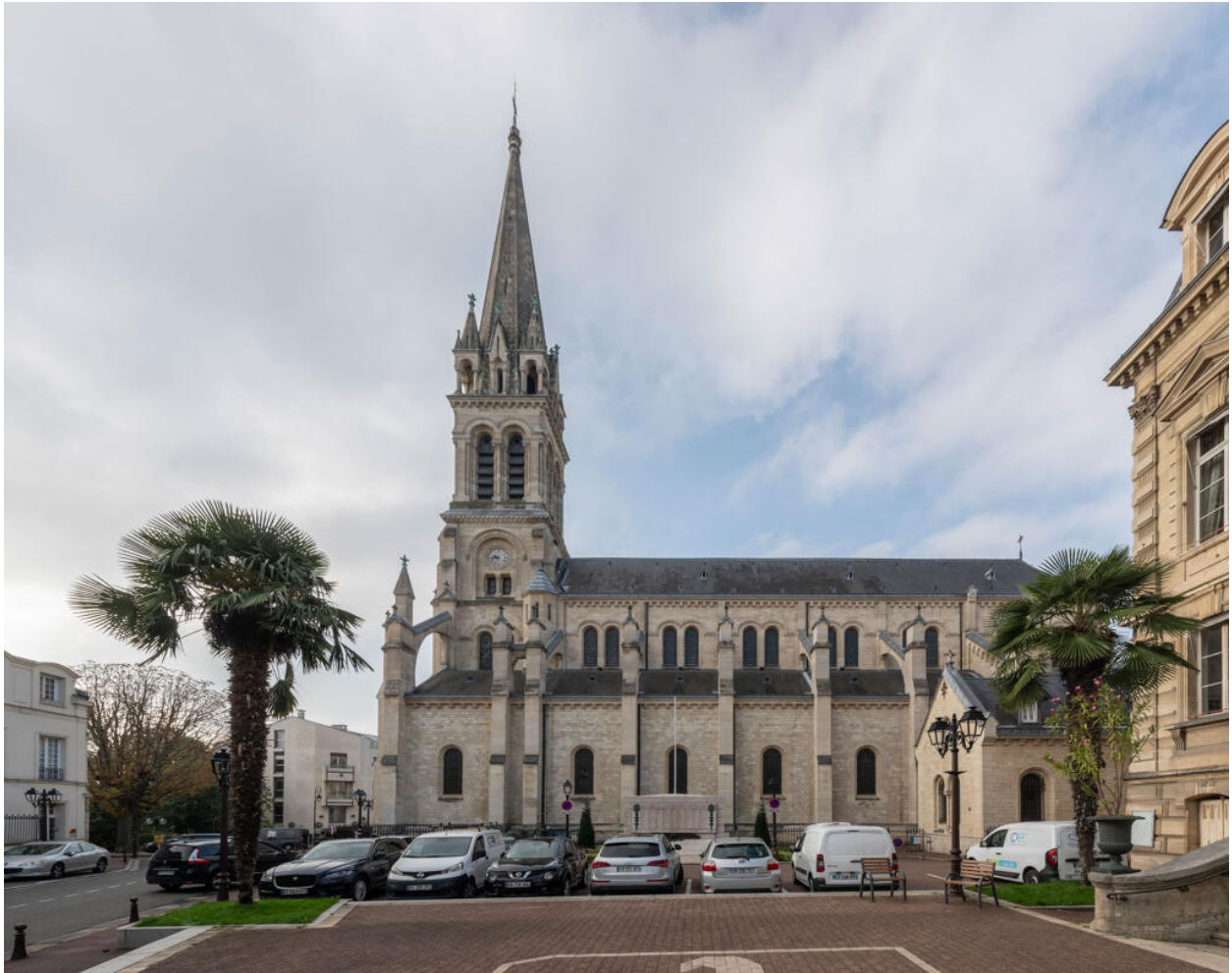
Eglise Saint-Clodoald, vue du flanc nord, depuis la place de la mairie
