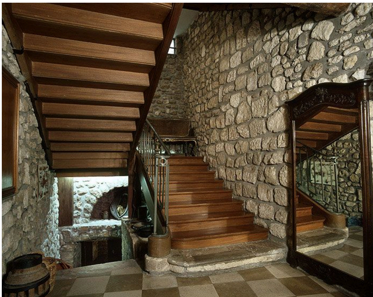
Vue de l'escalier.
