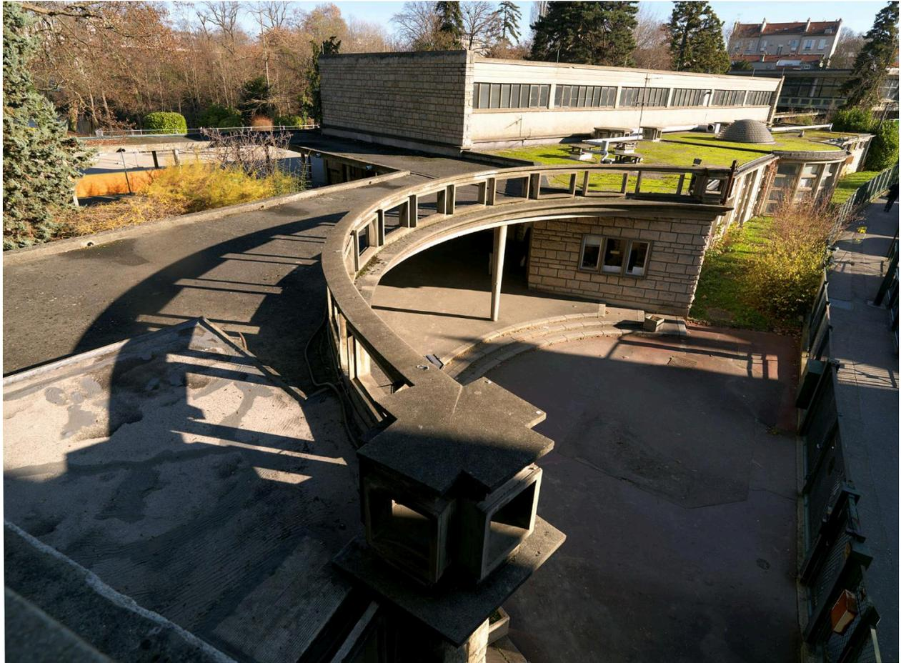
Les circulations abritées en béton laissé brut de décoffrage permettent de relier les différents bâtiments annexes et encadrent le théâtre de plein-air.
