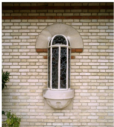
Petite fenêtre en saillie ornée de vitraux : vue extérieure. Phot. Laurent Kruszyk IVR11_20067800816XA
