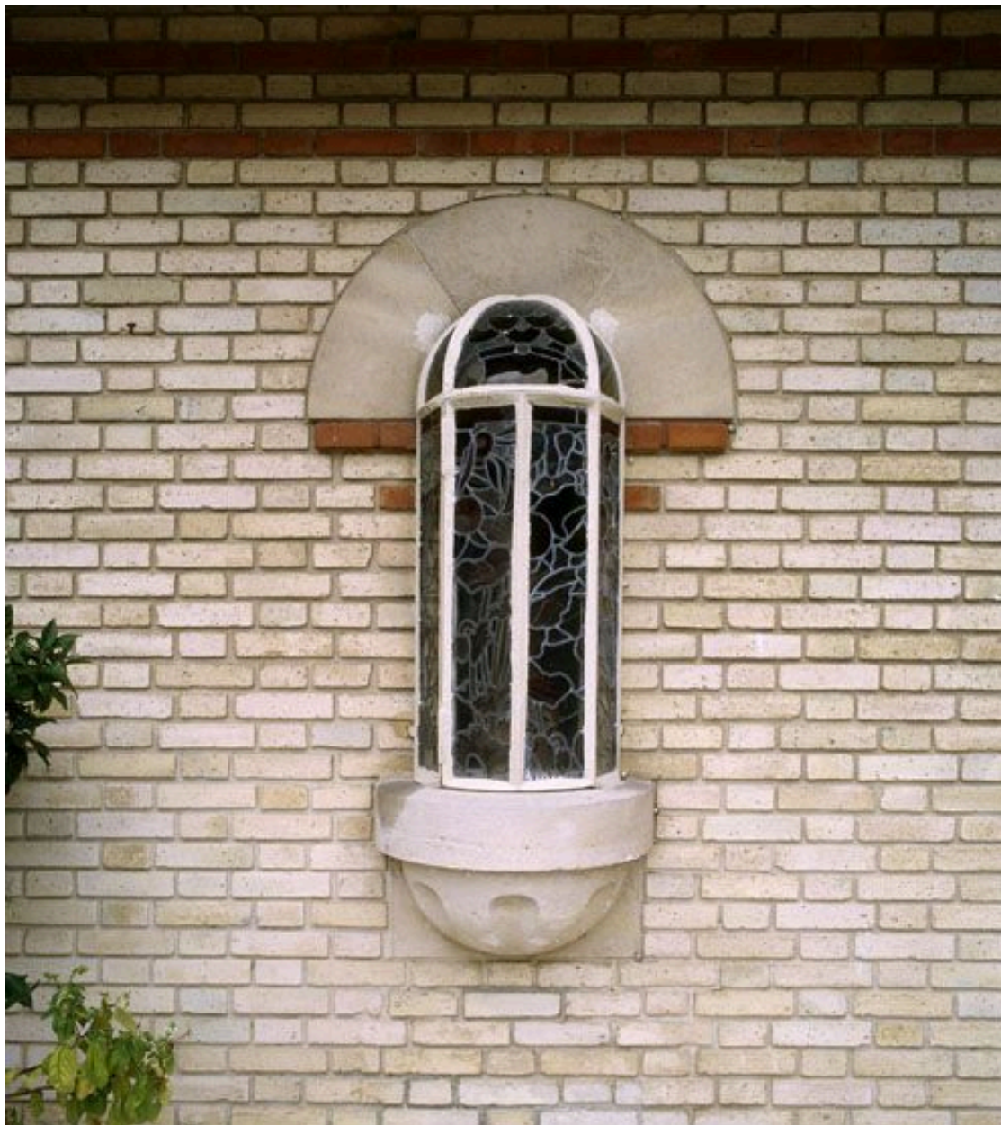
Petite fenêtre en saillie ornée de vitraux : vue extérieure.
