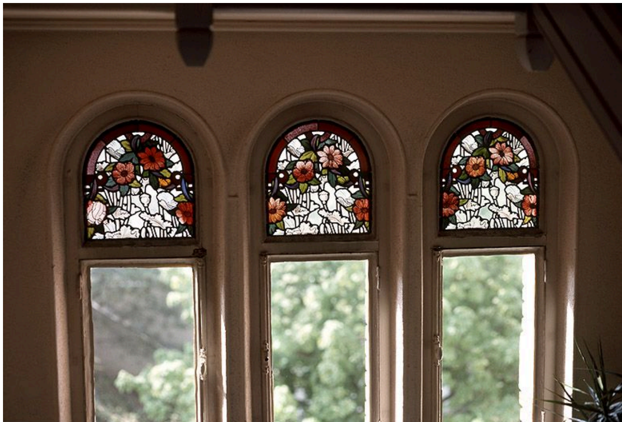
Vitraux éclairant l'escalier.
