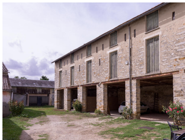
Vue générale du corps de bâtiment en retour sur la cour de l'ancien séchoir, depuis le sud-est. Phot. Asseline Stéphane IVR11_20259100917NUC4A
