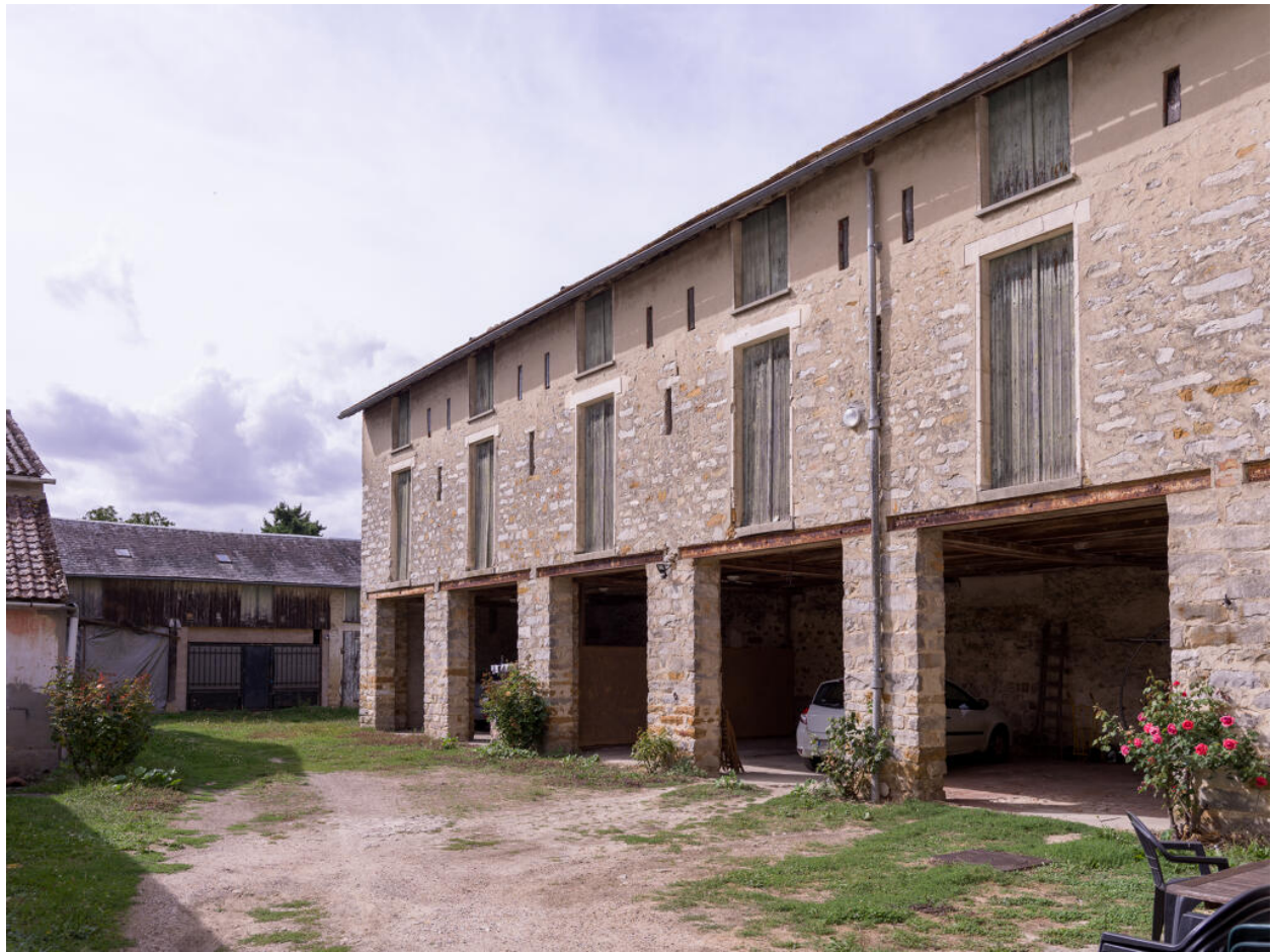
Vue générale du corps de bâtiment en retour sur la cour de l'ancien séchoir, depuis le sud-est.
