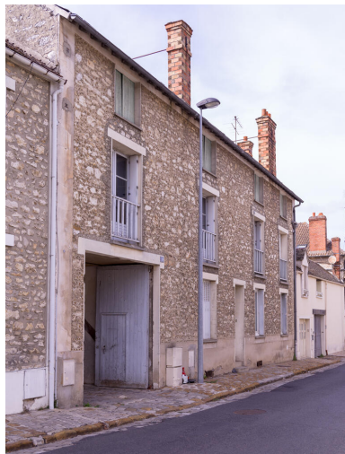
Vue générale du corps de bâtiment sur rue de l'ancien séchoir, depuis le sud-est. Phot. Asseline Stéphane IVR11_20259100916NUC4A
