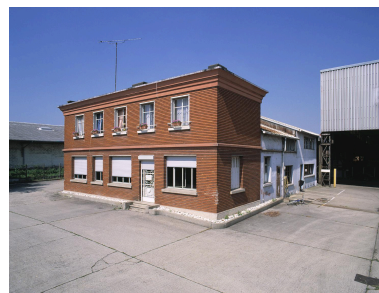
Etablissements Champion : vue d'ensemble du bâtiment à usage de logement, bureaux et garages construit en 1950. Phot. Philippe Ayrault IVR11_20039100960XA
