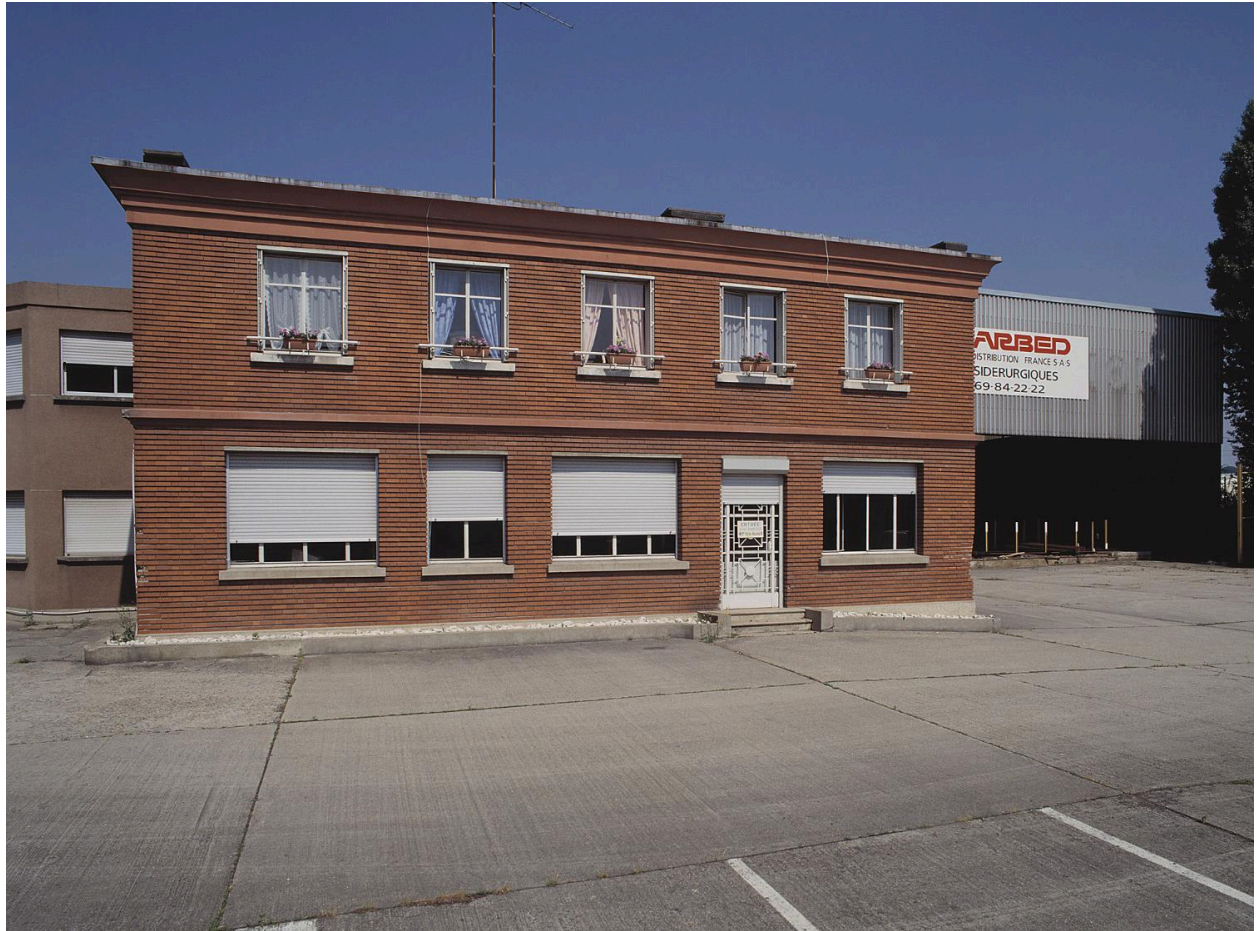
Etablissements Champion : façade antérieure du même bâtiment.
