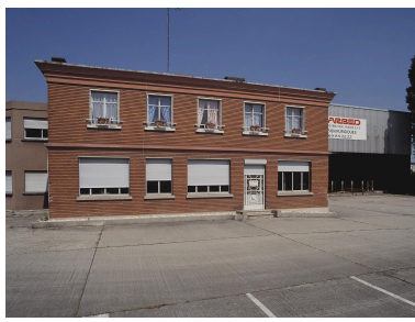
Etablissements Champion : façade antérieure du même bâtiment. Phot. Philippe Ayrault IVR11_20039100962XA
