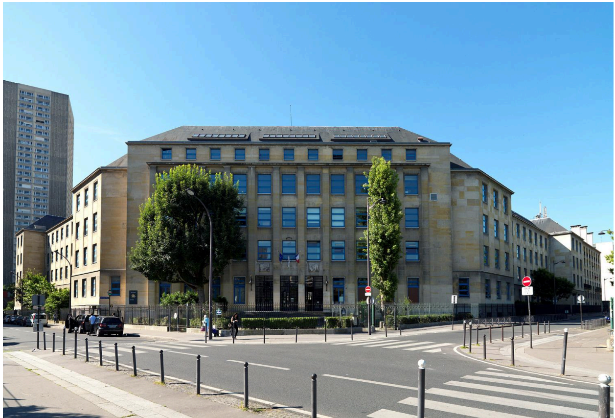
Vue générale du lycée, à l'angle des rues Charles Moureu et du docteur Magnan.
