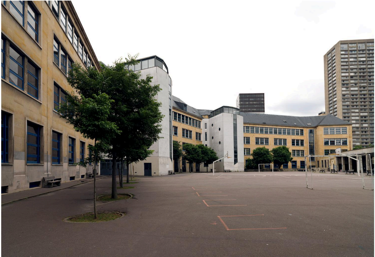
Vue générale de la cour du lycée et des deux ailes enserrant le corps principal.
