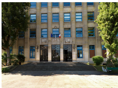
L'entrée du lycée, avec trois portes et des lanternes dont le travail de ferronnerie a été exécuté par Raymond Subes. Phot. Jean-Bernard Vialles IVR11_20167500412NUC4S
