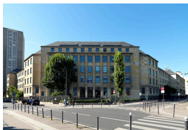
Vue générale du lycée, à l'angle des rues Charles Moureu et du docteur Magnan. Phot. Jean-Bernard Vialles IVR11_20167500411NUC4S
