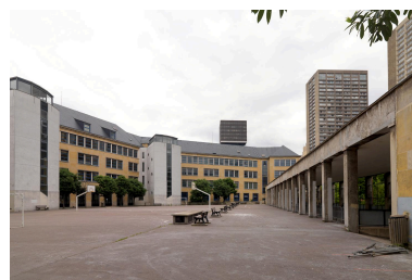
Vue générale de la cour avec, à droite, le portique la fermant au sud. Phot. Jean-Bernard Vialles IVR11_20167500419NUC4S
