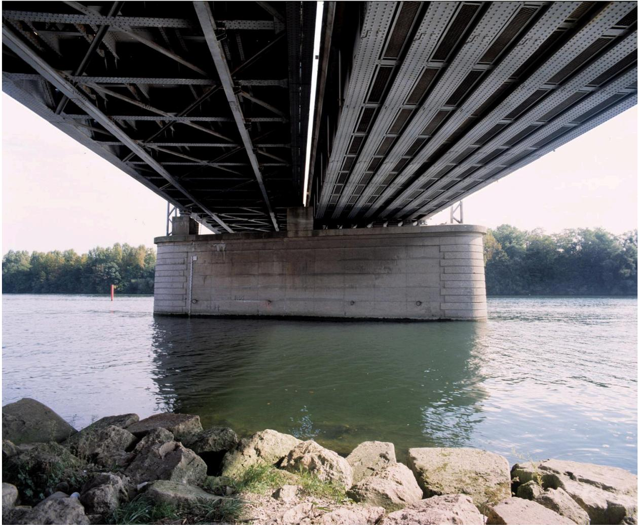
Vue inférieure des tabliers (8 poutres à âme pleine supportant une dalle en béton armé côté amont, tôle rivetée en croix de Saint-André côté aval).
