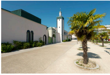
Le bâtiment d'origine. Phot. Laurent Kruszyk IVR11_20177800415NUC4A
