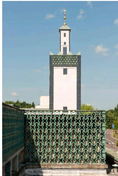
Les parties hautes de la mosquée sont ornées d'un décor inspiré des moucharabiés avec des motifs géométriques en terre cuite vernissée. Phot. Laurent Kruszyk IVR11_20177800420NUC4A
