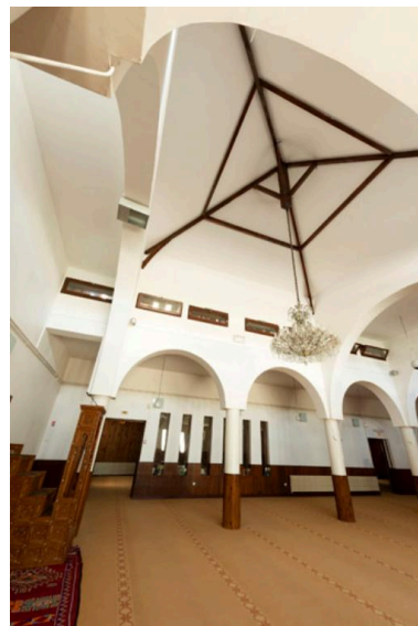
La grande salle de prière est surmontée dans sa partie orientale d'une charpente et d'un toit surélevés. Phot. Laurent Kruszyk IVR11_20177800434NUC4A
