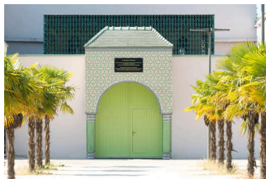
L'entrée primitive de la mosquée qui donnait sur un patio. Phot. Laurent Kruszyk IVR11_20177800422NUC4A
