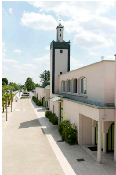
Vue latérale de la façade. Phot. Laurent Kruszyk IVR11_20177800417NUC4A
