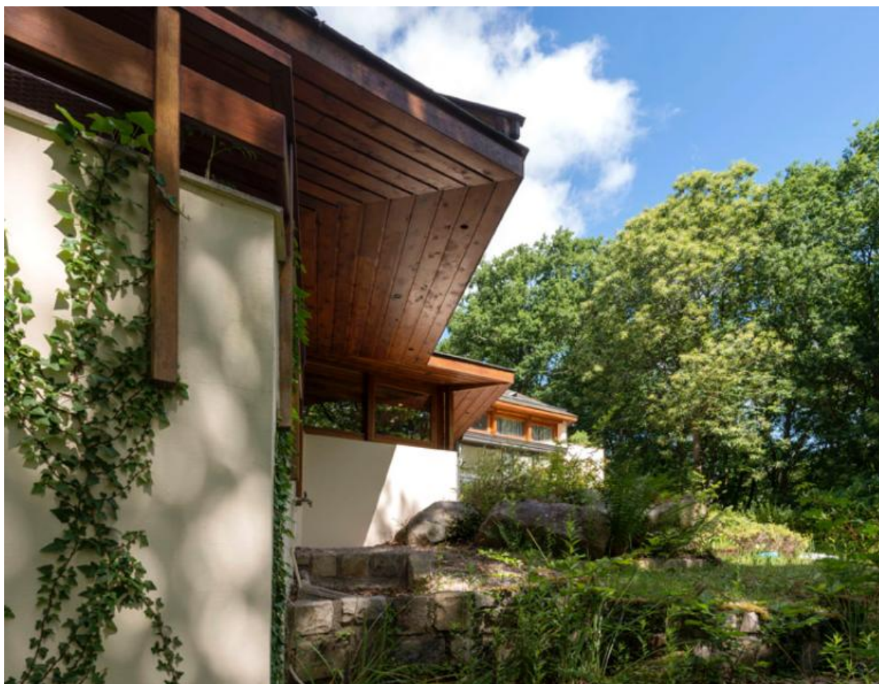
Vue en contre-plongée de l'aile gauche de la façade principale.
