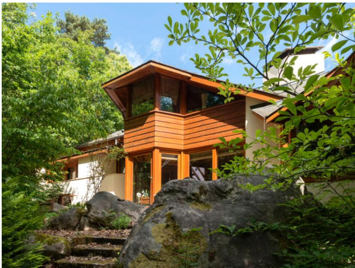
Vue générale de la façade latérale.
