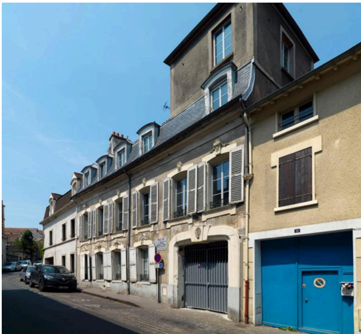
Vue générale (horizontale)
