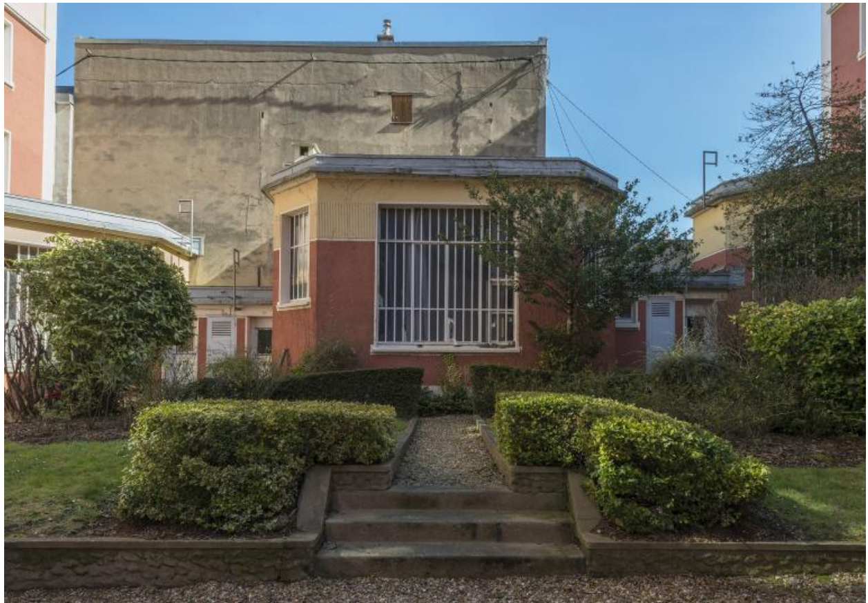
Vue des ateliers situés au rez-de-chaussée (10)
