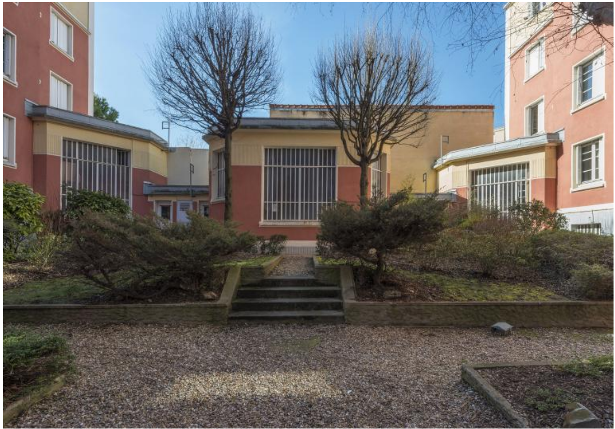
Vue des ateliers situés au rez-de-chaussée (7)
