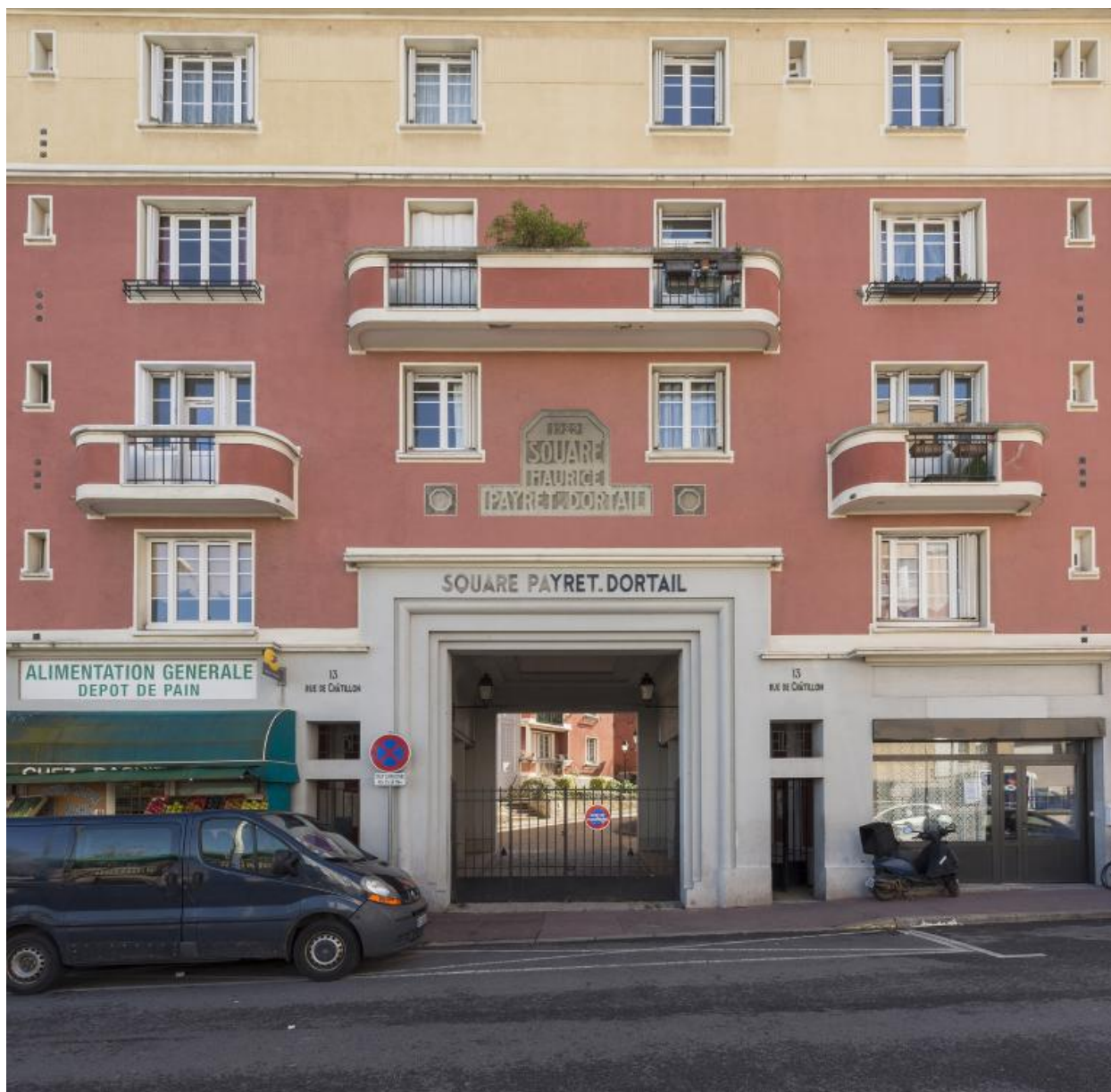
Vue de la façade de la Cité Payret-Dortail Portail côté rue au 13 rue de Chatillon
