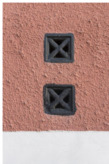
Détail du système d'aération ouvert sur la façade Phot. Laurent Kruszyk IVR11_20189200116NUC4A
