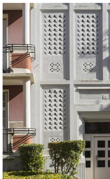
Détail de la cage d'escalier
