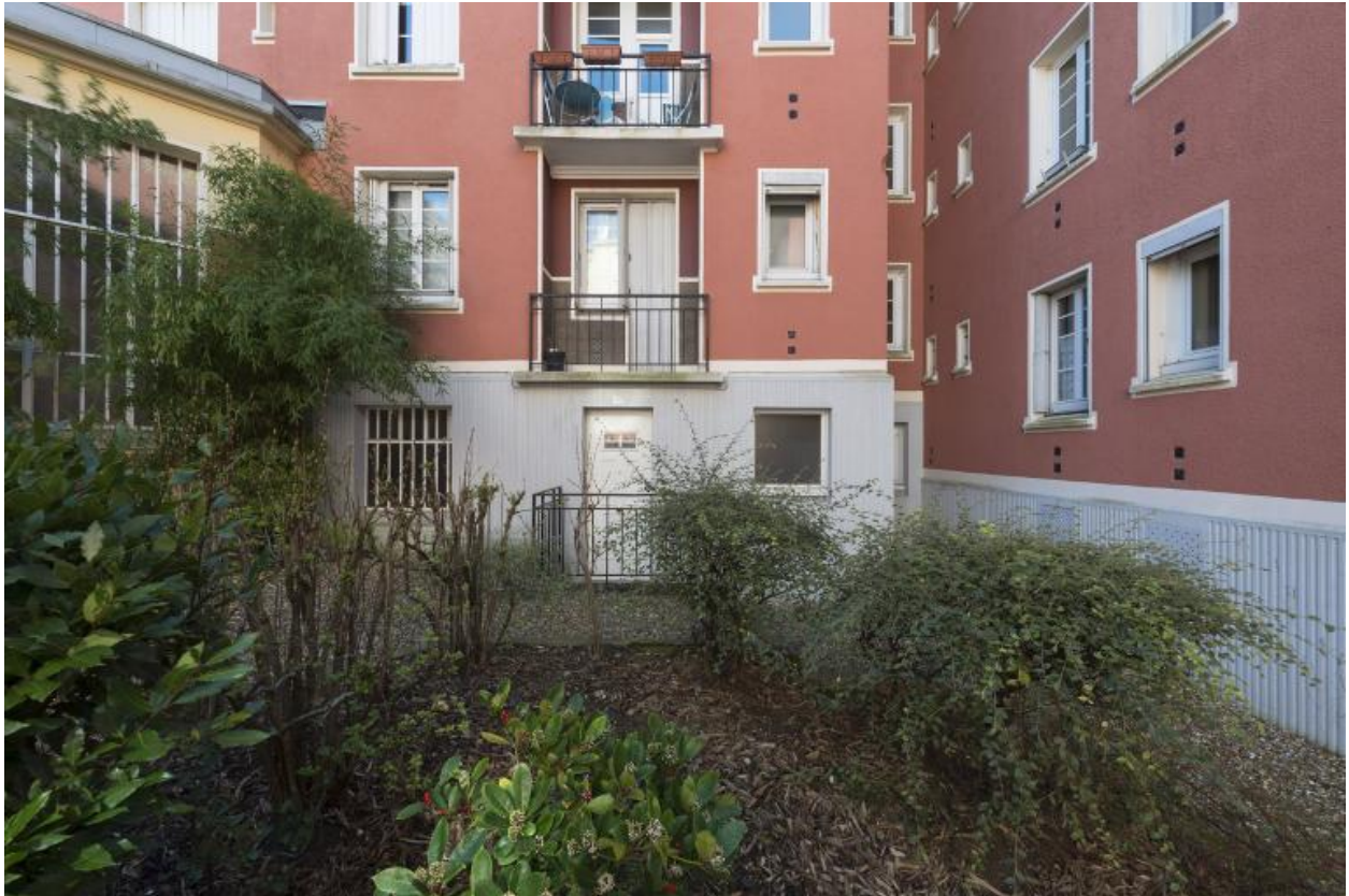
Vue des ateliers situés au rez-de-chaussée (11)
