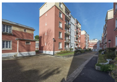
Vue générale de la cour intérieure (1) Phot. Laurent Kruszyk IVR11_20189200105NUC4A
