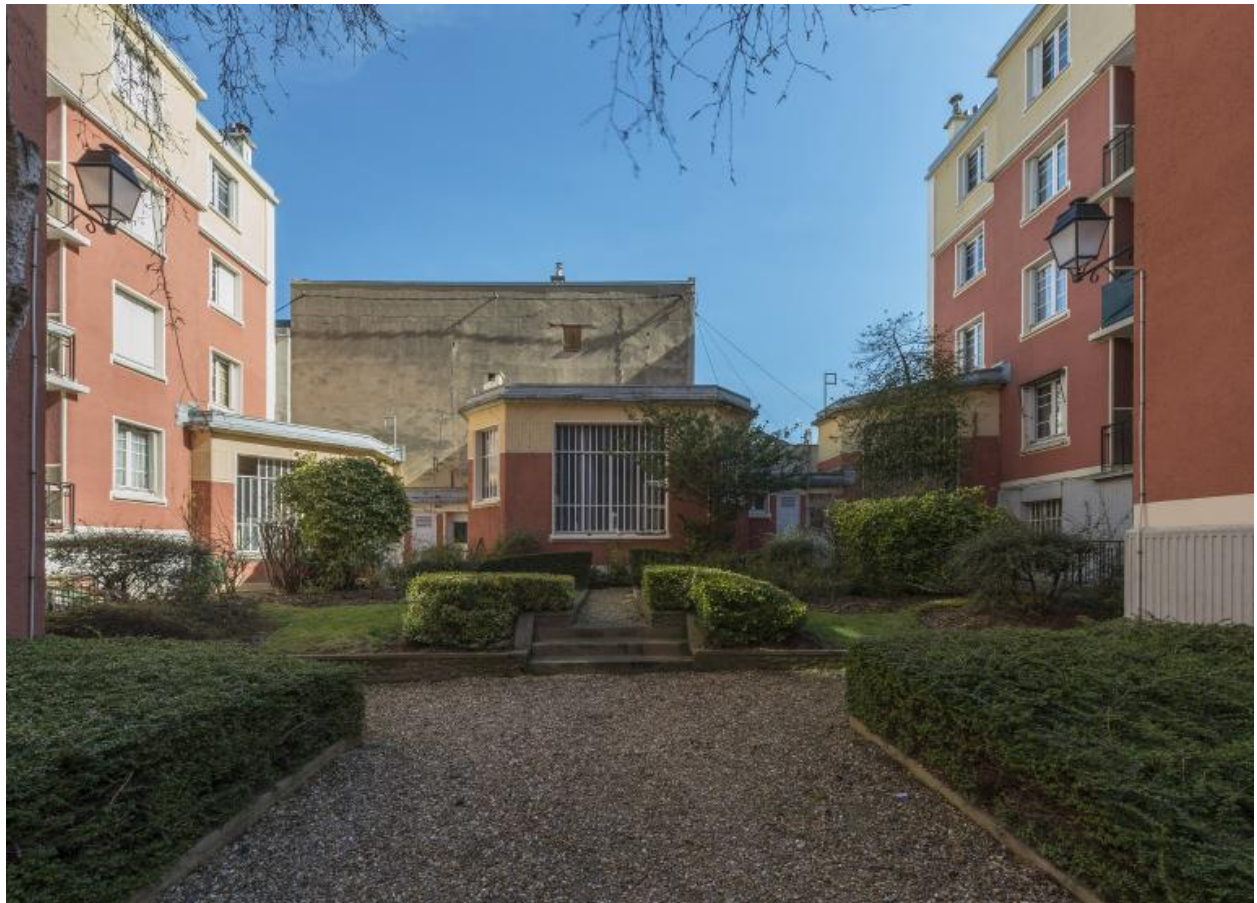
Vue des ateliers situés au rez-de-chaussée (9)
