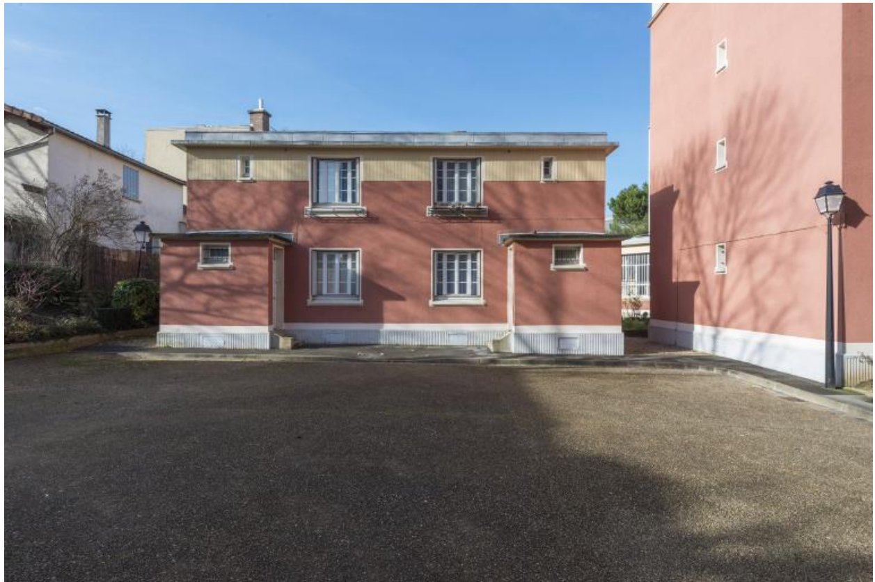
Vue des ateliers situés au rez-de-chaussée (3)
