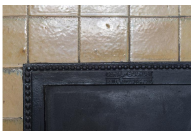
Détail de la cheminée présente dans l'atelier de Mme X. (2) Phot. Laurent Kruszyk IVR11_20189200131NUC4A
