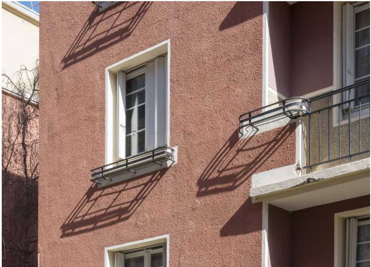
Façade du bâtiment latéral (3)
