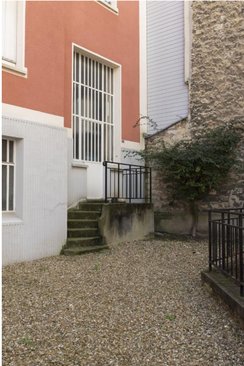
Vue des ateliers situés au rez-de-chaussée (4)
