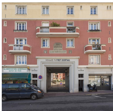
Vue de la façade de la Cité Payret-Dortail Portail côté rue au 13 rue de Chatillon Phot. Laurent Kruszyk IVR11_20189200100NUC4A
