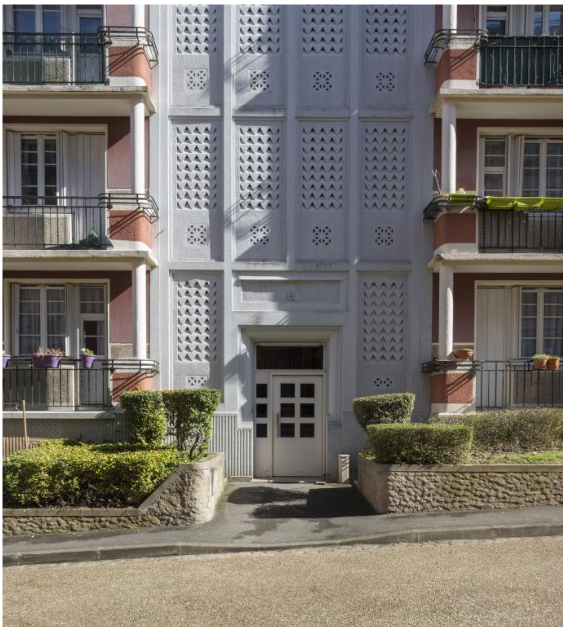
Façade du bâtiment latéral (1)
