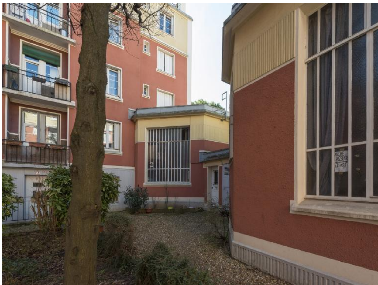
Vue des ateliers situés au rez-de-chaussée (8)
