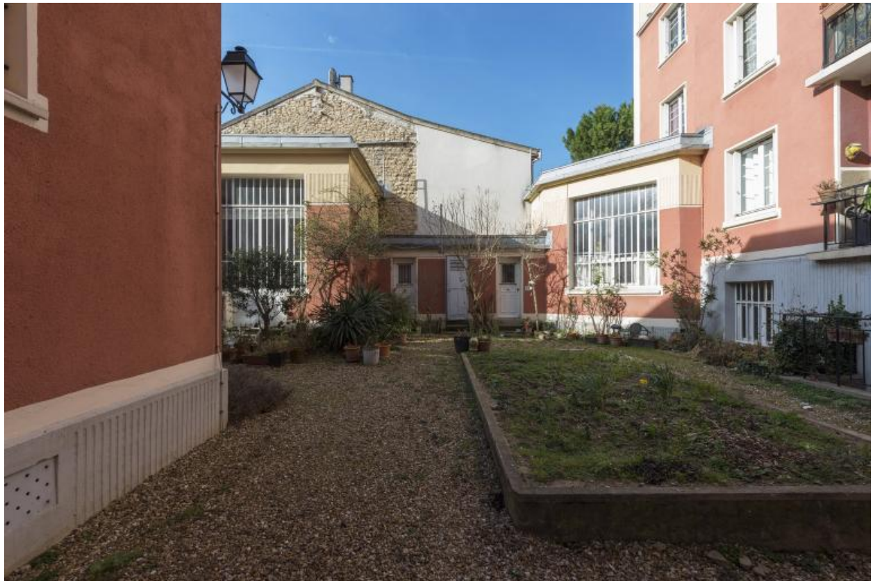
Vue des ateliers situés au rez-de-chaussée (1)
