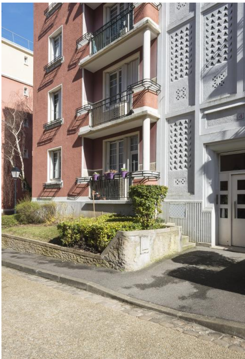
Façade du bâtiment latéral (2)
