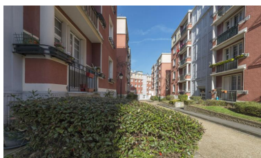
Vue générale de la cour intérieure (2) Phot. Laurent Kruszyk IVR11_20189200106NUC4A
