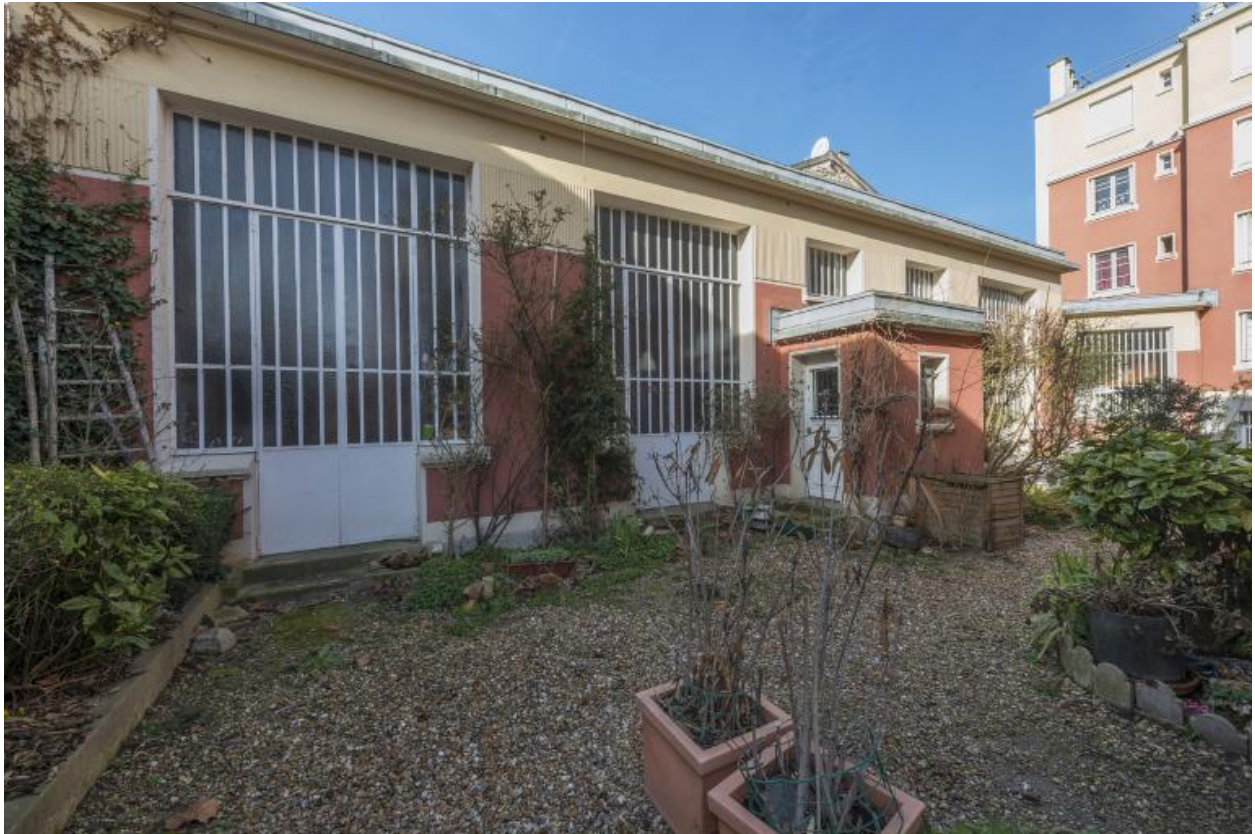
Vue des ateliers situés au rez-de-chaussée (2)
