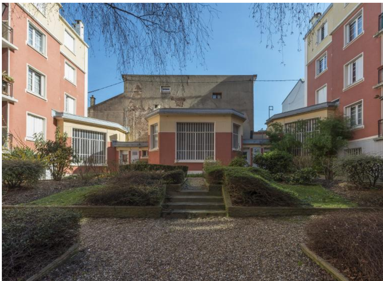
Vue des ateliers situés au rez-de-chaussée (6)
