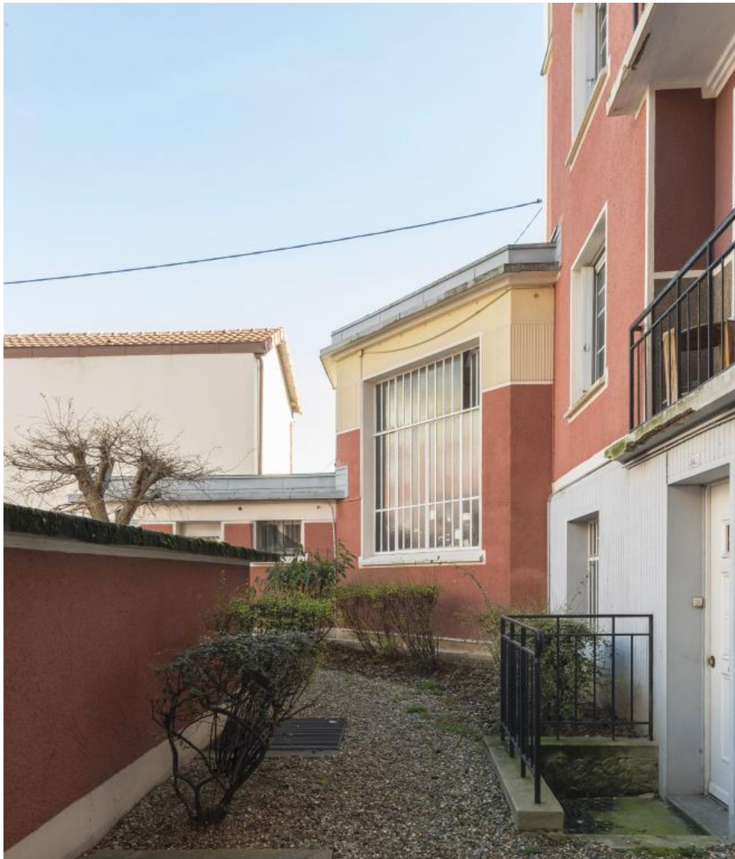
Vue des ateliers situés au rez-de-chaussée (5)
