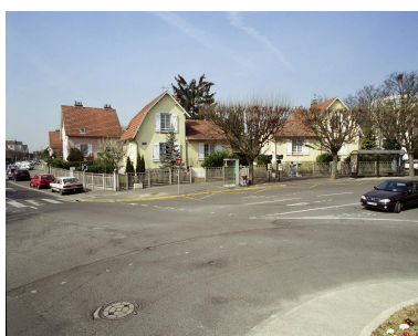
Vue d'ensemble de la place Henri-Deudon. Phot. Philippe Ayrault IVR11_20039100765XA
