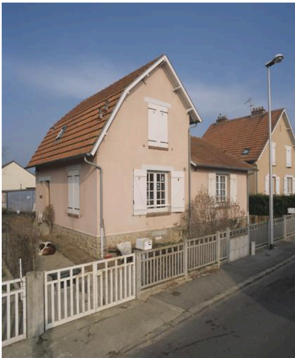
Vue d'ensemble de la maison située au 16, rue Léon-Bourgeois, formée de deux logements du type 1 bis (avec étage) et 2 bis (en rez-de-chaussée).
