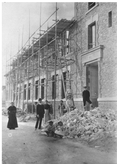
Vue prise durant le chantier. Photographie, vers 1896. (AD Val-de-Marne. Dépôt des communes, Champigny, 2S 214) Autr. Louis Rémy Sabattier IVR11_20069400598XB
