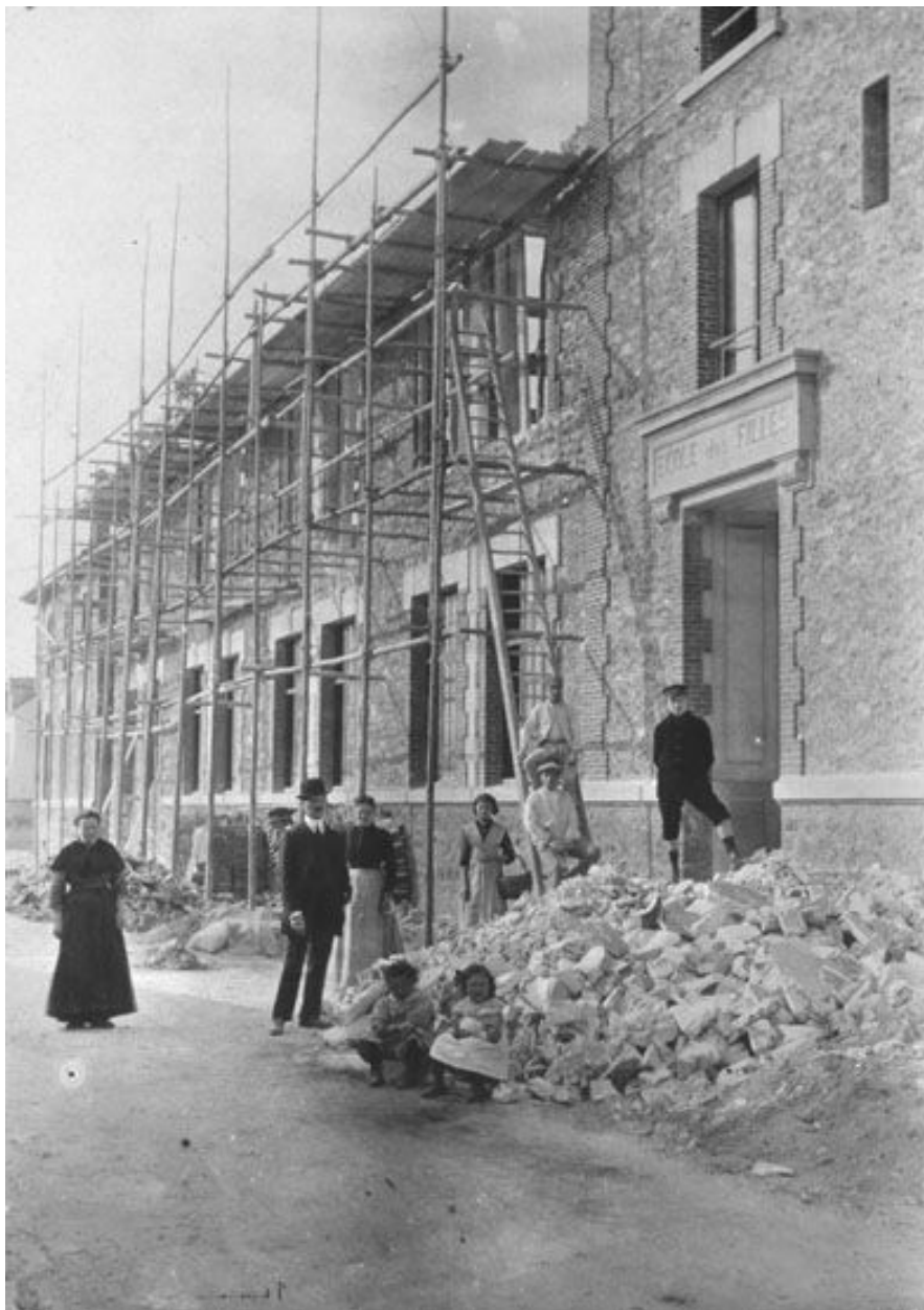
Vue prise durant le chantier. Photographie, vers 1896. (AD Val-de-Marne. Dépôt des communes, Champigny, 2S 214)
