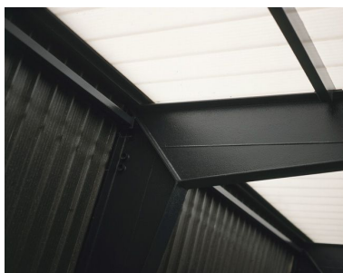
La salle omnisports : articulation poteau-poutre de la structure métallique portante. Phot. Philippe Ayrault IVR11_20069101109XA
