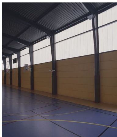
La salle omnisports : perspective des poteaux métalliques préfabriqués supportant la charpente avec bardage de bois. Phot. Philippe Ayrault IVR11_20069101107XA
