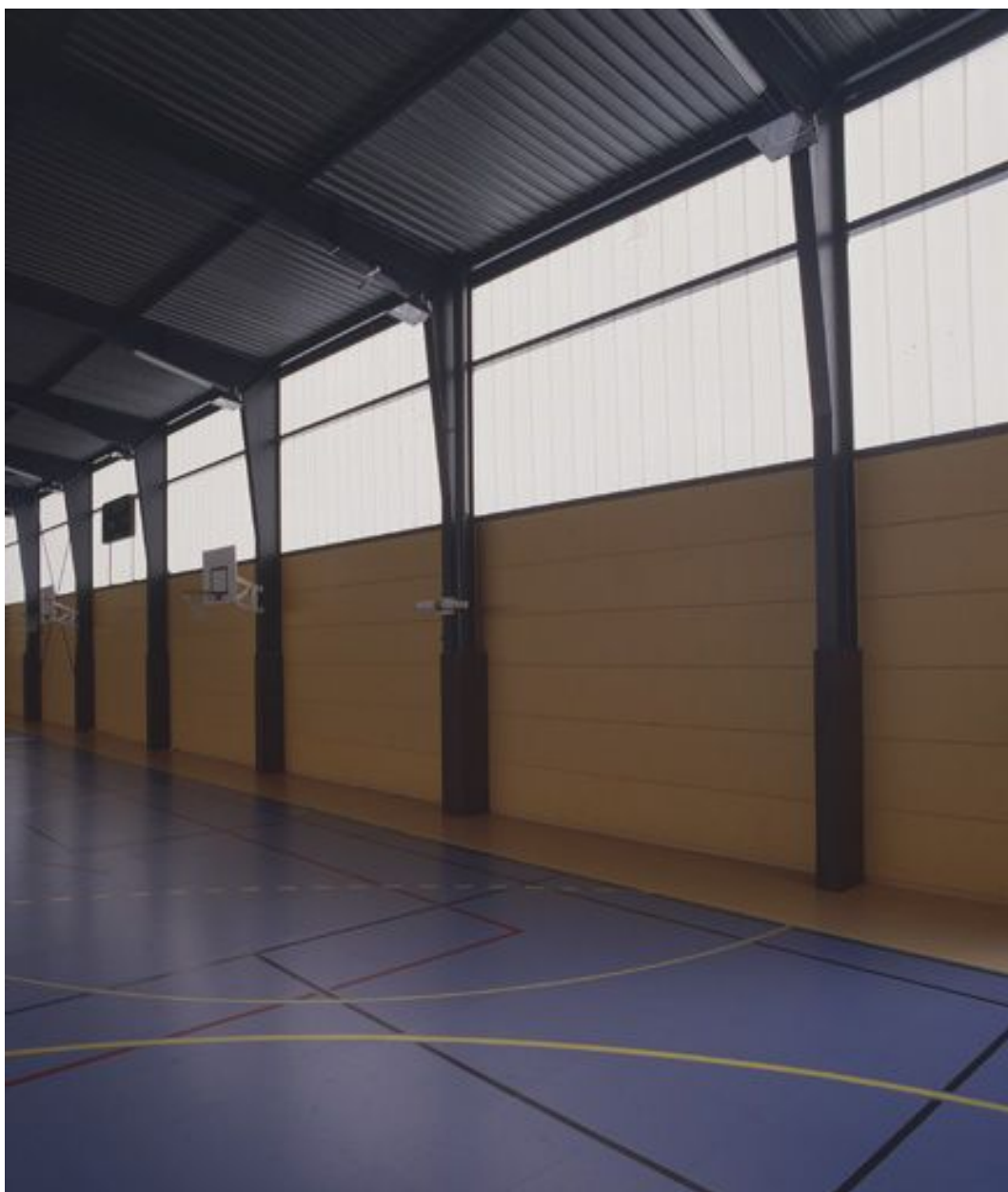
La salle omnisports : perspective des poteaux métalliques préfabriqués supportant la charpente avec bardage de bois.
