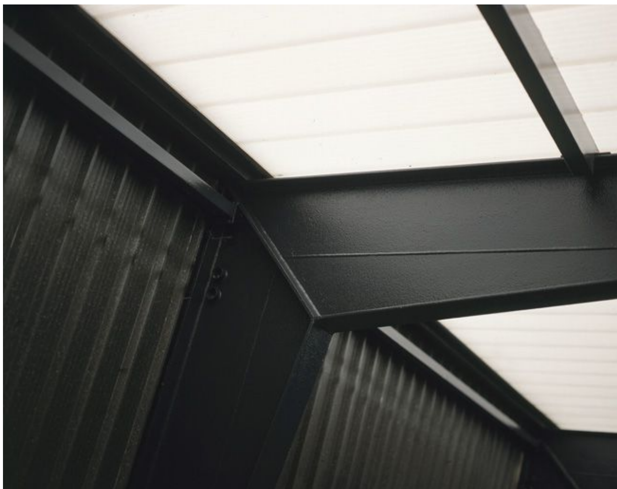
La salle omnisports : articulation poteau-poutre de la structure métallique portante.
