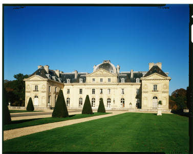
Façade ouest sur la cour. Phot. Vialles Jean-Bernard IVR11_19847801323VA
