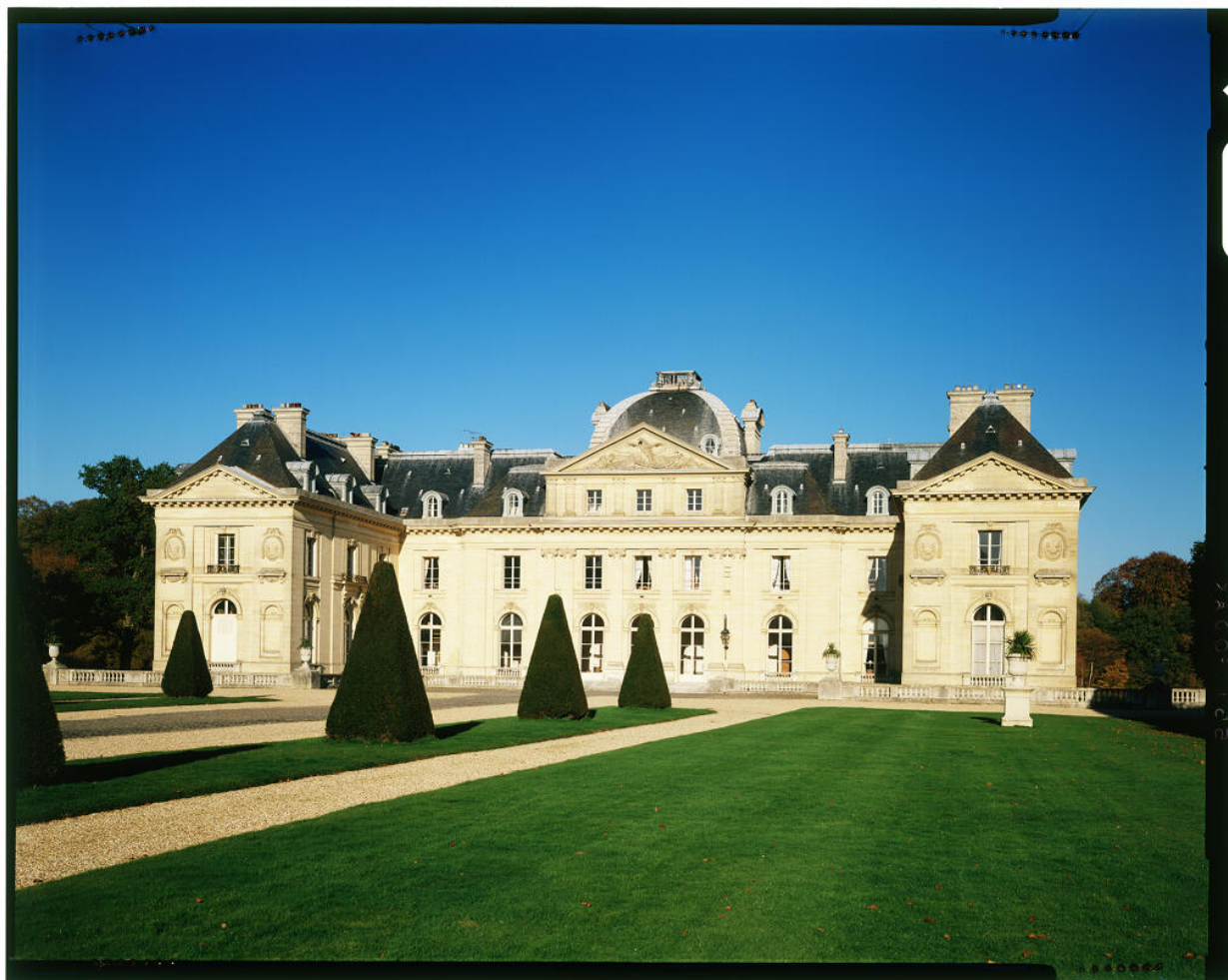
Façade ouest sur la cour.
