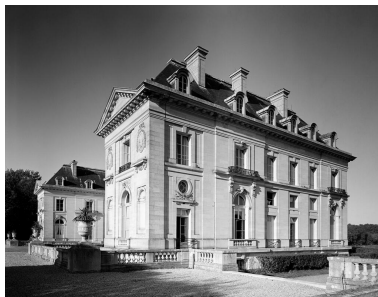
Vue prise du sud-ouest. Phot. Vialles Jean-Bernard IVR11_19847801321V
