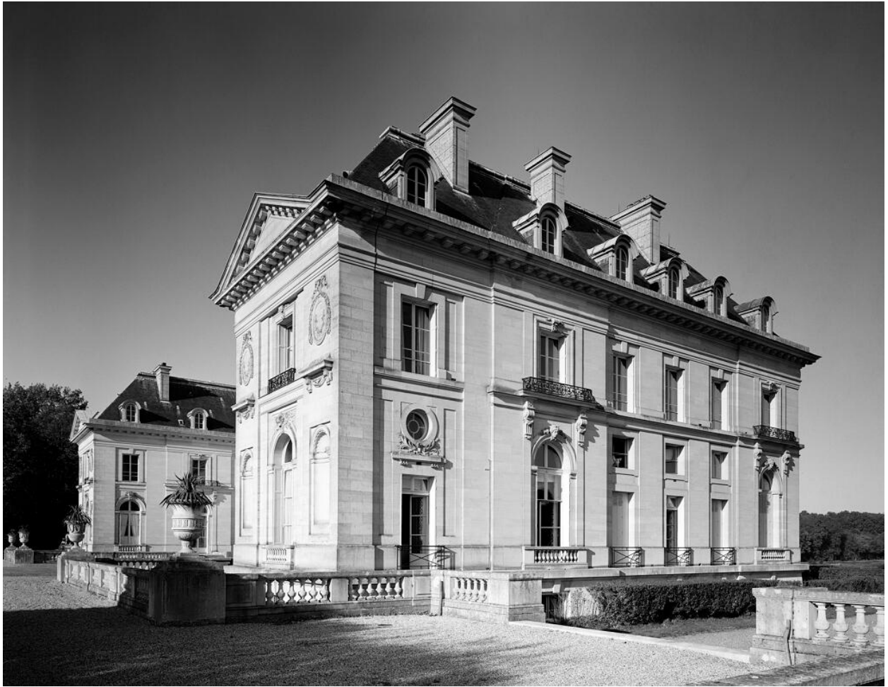
Vue prise du sud-ouest.
