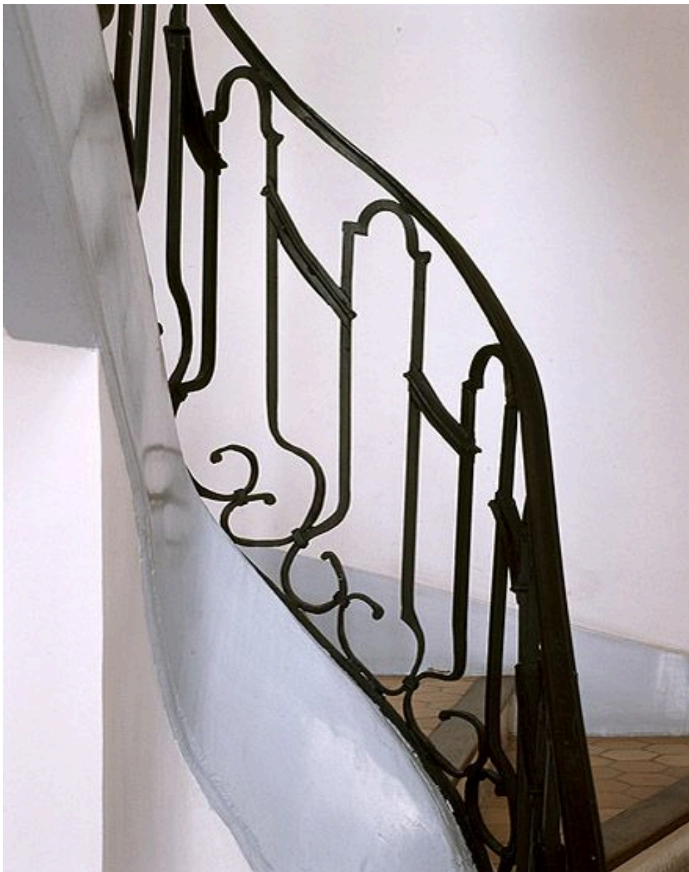
Détail des balustres en ferronnerie de l'escalier.
