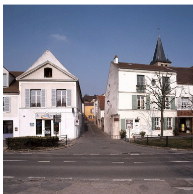
Vue de la façade principale très remaniée. on devine le "fruit" des murs latéraux. Phot. Laurent Kruszyk IVR11_20067800190XA
