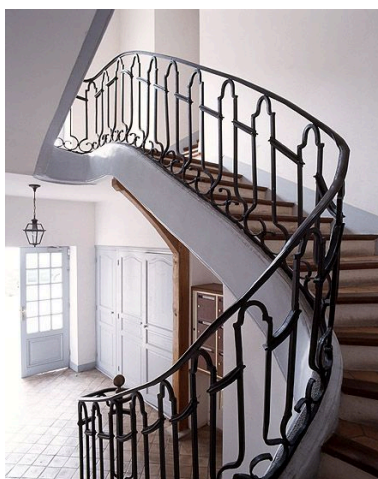
Vue de l'escalier de belles proportions. Phot. Laurent Kruszyk IVR11_20067800194XA
