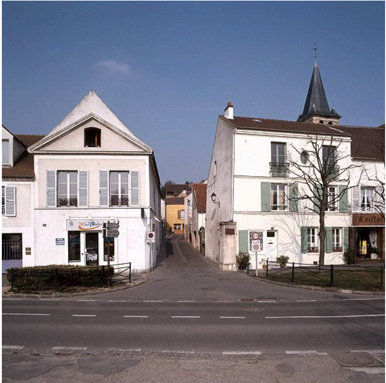
Vue de la façade principale très remaniée. on devine le "fruit" des murs latéraux.
