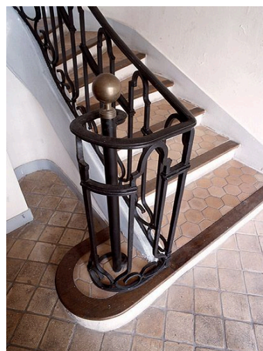
Le départ de l'escalier dont les marches ont été remaniées. Phot. Laurent Kruszyk IVR11_20067800196XA
