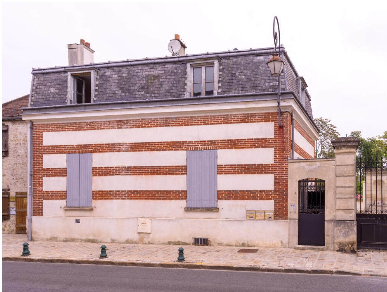
Vue générale des anciens communs du 43 rue Langlois depuis la rue Langlois (depuis le sud).
