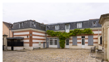
Vue générale des anciens communs du 43 rue Langlois, depuis la cour de l'actuelle médiathèque (depuis le nord-est). Phot. Asseline Stéphane IVR11_20259100216NUC4A
