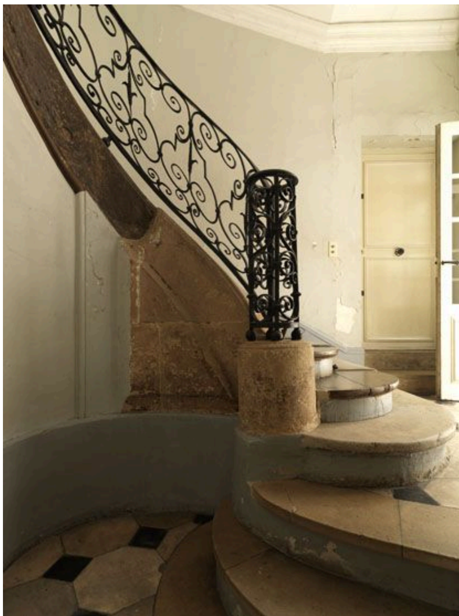
Le départ de l'escalier, vue latérale.
