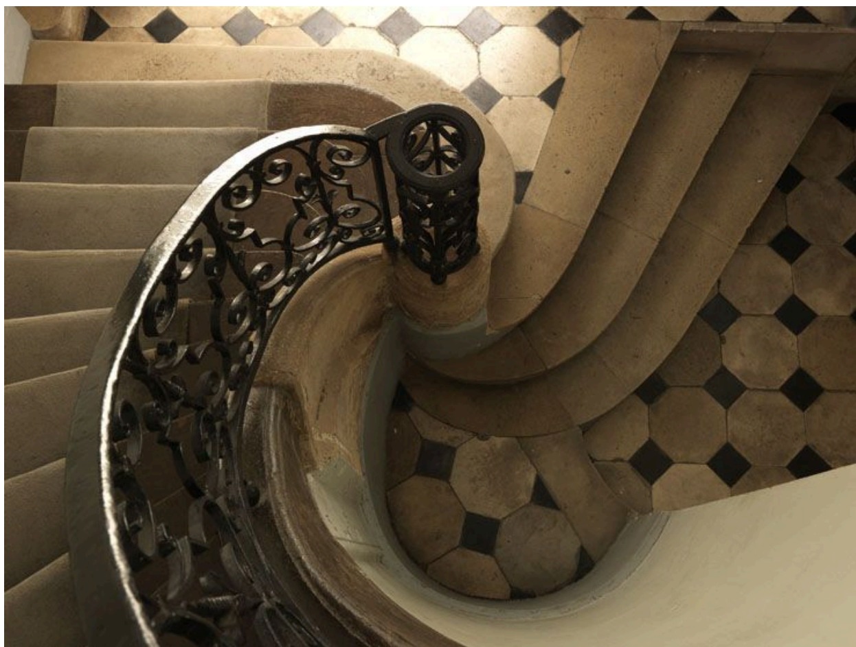
Vue plongeante sur le départ de l'escalier.
