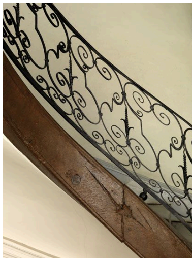
Détail des balustres. Phot. Laurent Kruszyk IVR11_20097501098NUC4A
