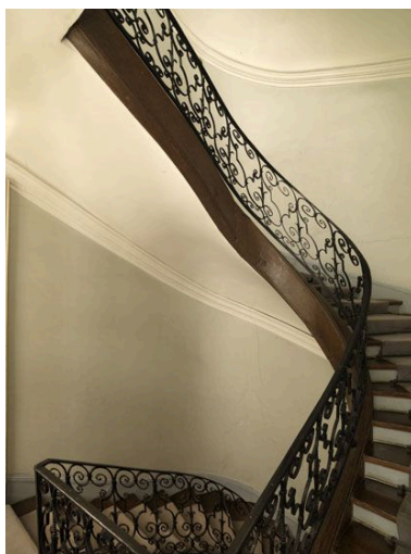
Vue d'ensemble de la rampe. Phot. Laurent Kruszyk IVR11_20097501097NUC4A
