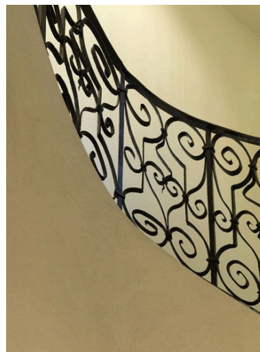
Détail des balustres de l'escalier secondaire. Phot. Laurent Kruszyk IVR11_20107500351NUC4A
