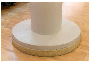
Base d'un pilier de l'ancien bassin. Phot. Laurent Kruszyk IVR11_20157500480NUC4A
