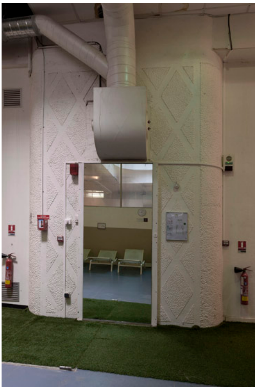
Vue de la trappe menant au sous-sol.
