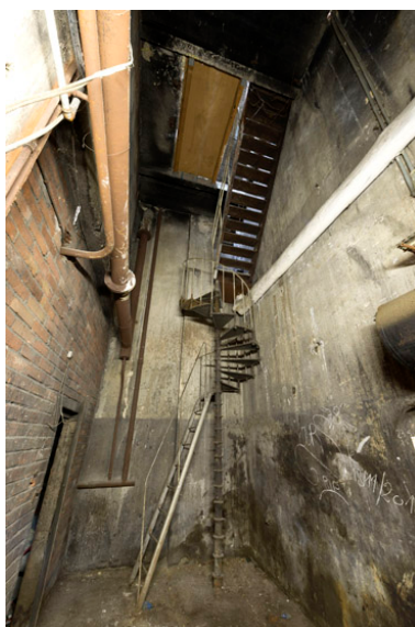
Vue de l'escalier métallique conduisant au sous-sol. Phot. Laurent Kruszyk IVR11_20157500484NUC4A
