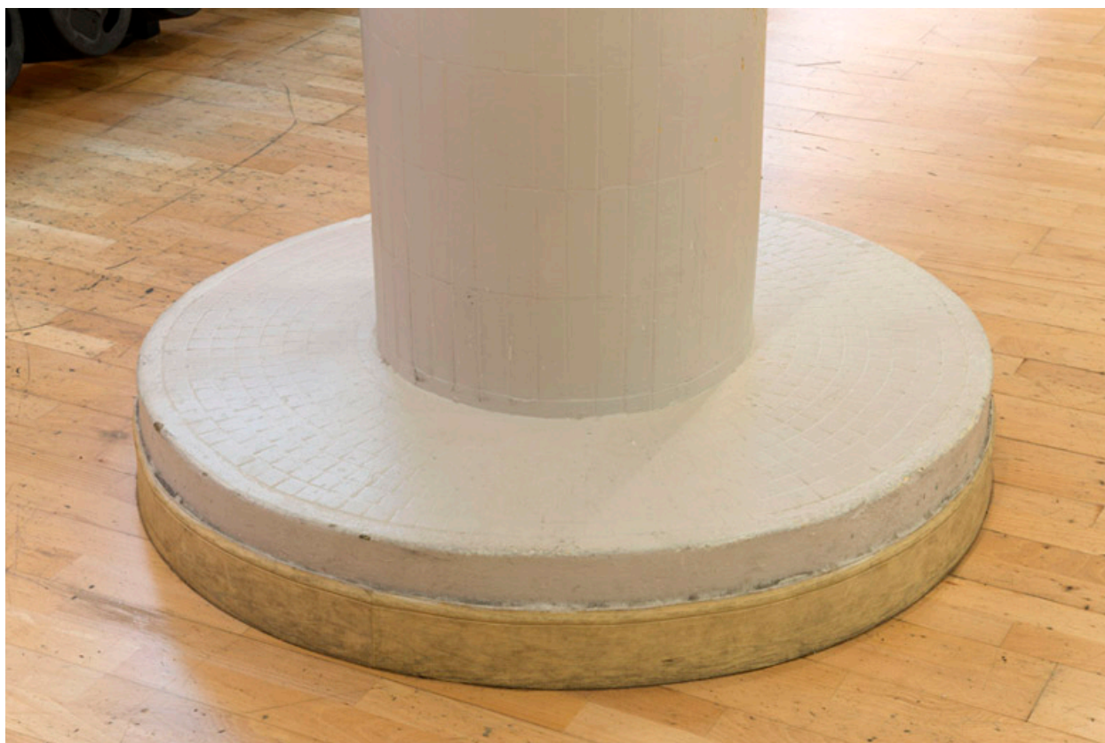
Base d'un pilier de l'ancien bassin.
