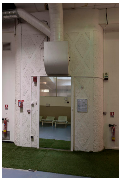
Vue de la trappe menant au sous-sol. Phot. Laurent Kruszyk IVR11_20157500483NUC4A
