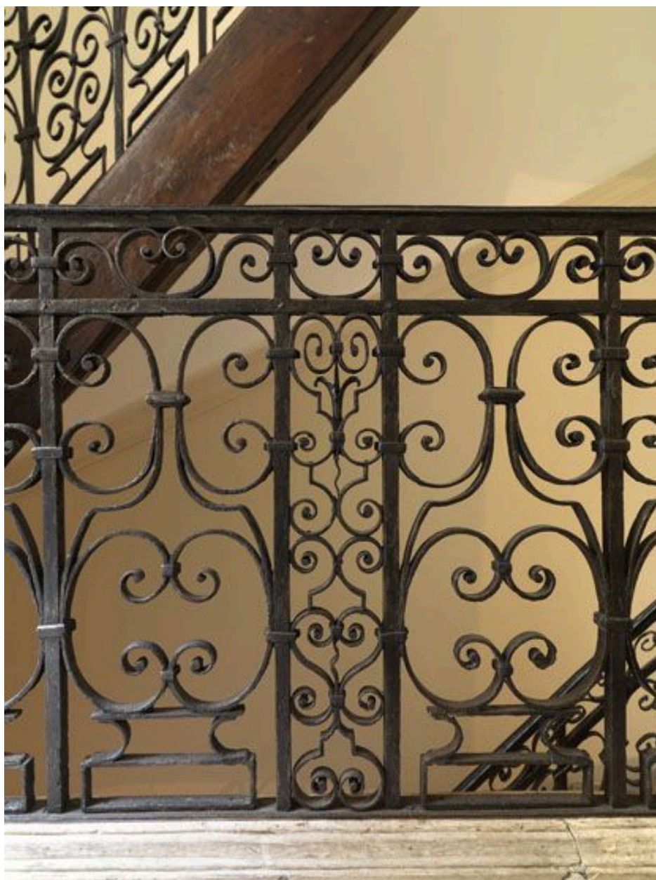
Détail du panneau droit du premier étage.
