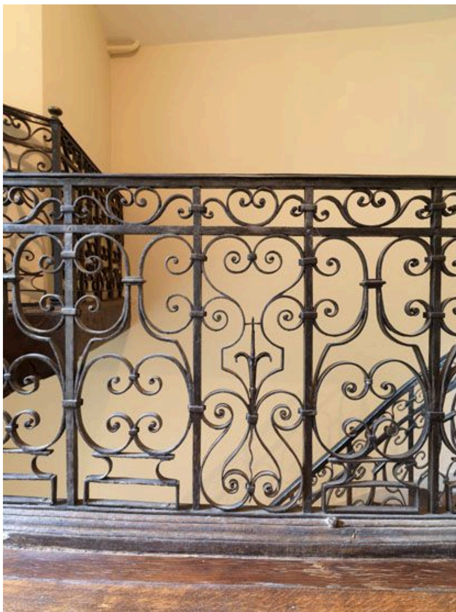
Détail du panneau droit du troisième étage.
