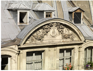
Vue du fronton de la façade sur cour. Phot. Laurent Kruszyk IVR11_20097501578NUC4A
