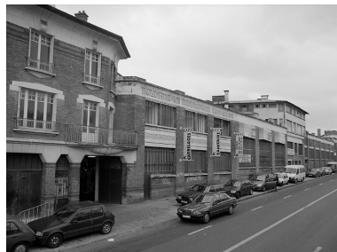
Vue générale de l'entrée principale, prise depuis le boulevard Chanzy. Phot. Jean-Bernard Vialles IVR11_20019300127X
