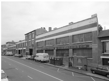
Vue générale de la façade prise depuis le boulevard Chanzy. Phot. Jean-Bernard Vialles IVR11_20019300125X
