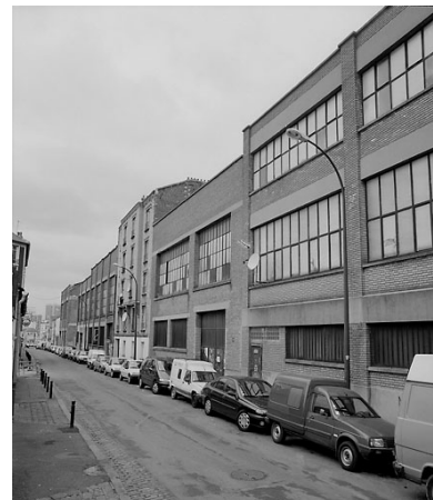
Vue générale de l'arrière des bâtiments, prise depuis la rue des Sorins. Phot. Jean-Bernard Vialles IVR11_20019300126X
