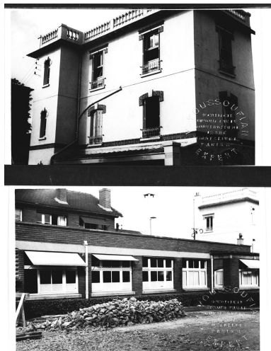
Deux vues d'une partie des bâtiments photographiés par l'architecte V. Youssoufian, expert pour les dommages industriels : habitation en bordure du quai et bureaux en rez-de-chaussée peu endommagés par les bombardements ; s.d., [vers 1944]. Les dommages ont été évalués par cet architecte à 4 millions de francs pour les immeubles et 540 000 F pour l'outillage et le matériel et 2 millions de francs pour les stocks et petit outillage (valeur 1939). IVR11_20039100159XB
