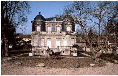
La façade principale, tournée vers la Seine. Phot. Laurent Kruszyk IVR11_20067800212XA
