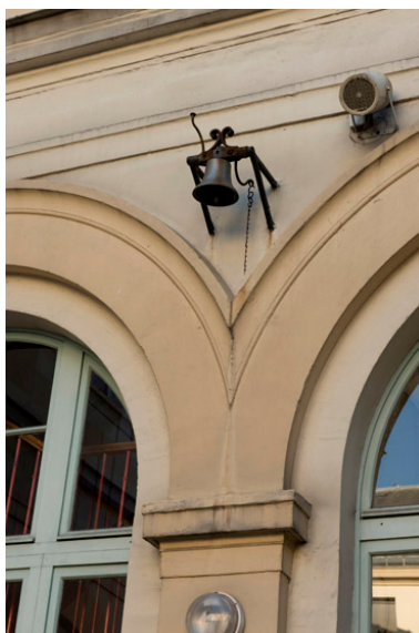
Vue de la cloche de la cour intérieure. Phot. Laurent Kruszyk IVR11_20157500361NUC4A
