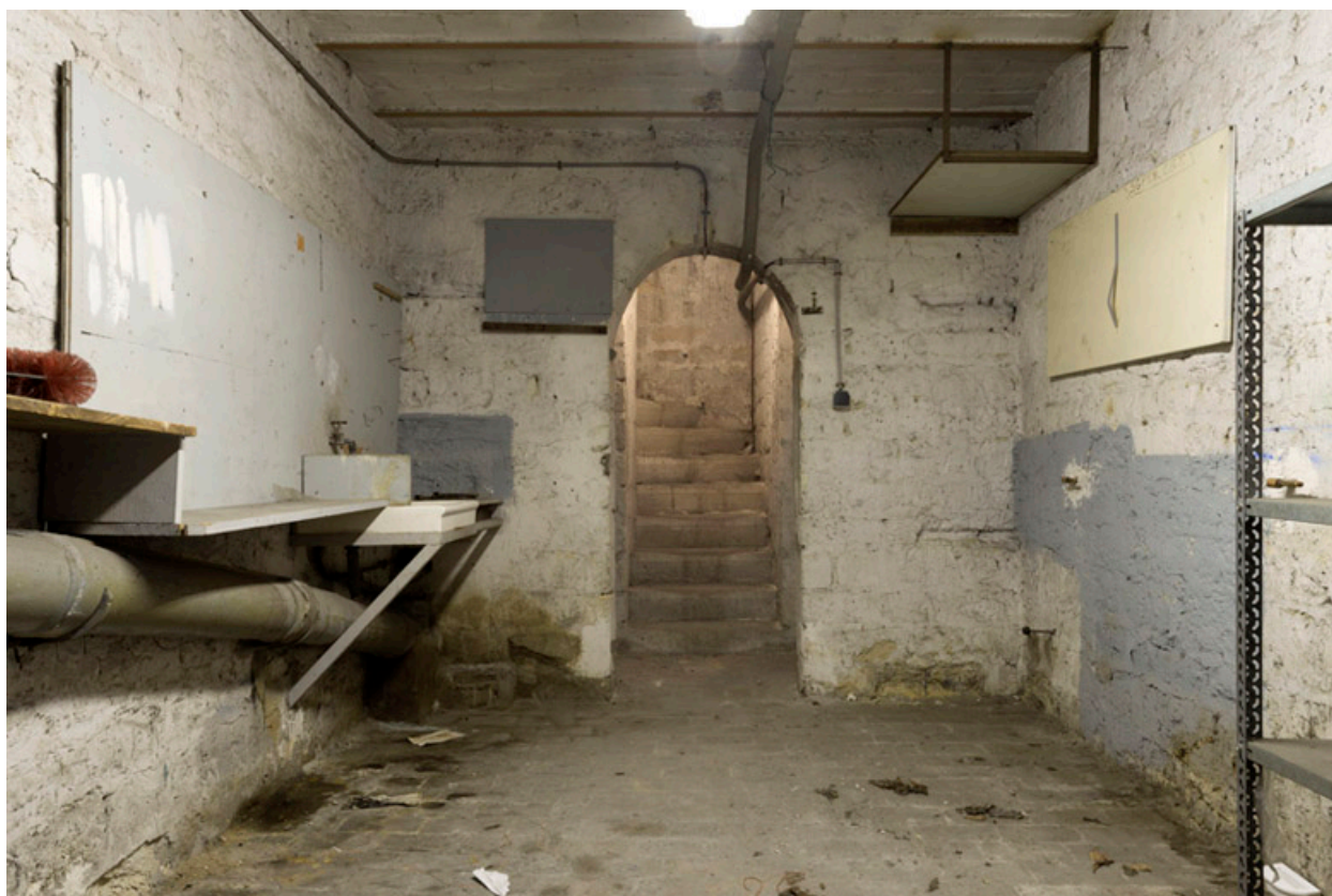
Vue de l'escalier de la cave.
