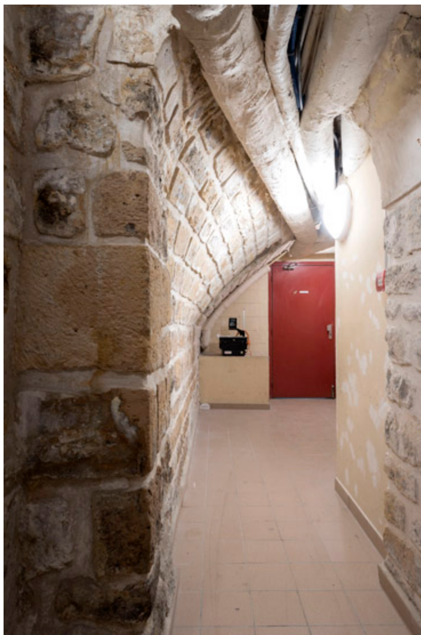
Vue du couloir de la cave menant à la salle voûtée.
