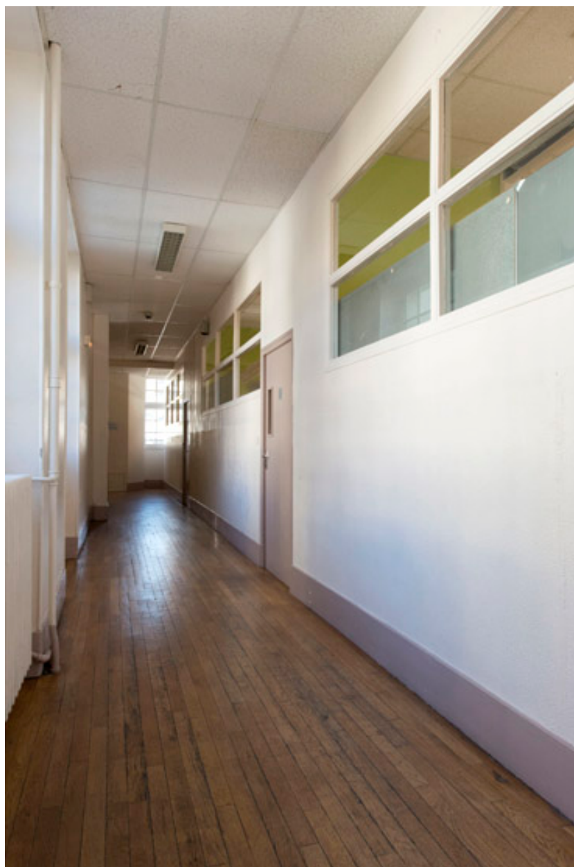
Vue du couloir du premier étage.
