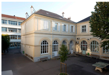
Vue de la jonction entre le bâtiment central et le bâtiment latéral. Phot. Laurent Kruszyk IVR11_20157500357NUC4A
