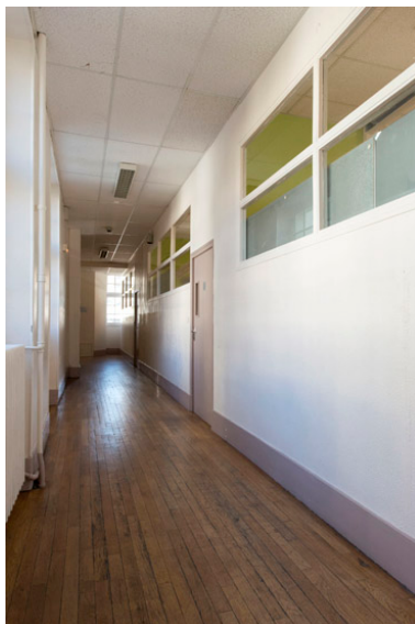
Vue du couloir du premier étage. Phot. Laurent Kruszyk IVR11_20157500366NUC4A
