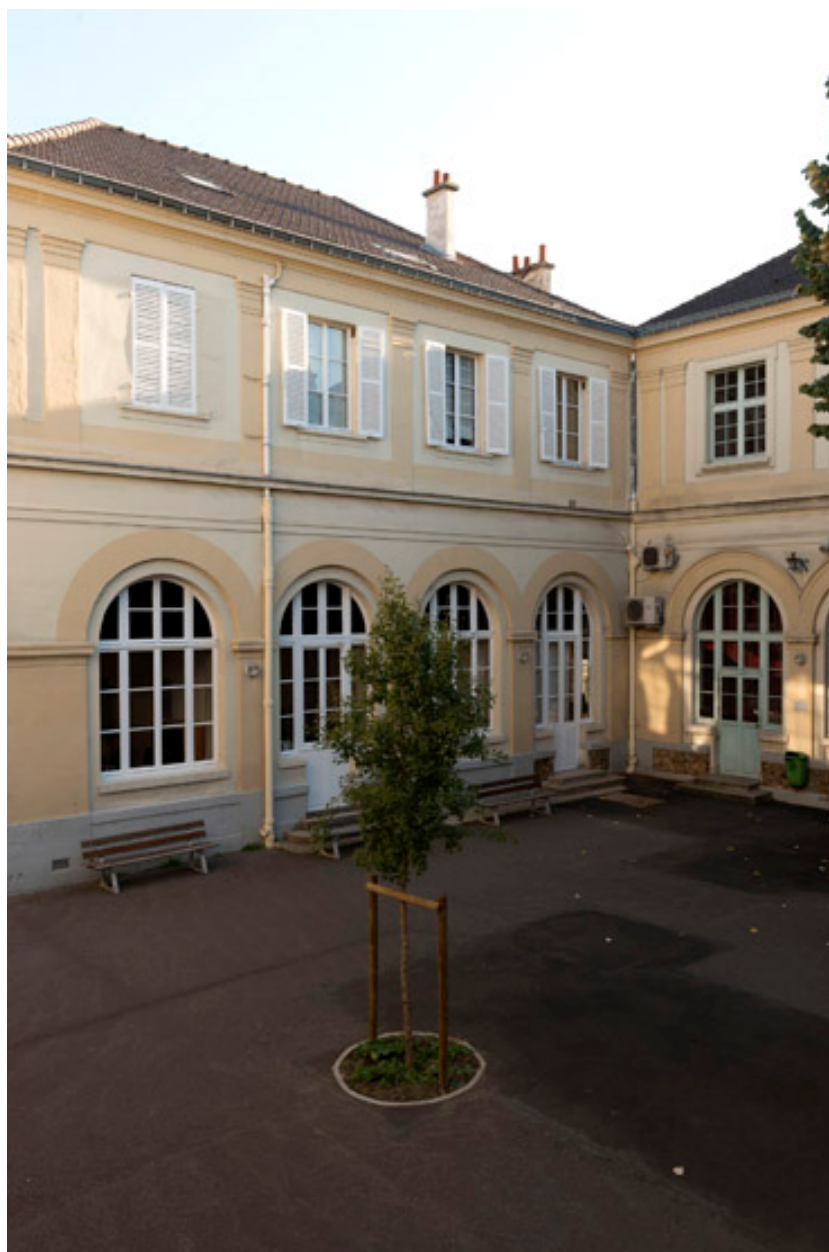
La jonction entre deux bâtiments.
