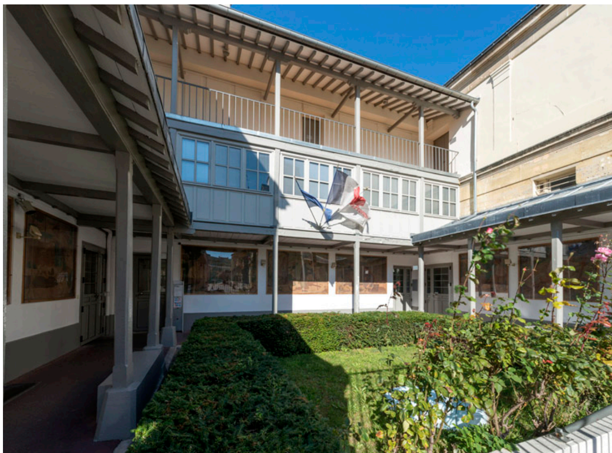
Vue du patio du lycée.
