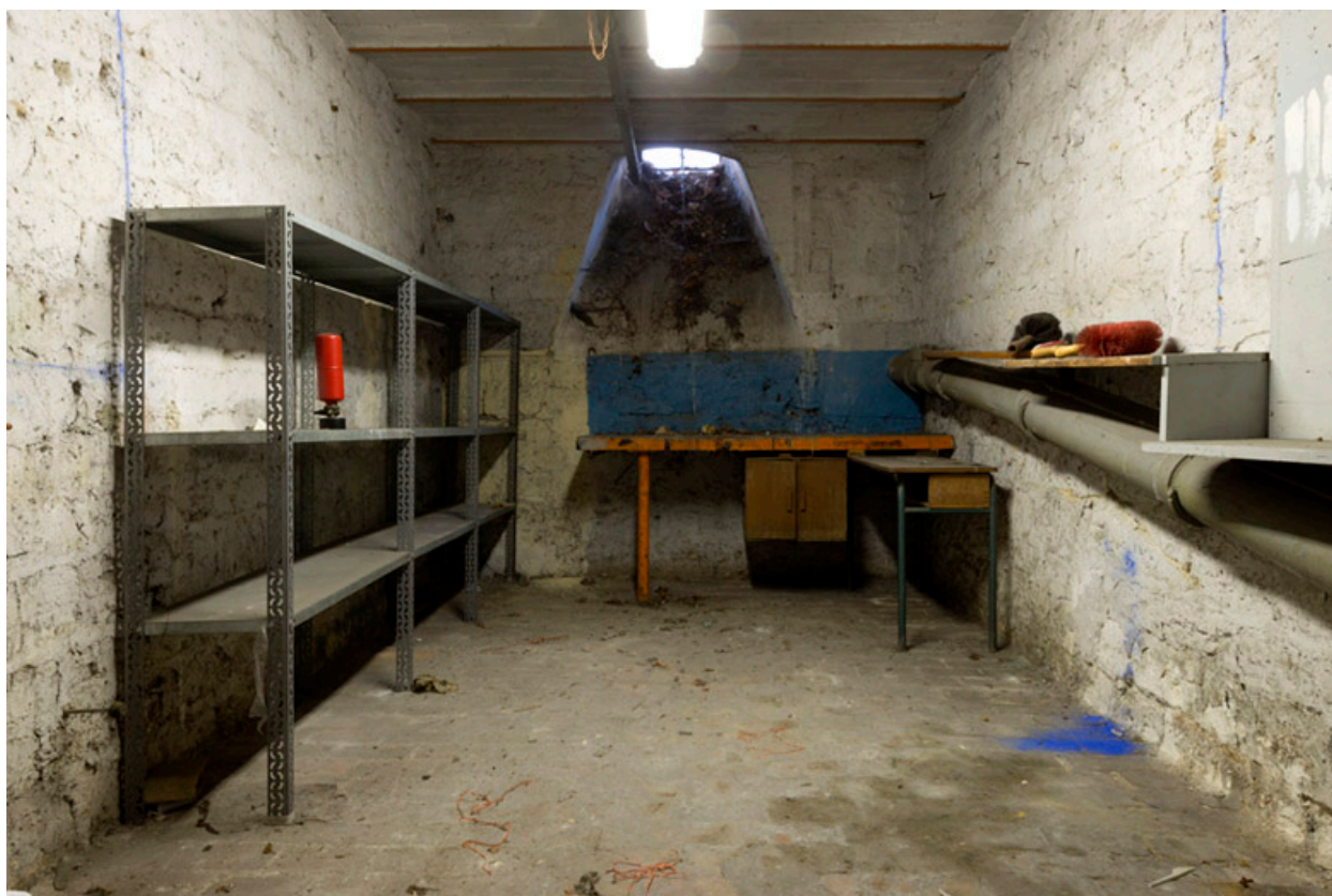
Vue d'une des salles de la cave.
