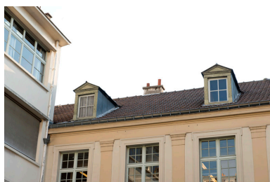
Vue des lucarnes du toit du bâtiment principal. Phot. Laurent Kruszyk IVR11_20157500365NUC4A
