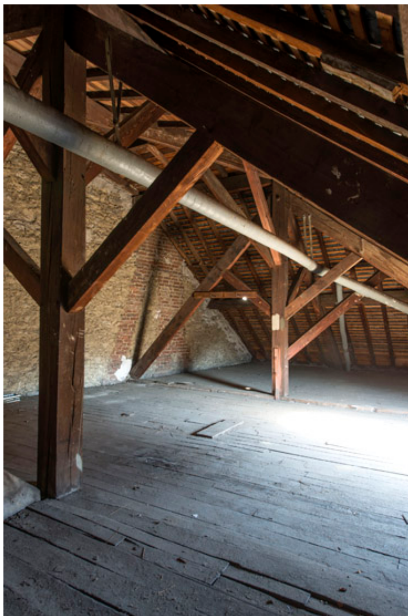
Vue de détail de la charpente. : poutres et contrefiches.
