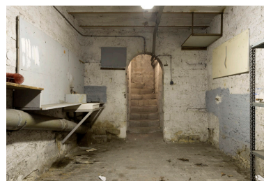
Vue de l'escalier de la cave. Phot. Laurent Kruszyk IVR11_20157500376NUC4A
