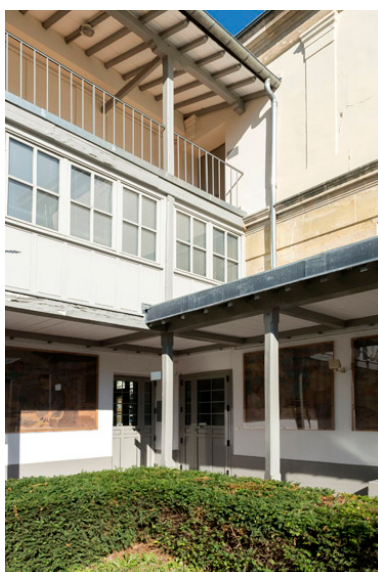
Vue d'un des angles du patio. Phot. Laurent Kruszyk IVR11_20157500356NUC4A
