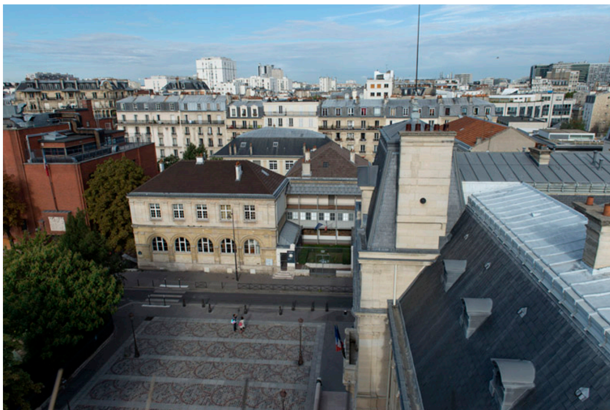
Vue du lycée professionnel prise du campanile de la mairie.
