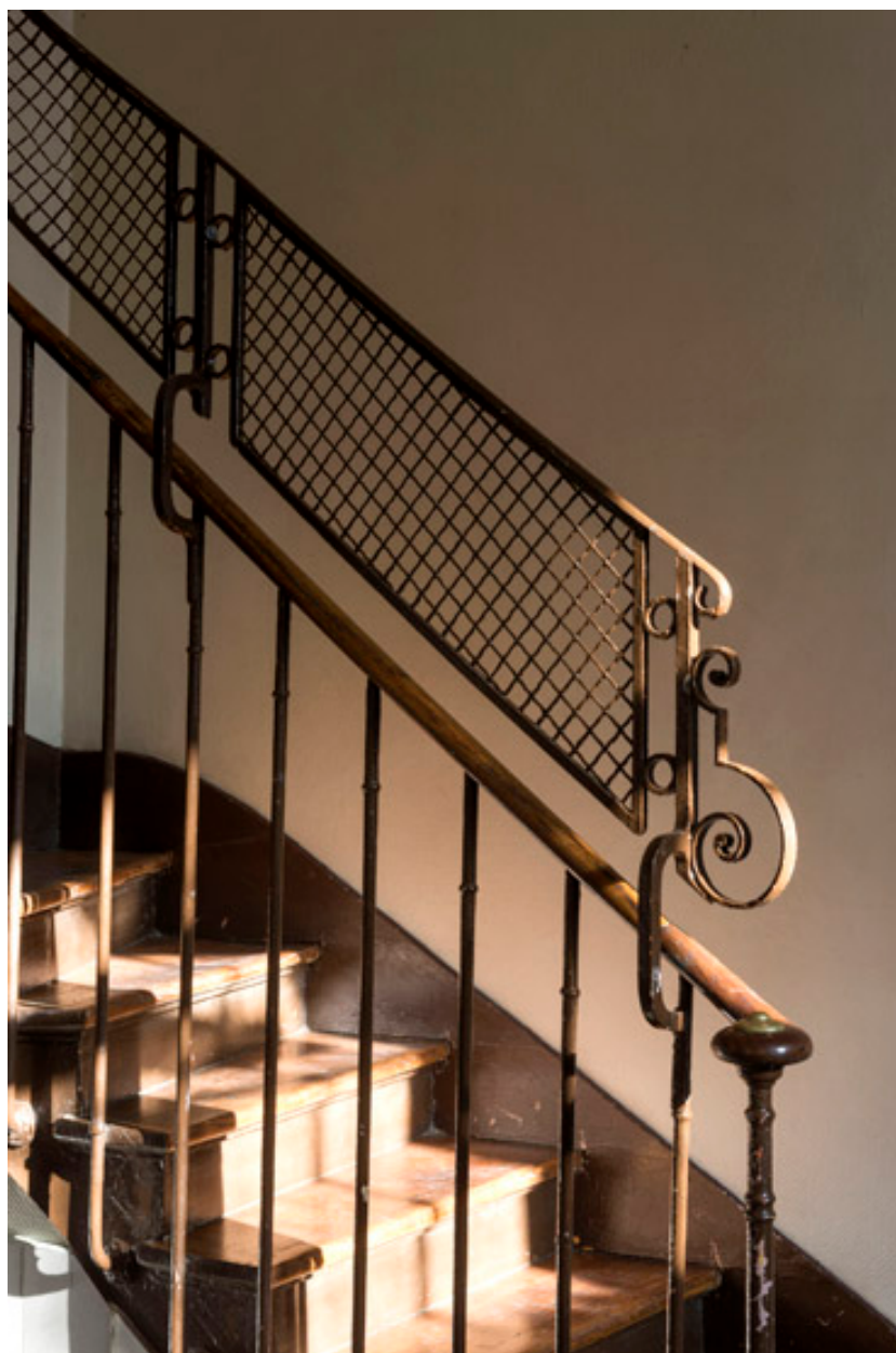
Vue du départ de la rampe de l'escalier.
