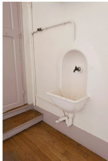
Vue du lavabo situé dans le couloir du premier étage. Phot. Laurent Kruszyk IVR11_20157500367NUC4A
