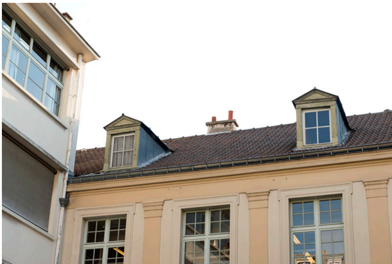
Vue des lucarnes du toit du bâtiment principal.
