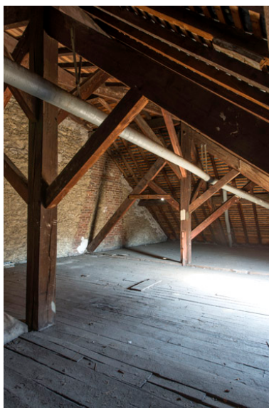
Vue de détail de la charpente. : poutres et contrefiches. Phot. Laurent Kruszyk IVR11_20157500381NUC4A
