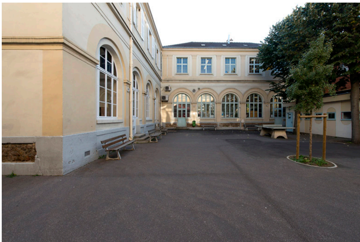
Vue de la cour intérieure.
