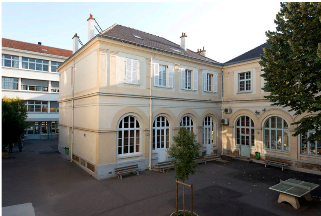
Vue de la jonction entre le bâtiment central et le bâtiment latéral.
