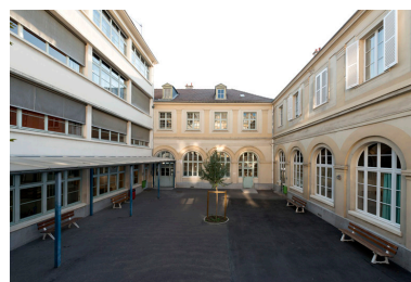
Vue générale de la cour intérieure. Phot. Laurent Kruszyk IVR11_20157500363NUC4A
