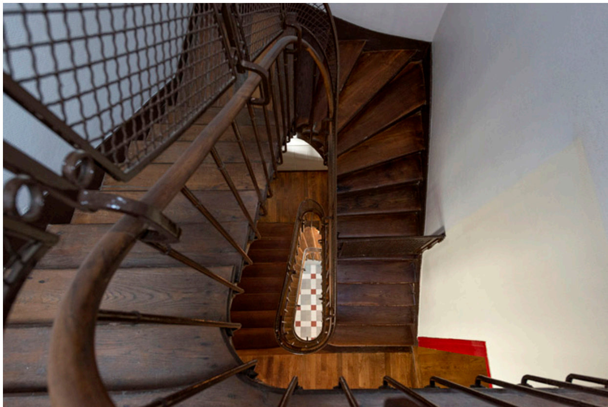
Vue plongeante de la cage d'escalier.
