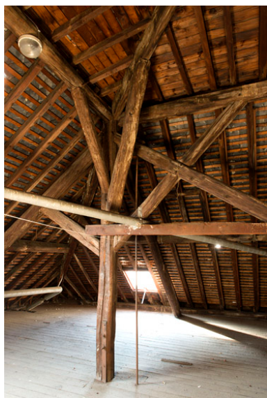
Vue de la charpente. Phot. Laurent Kruszyk IVR11_20157500380NUC4A
