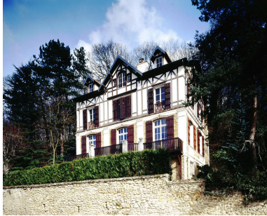
Vue d'ensemble de la façade principale. Phot. Christian Décamps IVR11_20007800192VA
