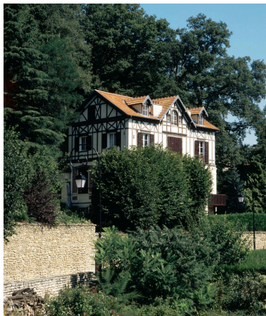
La façade antérieure. IVR11_20007800636XA
