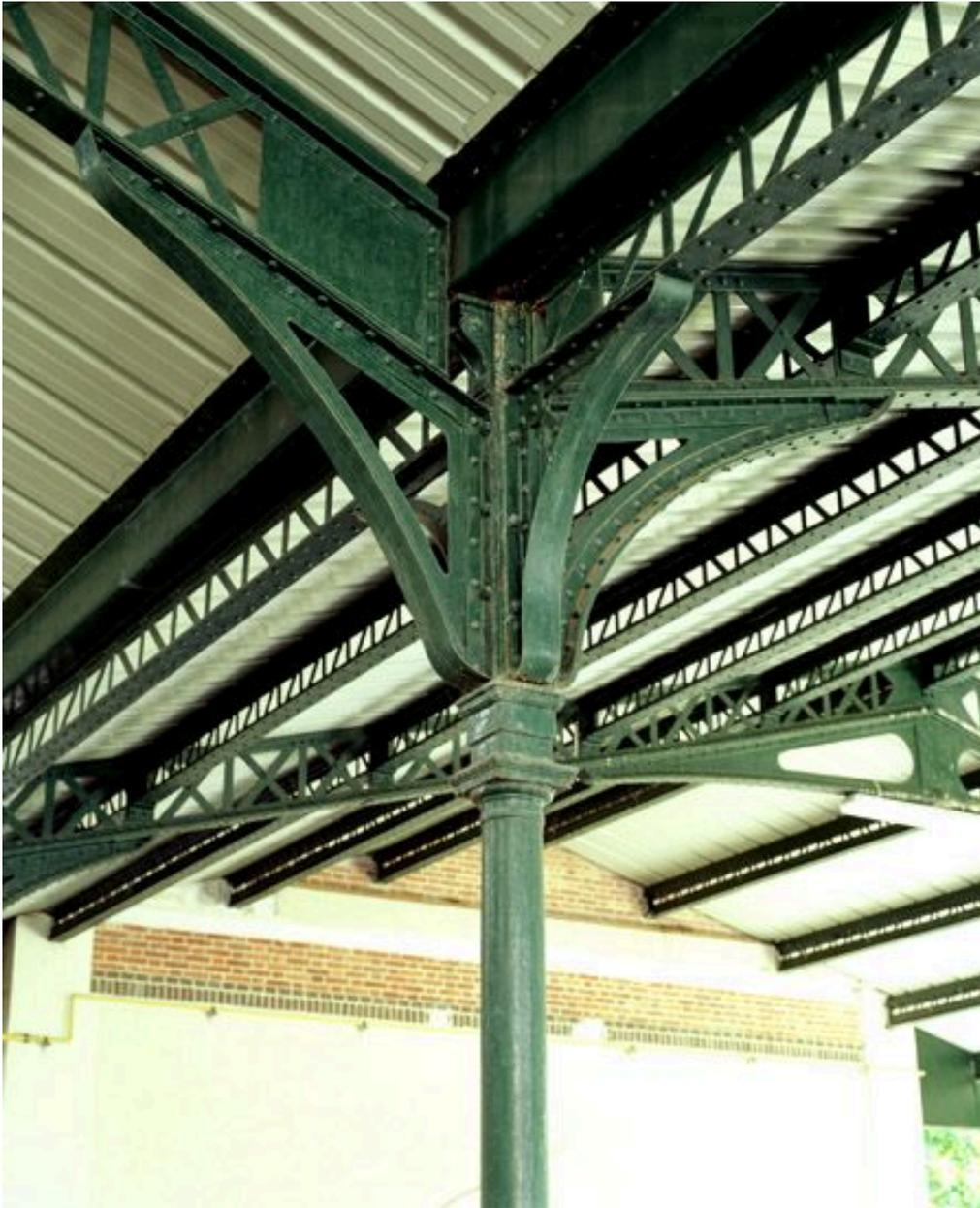
Détail de la charpente métallique du préau.
