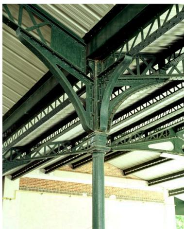
Détail de la charpente métallique du préau.
