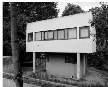
Vue de la maison de gardien à l'entrée de la propriété. Phot. Vialles Jean-Bernard IVR11_19967800320X
