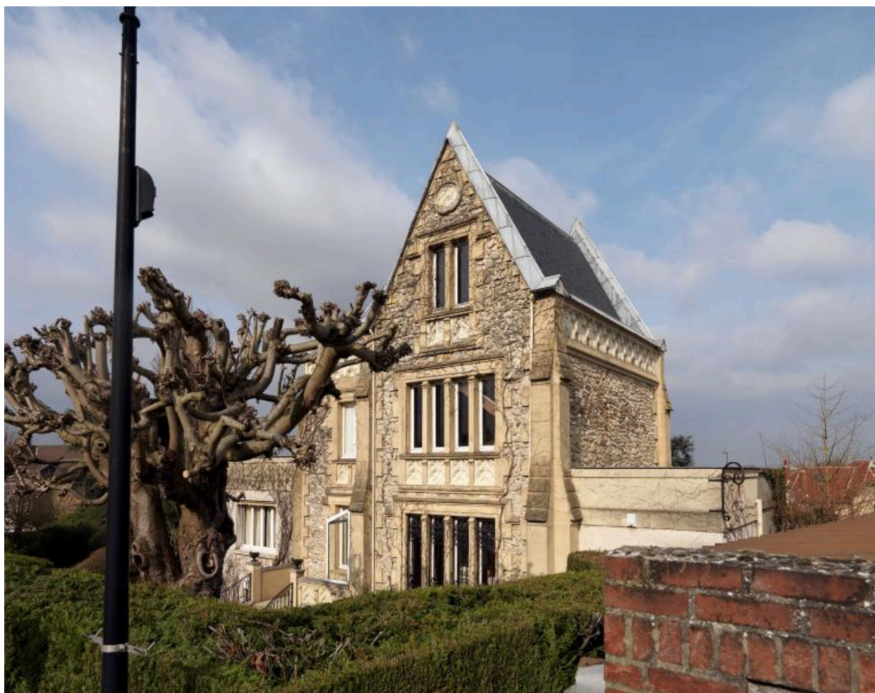
Villa néo-gothique, 36 rue Paul-Lorillon (anciennement 30 rue d'Ézanville), maison et atelier du peintre Dansaert : vue depuis la rue.
