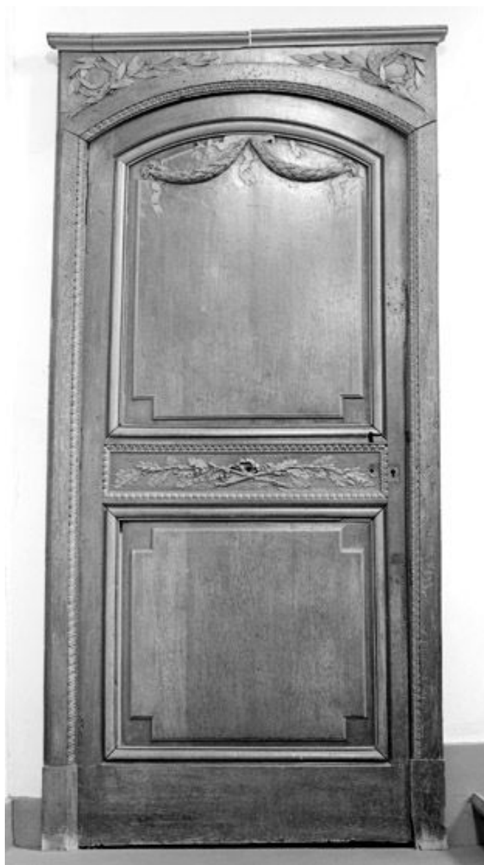
Vue d'ensemble de l'une des deux portes.
