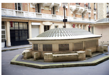
Vue du lanterneau situé au fond de la cour. Phot. Laurent Kruszyk IVR11_20157500692NUC4A
