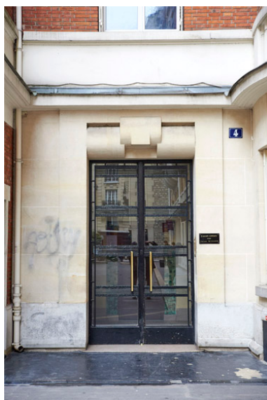
Vue de la porte du n °4 square Delormel. IVR11_20157500685NUC4A
