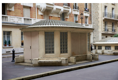
Vue du lanterneau situé à l'entrée du square Delormel. Phot. Laurent Kruszyk IVR11_20157500694NUC4A
