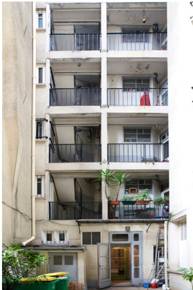
Vue de la façade sur cour du n°1. Phot. Laurent Kruszyk IVR11_20157500715NUC4A
