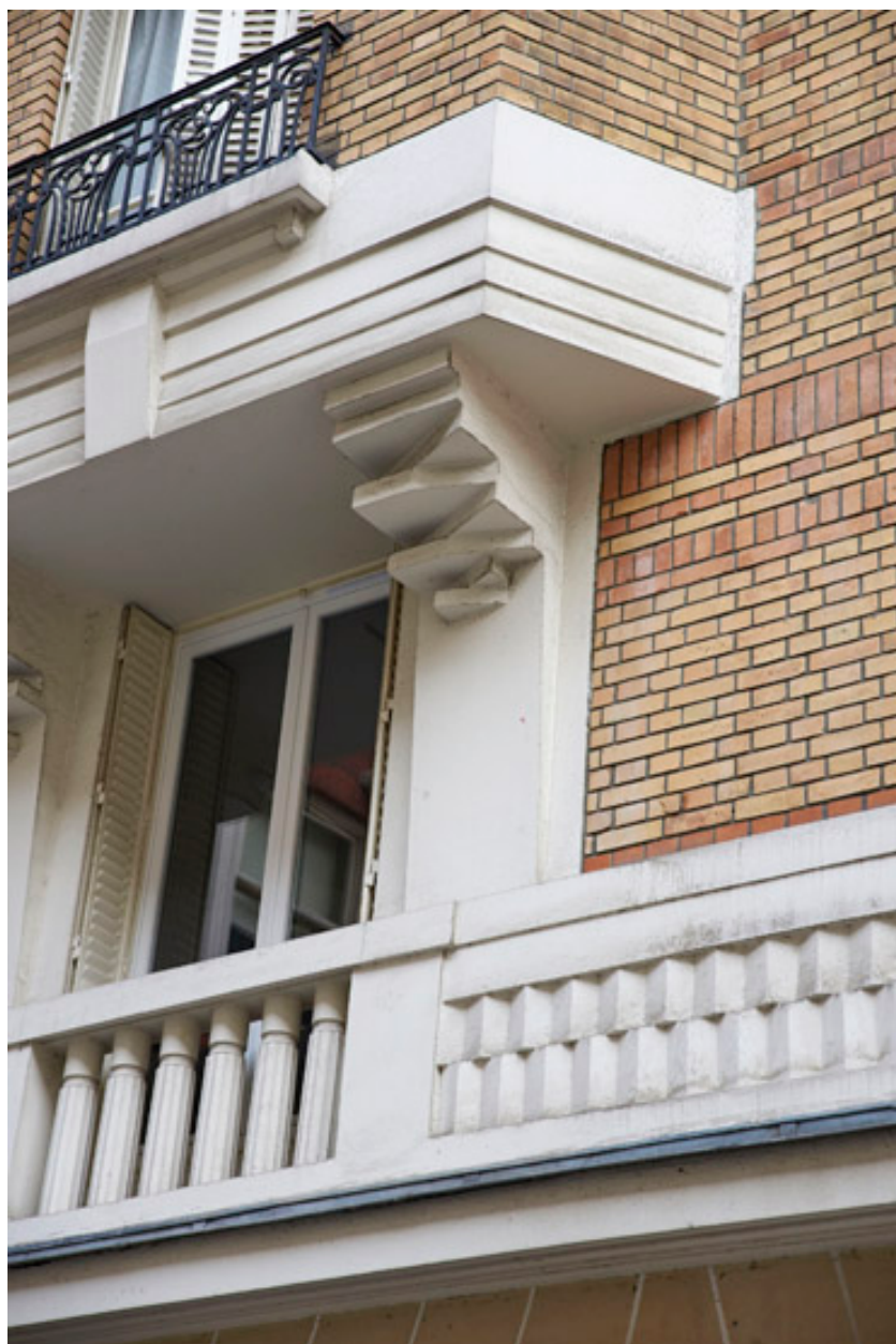
Vue de l'encorbellement d'un bow window.
