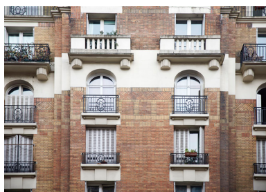
Vue des balcons des immeubles coté gauche. Phot. Laurent Kruszyk IVR11_20157500706NUC4A
