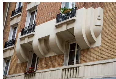
Vue d'un encorbellement de bow window. IVR11_20157500699NUC4A
