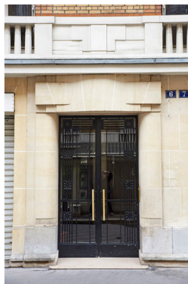
Vue de la porte du n °6/7 square Delormel. IVR11_20157500683NUC4A
