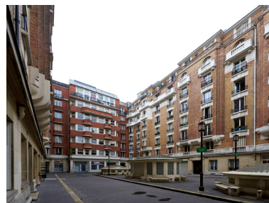
Vue générale des immeubles du côté droit et de l'immeuble du fond du square Delormel. Phot. Laurent Kruszyk IVR11_20157500702NUC4A
