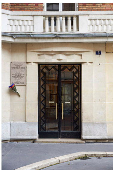
Vue de la porte du n °5 square Delormel. IVR11_20157500684NUC4A
