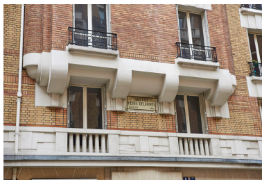
Vue de l'encorbellement d'un bow window IVR11_20157500698NUC4A
