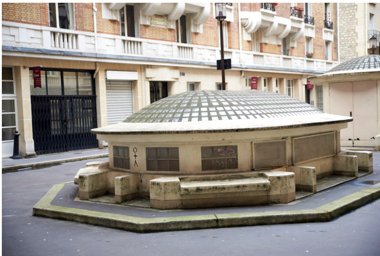
Vue du lanterneau situé au fond de la cour.
