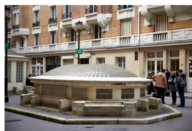
Vue du lanterneau situé à l'entrée du square Delormel. Phot. Laurent Kruszyk IVR11_20157500693NUC4A
