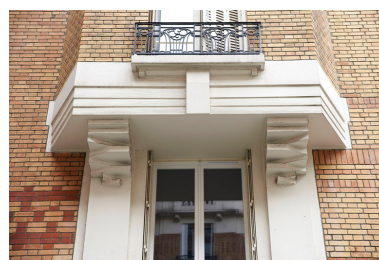
Vue de la ferronnerie d'un balcon. IVR11_20157500696NUC4A
