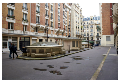
Vue du square Delormel prise depuis le fond de la cour. Phot. Laurent Kruszyk IVR11_20157500691NUC4A
