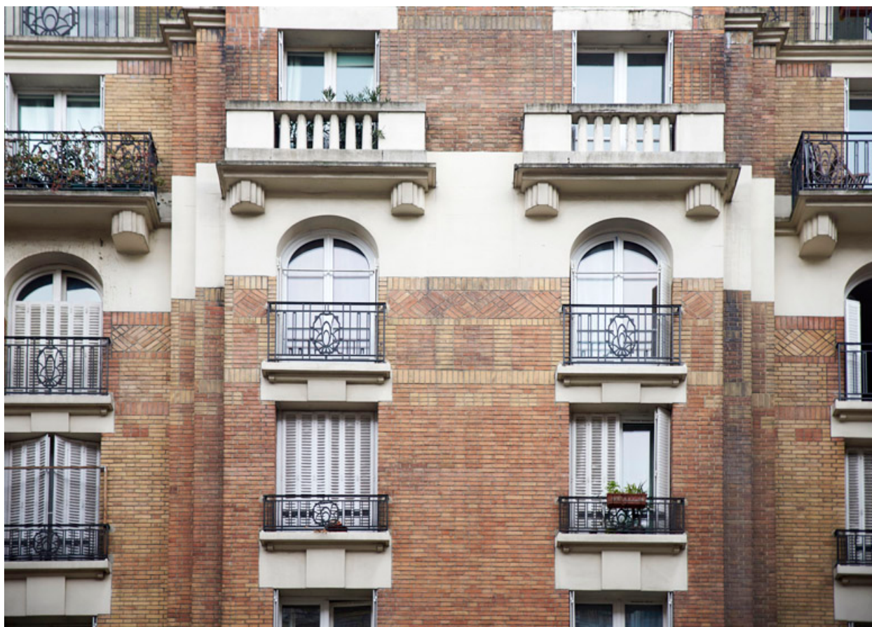
Vue des balcons des immeubles coté gauche.
