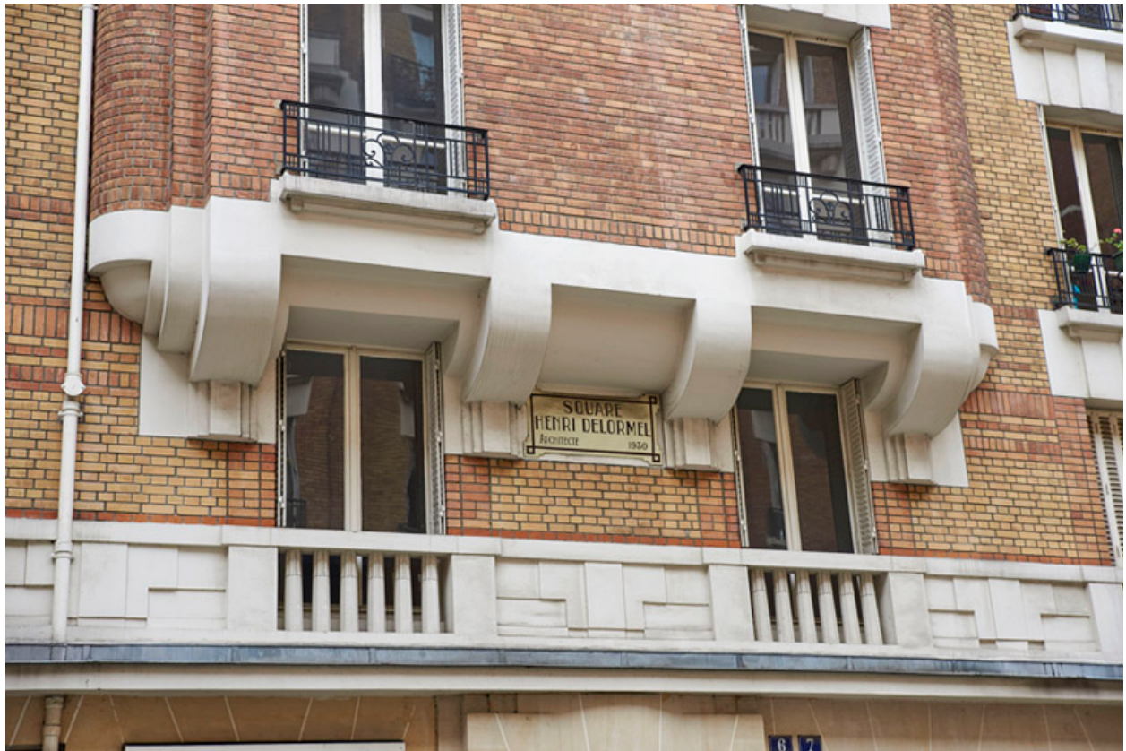
Vue de l'encorbellement d'un bow window
