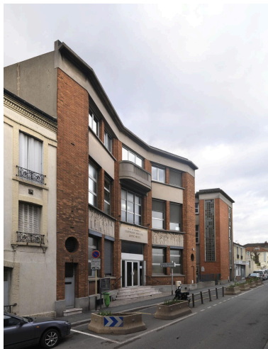
Vue de la façade principale. Phot. Laurent Kruszyk IVR11_20099300260NUC4A
