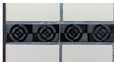
Détail du décor. Carreaux de céramique. Phot. Jean-Bernard Vialles IVR11_20089300274NUC4A
