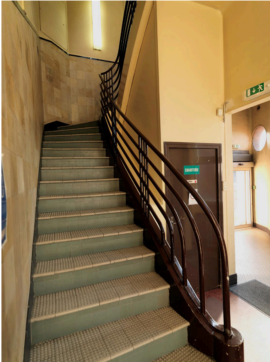
Vue de l'escalier intérieur.
