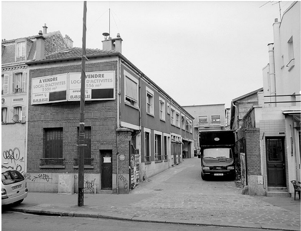
Entrée de l'usine de petite métallurgie Raynaud, 206 rue de Paris.
