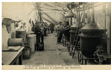
Laboratoire de dissolution et de préparation des caoutchoucs de l'usine de toiles cirées Caplain, 29, rue de l'Ermitage, vers 1920. Carte postale. (Musée de l'histoire vivante, Montreuil. 7 F 80) IVR11_20029300039NUCA
