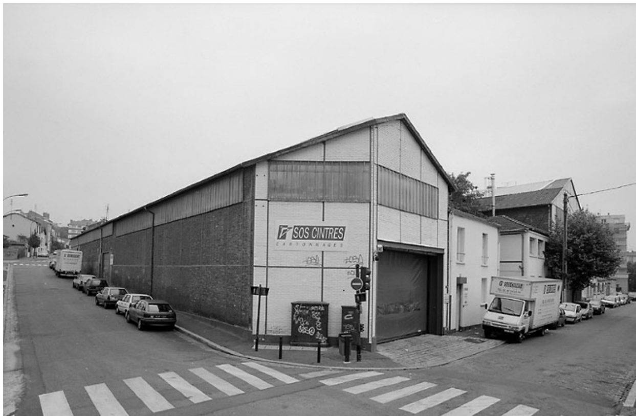
Vue générale de l'usine de transformation des métaux CICT, 37, boulevard Jeanne-d'Arc.
