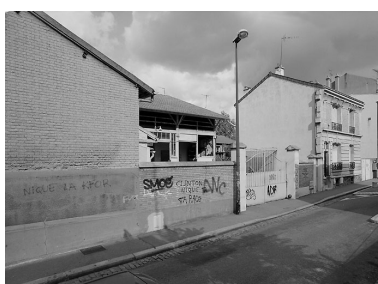
vue de l'entrepôt du 36, rue Parmentier. Phot. Jean-Bernard Vialles IVR11_20019300326X
