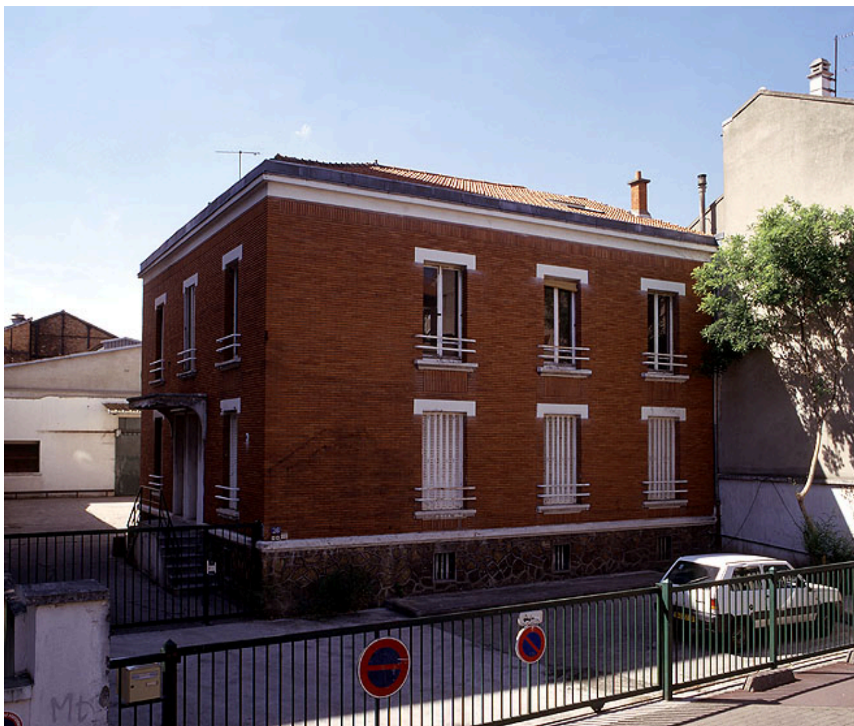
Vue de l'entrée et des bureaux de la menuiserie Goniche, 24, rue de la Fédération.
