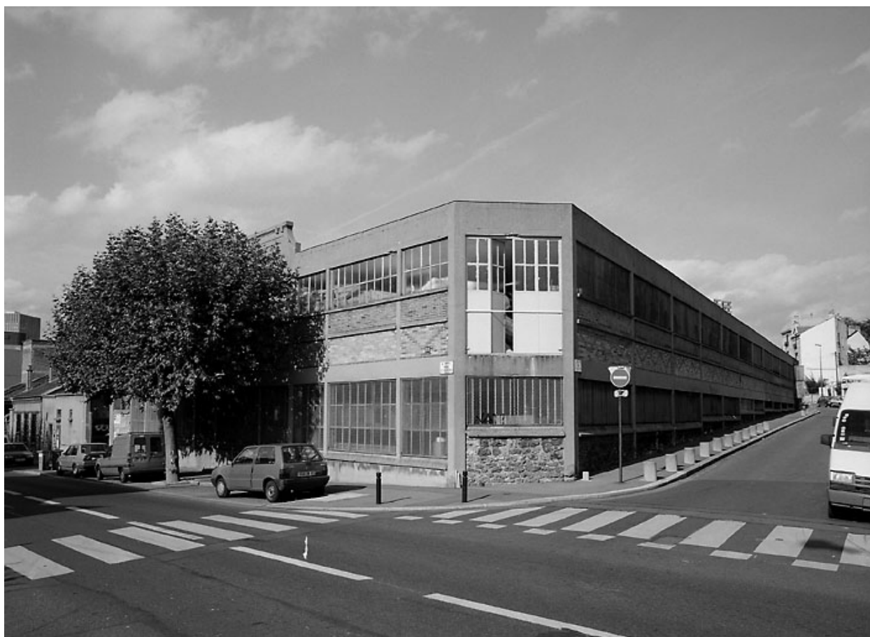
Vue générale de l'usine de soufre Eco et Lora, 97, rue de Stalingrad, depuis le carrefour des Parapluies.
