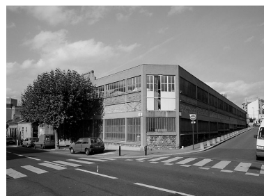
Vue générale de l'usine de soufre Eco et Lora, 97, rue de Stalingrad, depuis le carrefour des Parapluies. Phot. Jean-Bernard Vialles IVR11_20019300292X
