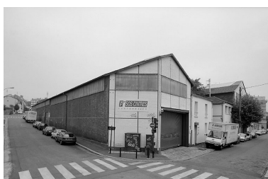
Vue générale de l'usine de transformation des métaux CICT, 37, boulevard Jeanne-d'Arc. Phot. Jean-Bernard Vialles IVR11_20019300373X
