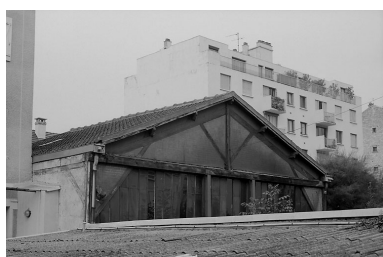
L'atelier de l'usine de fabrication d'instruments de mesure Gibrat, vu de la rue Douy Delcupé. Phot. Jean-Bernard Vialles IVR11_20019300371X
