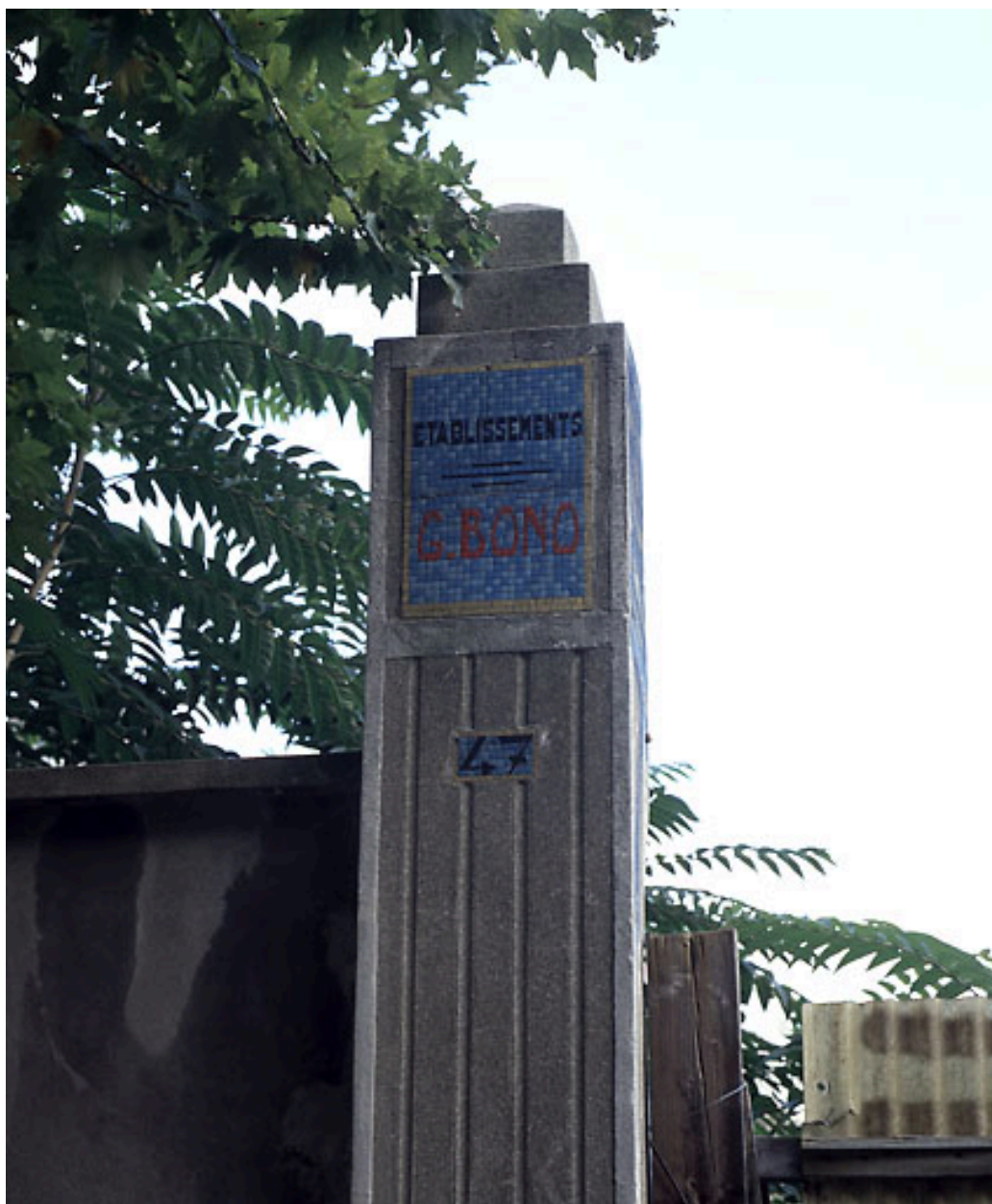
Détail de l'entrée de l'usine métallurgique Bono.
