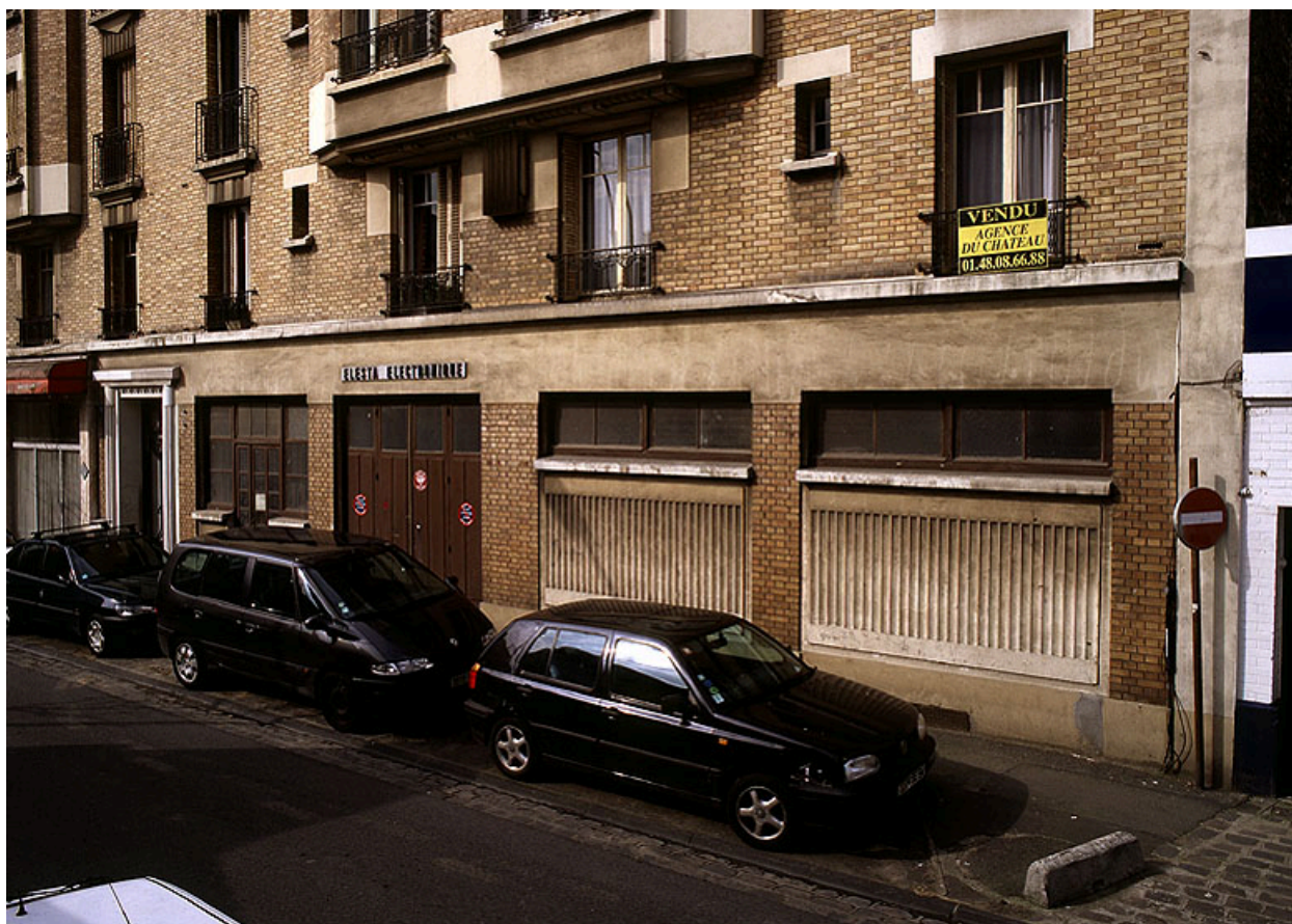
Vue de détail de la façade de la biscuiterie La Moussette.
