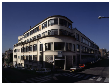
Vue générale depuis l'angle de l'avenue Faidherbe et de la rue des Caillots. Phot. Jean-Bernard Vialles IVR11_20019300410XA
