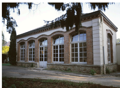
Vue de l'orangerie. Phot. Stéphane Asseline IVR11_20017800024XA
