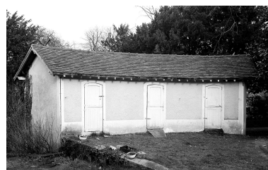
Vue de l'écurie à ânes. Phot. Christian Décamps IVR11_20007800121X
