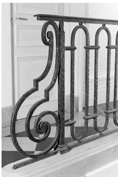
L'escalier principal : détail d'un des repos.
