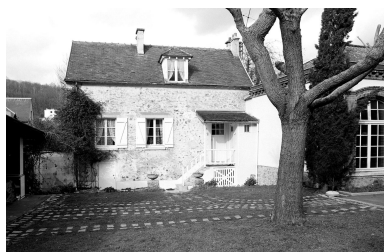
Vue de la maison de jardinier. Phot. Christian Décamps IVR11_20007800122X
