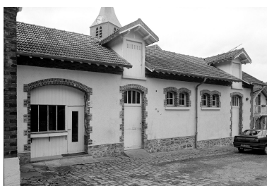
Les anciens communs du château. Phot. Christian Décamps IVR11_20007800124X
