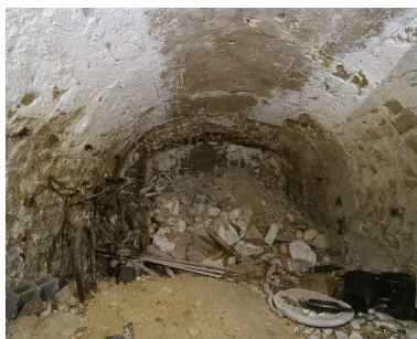
La cave voûtée dont une partie passe sous la rue des Courcieux. Phot. Laurent Kruszyk IVR11_20067800905XA
