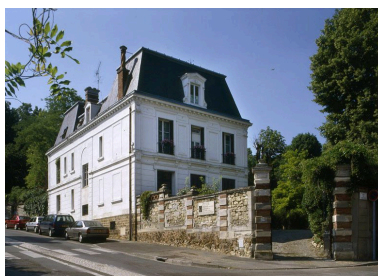
La façade sur rue. Phot. Laurent Kruszyk IVR11_20067800901XA
