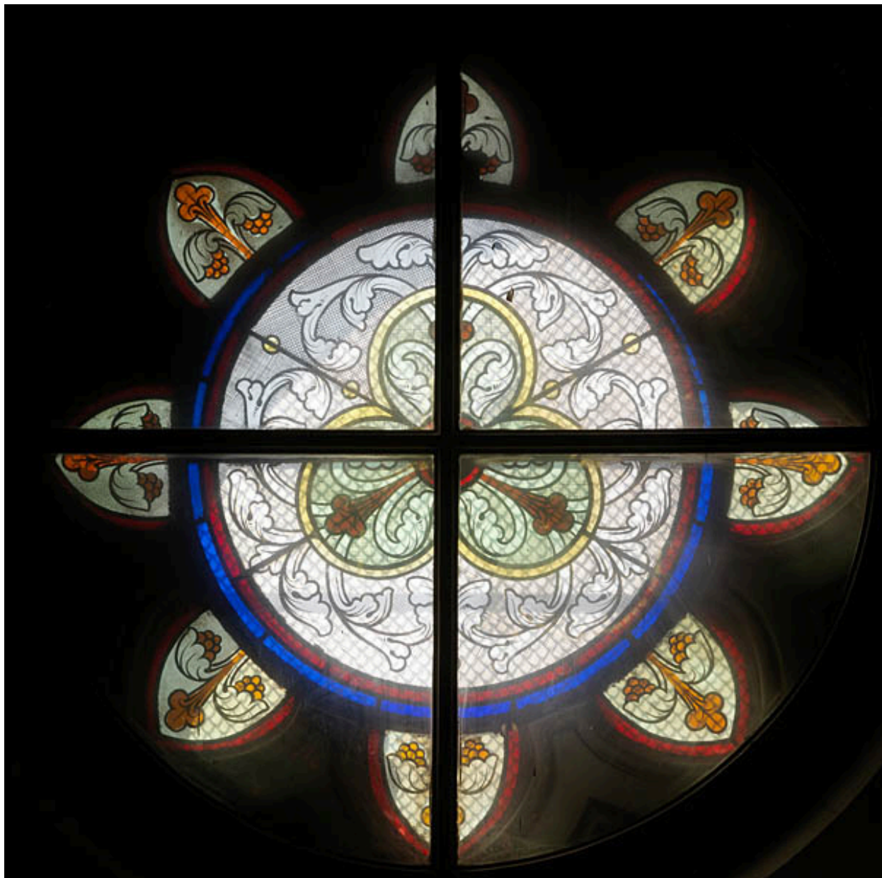
Rose de façade avec vitrerie ornemental néo-XIIIe, à rinceaux de grisaille et filets et fermaillets de couleur, vers 1874. auteur inconnu (peintre-verrier)
