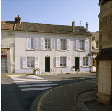
Façade principale. Phot. Laurent Kruszyk IVR11_20077800062XA
