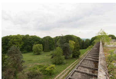
pavillon Bonnefoy-Sibour, vue prise depuis le dernier toit, vers l'ouest Phot. Philippe Ayrault IVR11_20199500048NUC4A
