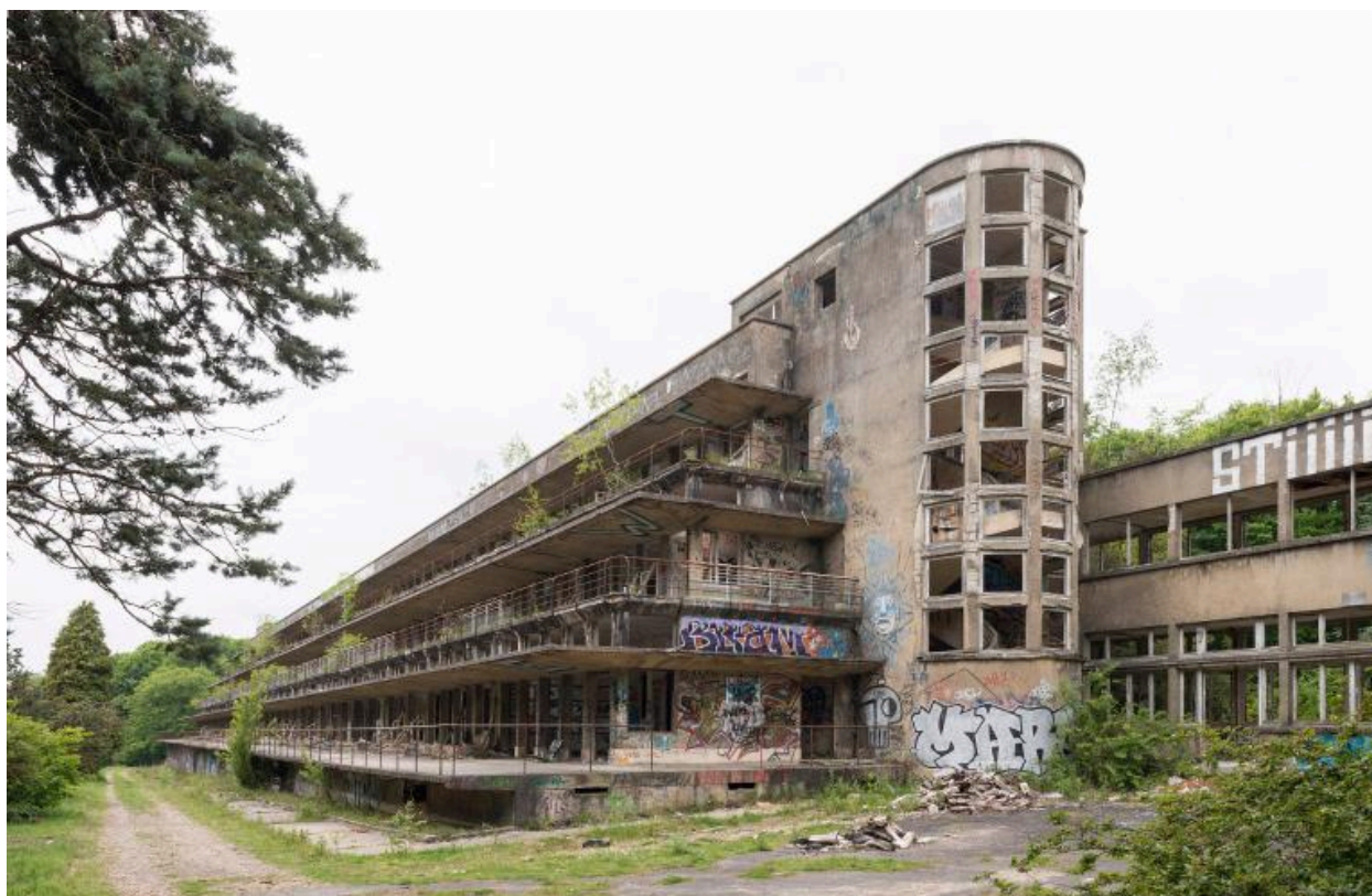
pavillon Bonnefoy-Sibour, façade sud (1)
