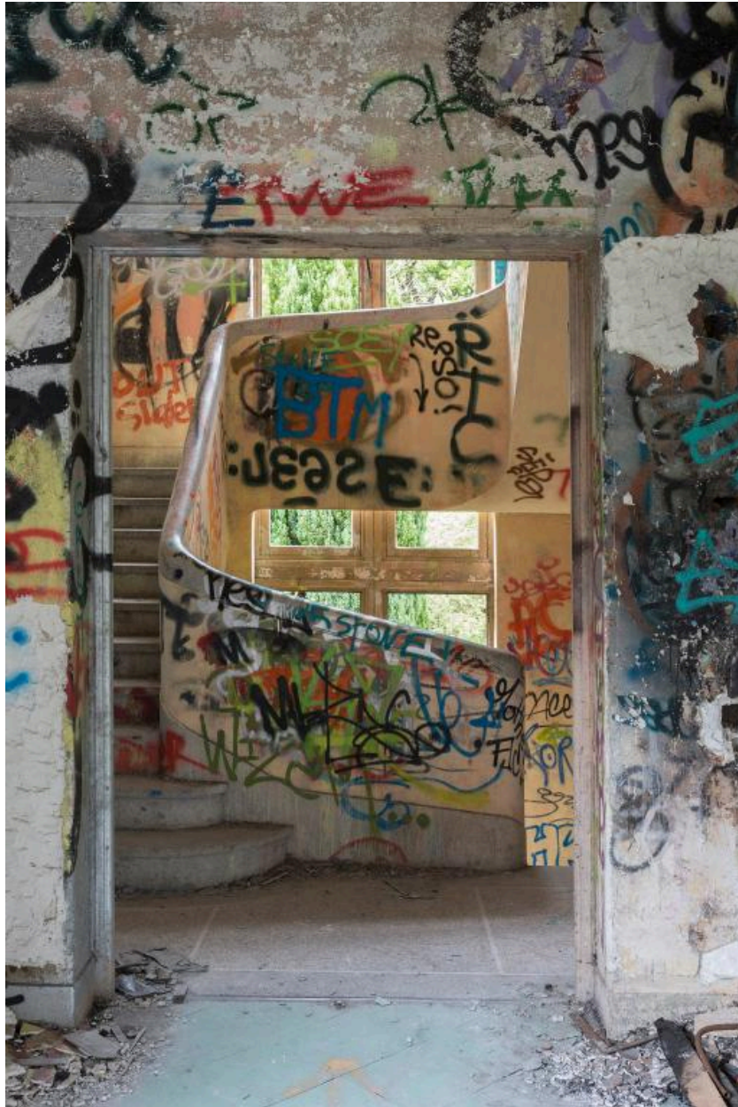
pavillon Bonnefoy-Sibour, vue de l'escalier secondaire situé à l'extrémité de la salle de spectacle
