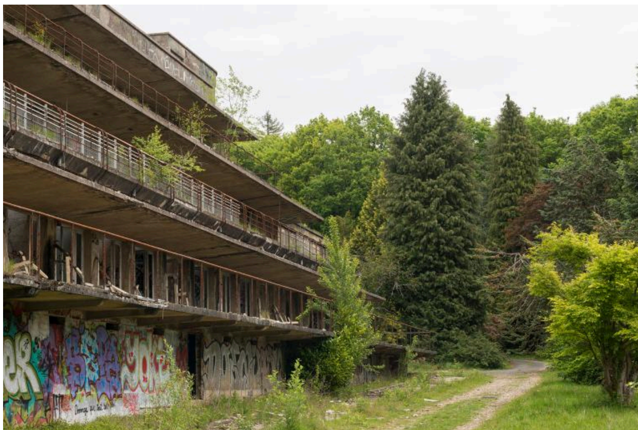
pavillon Bonnefoy-Sibour, façade sud (3)
