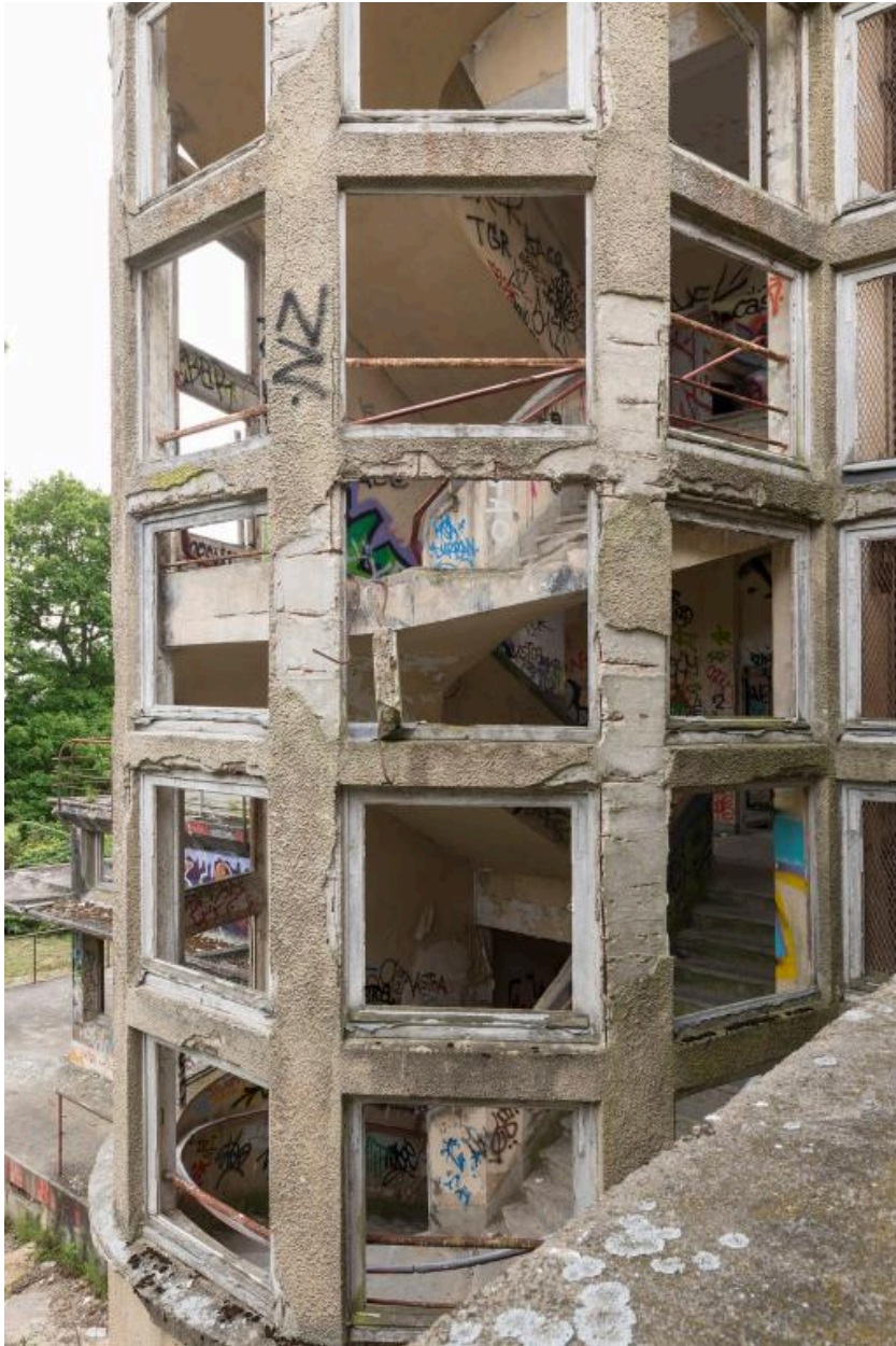
pavillon Bonnefoy-Sibour, vue de la cage d'escalier situé à l'ouest de la façade sud
