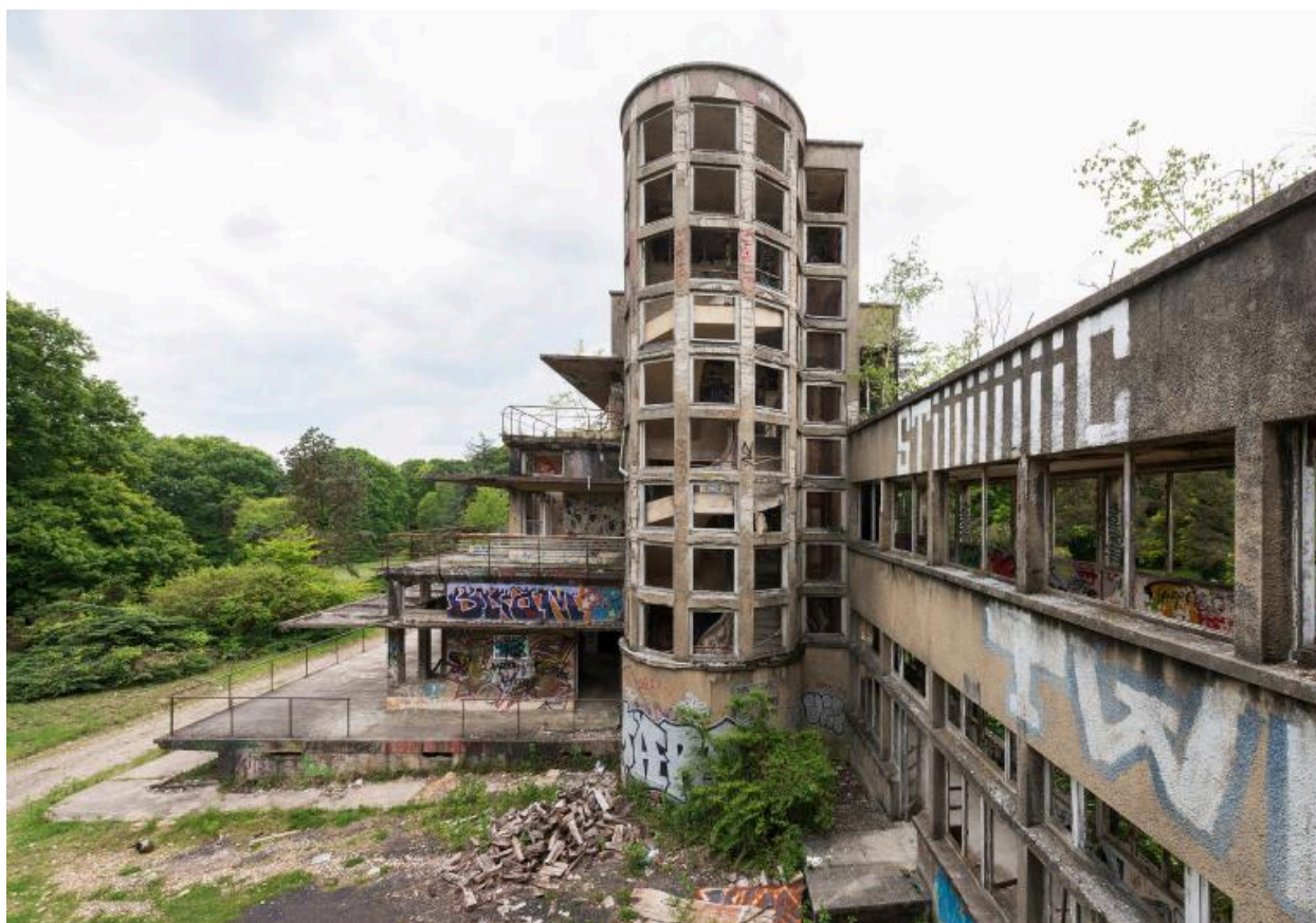
pavillon Bonnefoy-Sibour, façade sud, vue de la tour-escalier côté ouest
