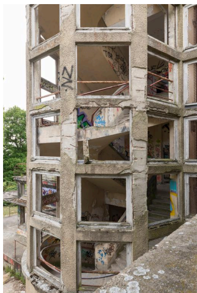
pavillon Bonnefoy-Sibour, vue de la cage d'escalier situé à l'ouest de la façade sud Phot. Philippe Ayrault IVR11_20199500041NUC4A
