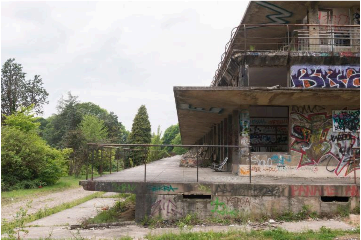
pavillon Bonnefoy-Sibour, façade sud
