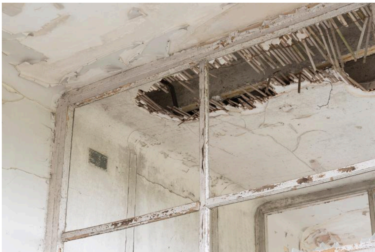
pavillon Bonnefoy-Sibour, détail du latis de châtaigner (plafond d'une chambre)
