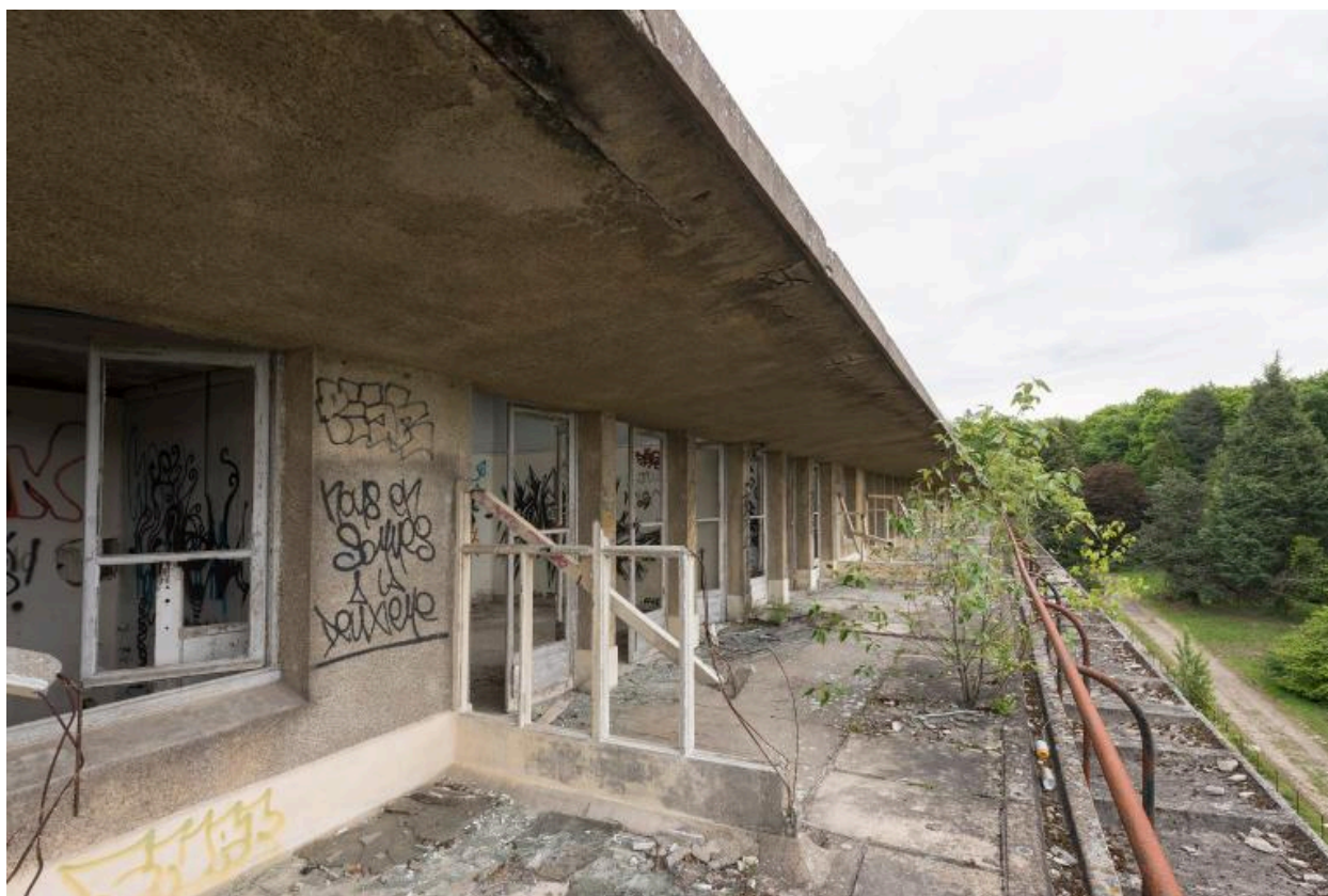
pavillon Bonnefoy-Sibour, vue de la terrasse du dernier étage, côté sud
