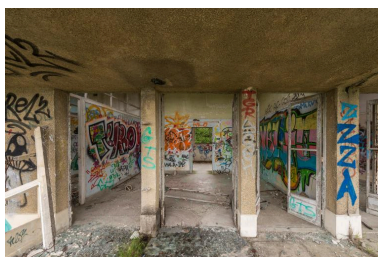
pavillon Bonnefoy-Sibour, vue d'une chambre depuis la terrasse Phot. Philippe Ayrault IVR11_20199500060NUC4A
