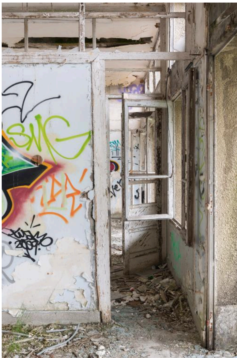
pavillon Bonnefoy-Sibour, enfilade entre plusieurs locaux techniques
