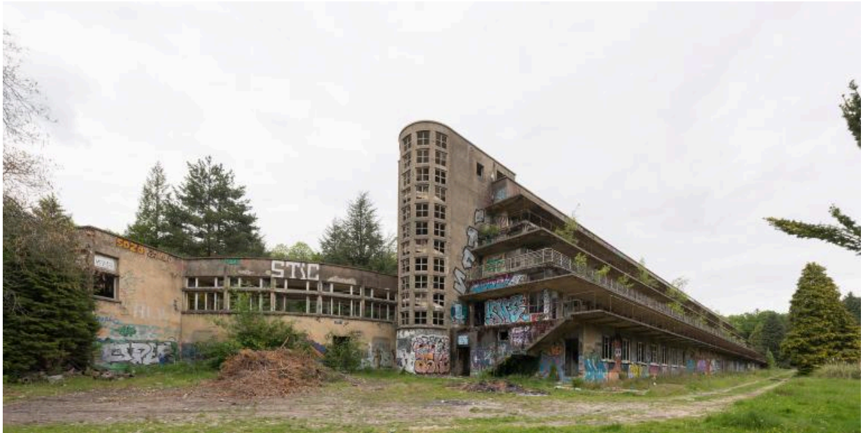
pavillon Bonnefoy-Sibour, extrémité sud-ouest de la façade sud
