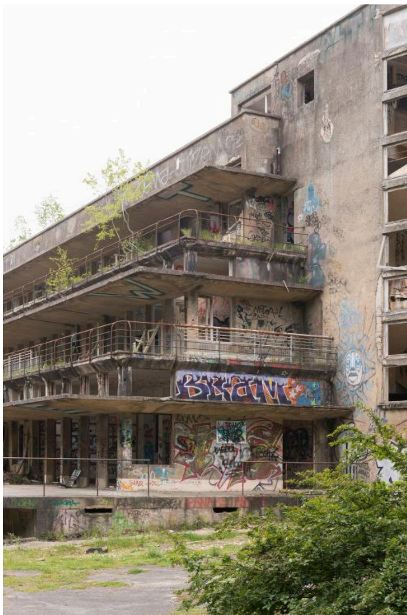
pavillon Bonnefoy-Sibour, façade sud (4)
