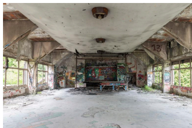
pavillon Bonnefoy-Sibour, vue de la salle de spectacle Phot. Philippe Ayrault IVR11_20199500053NUC4A
