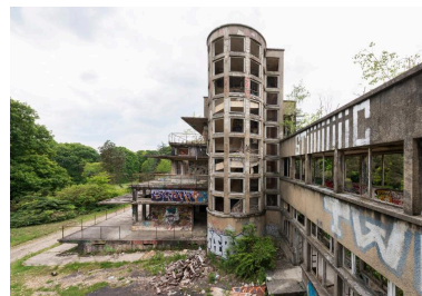
pavillon Bonnefoy-Sibour, façade sud, vue de la tour-escalier côté ouest Phot. Philippe Ayrault IVR11_20199500040NUC4A
