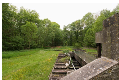
bassin d'épuration : éléments sortant de la fosse de digestion, avant passage en bac de nitrification Phot. Philippe Ayrault IVR11_20199500023NUC4A
