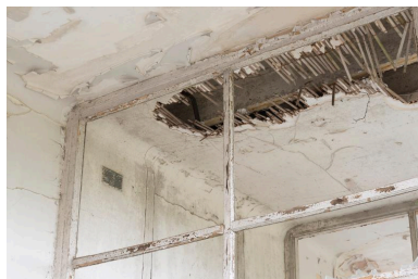
pavillon Bonnefoy-Sibour, détail du latis de châtaigner (plafond d'une chambre) Phot. Philippe Ayrault IVR11_20199500062NUC4A
