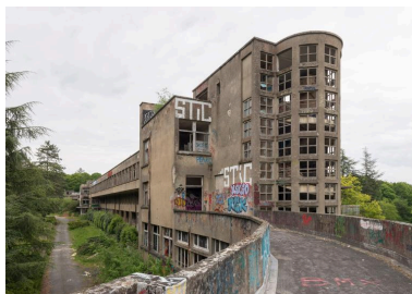
pavillon Bonnefoy-Sibour, vue prise du toit-terrasse vers l'est Phot. Philippe Ayrault IVR11_20199500045NUC4A
