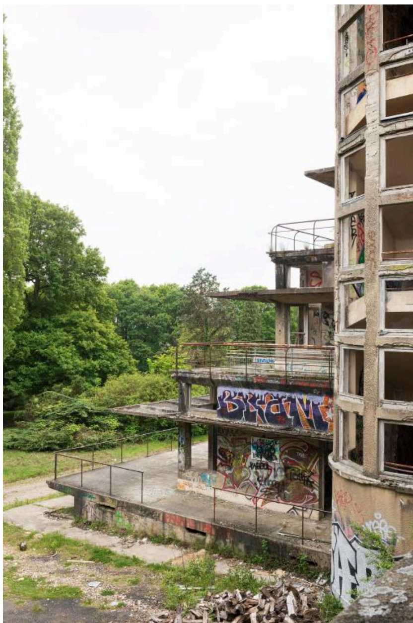
pavillon Bonnefoy-Sibour, façade sud (5)
