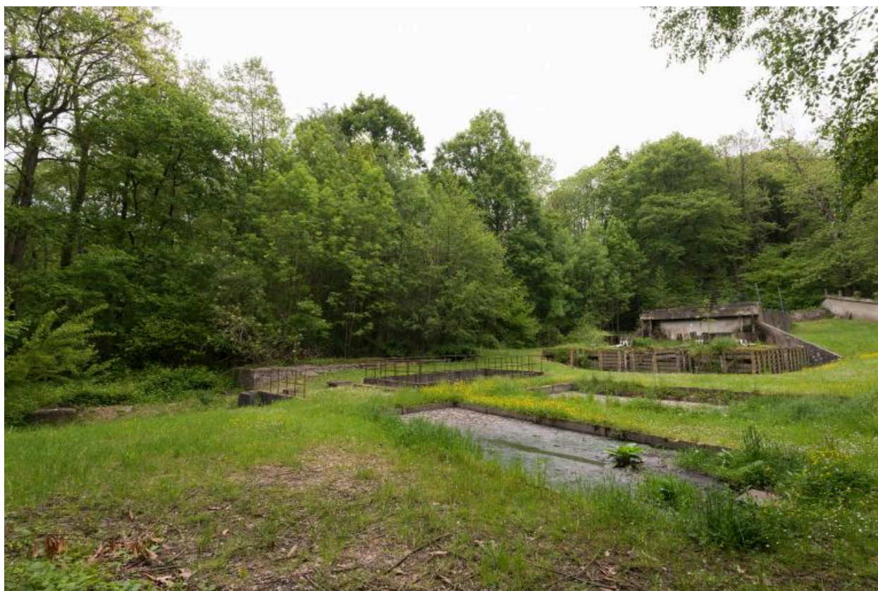
Vue générale du bassin d'épuration
