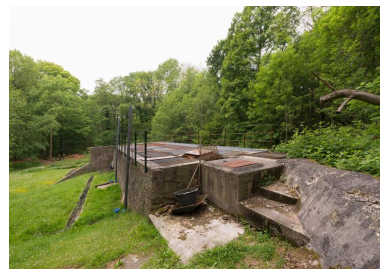
bassin d'épuration : 1er plan : dégrilleur sommaire et pubelle évacuant les déchets retenus par la grille Phot. Philippe Ayrault IVR11_20199500022NUC4A
