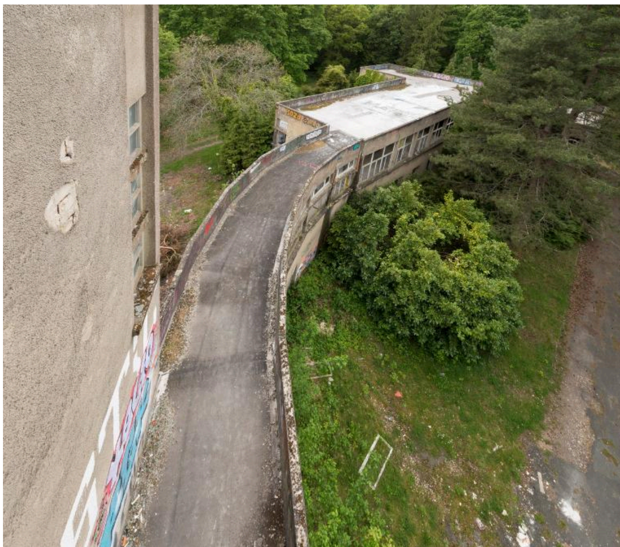
pavillon Bonnefoy-Sibour, vue prise depuis le toit vers l'extrémité ouest du bâtiment
