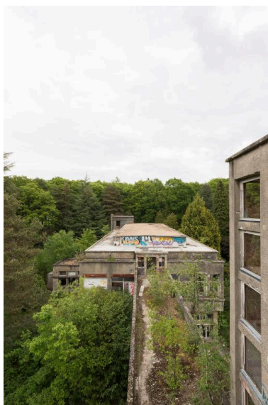
pavillon Bonnefoy-Sibour, vue du toit-terrasse vers l'est Phot. Philippe Ayrault IVR11_20199500042NUC4A
