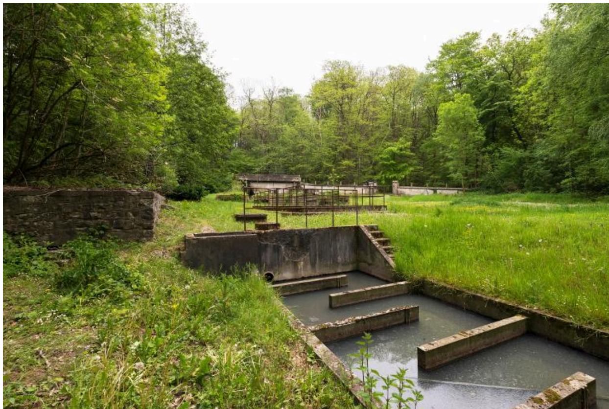
bassin d'épuration: bac de décantation, les murets servent à freiner la vitesse de l'eau
