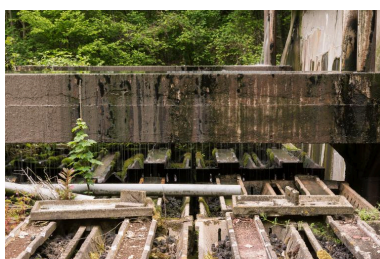
bassin d'épuration : vue de détail du bac de nitrification Phot. Philippe Ayrault IVR11_20199500024NUC4A
