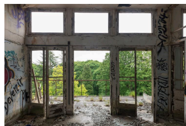
pavillon Bonnefoy-Sibour, vue prise depuis une chambre Phot. Philippe Ayrault IVR11_20199500061NUC4A
